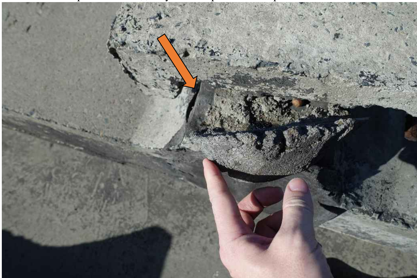
Фото 16. Не закрытый от осадков участок примыкания кровли.
