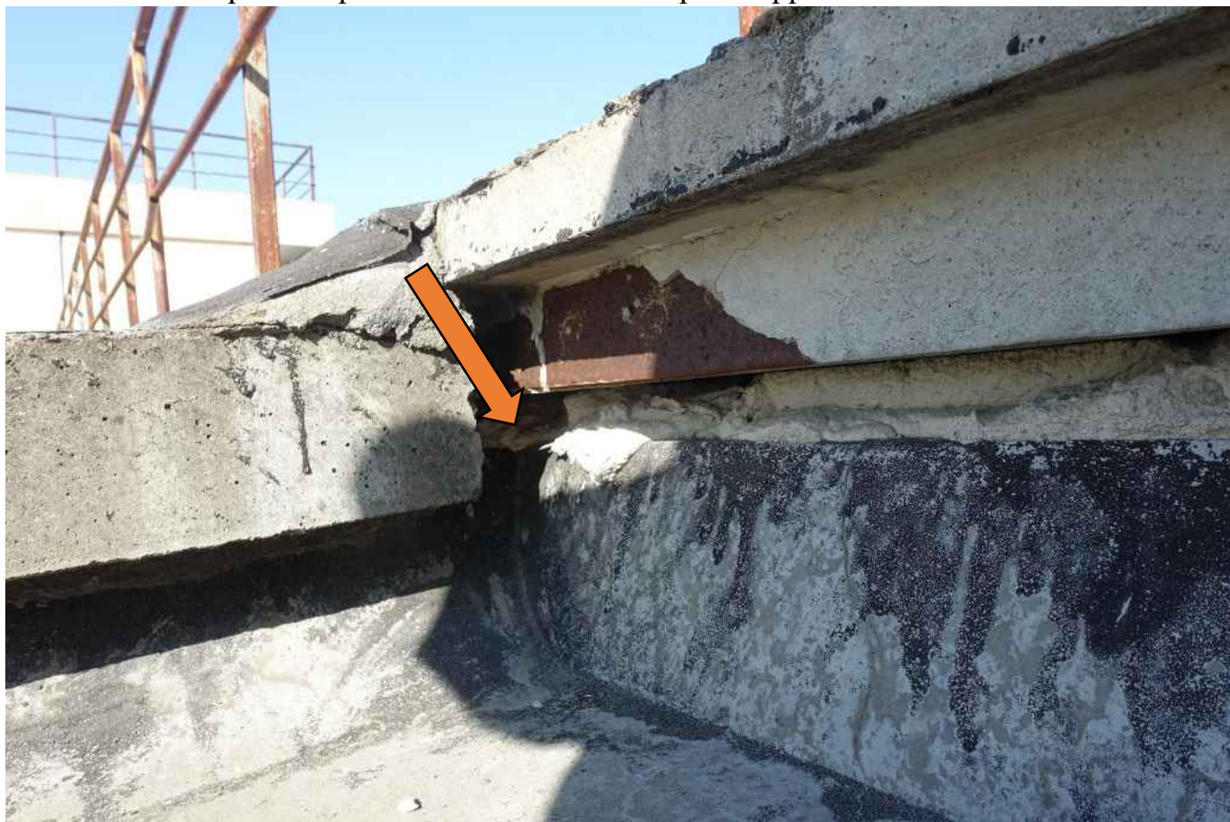
Фото 92. Не закрытое примыкание. Металл покрыт коррозией.
