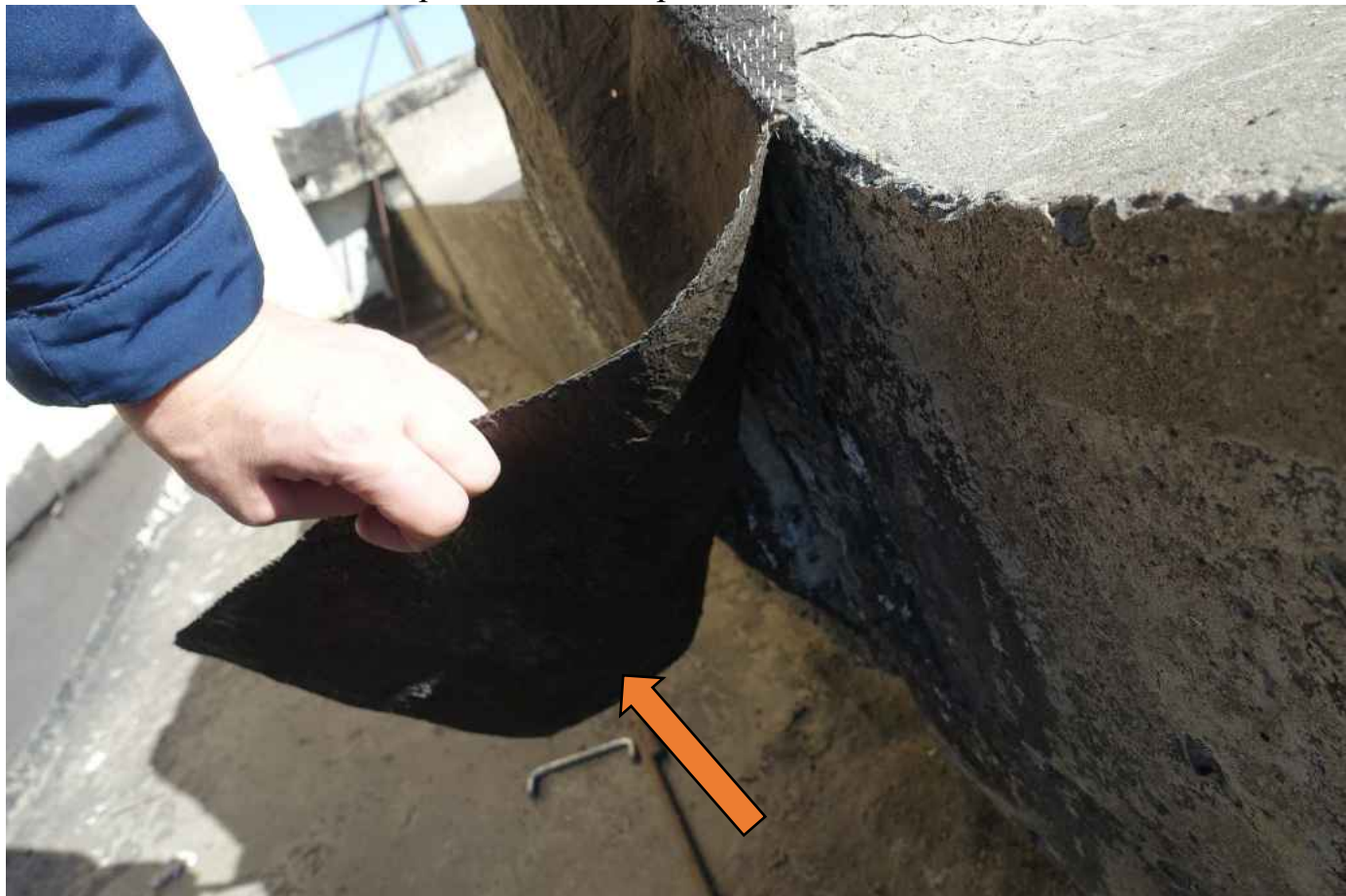
Фото 46. Не качественно проклеенная гидроизоляция.
