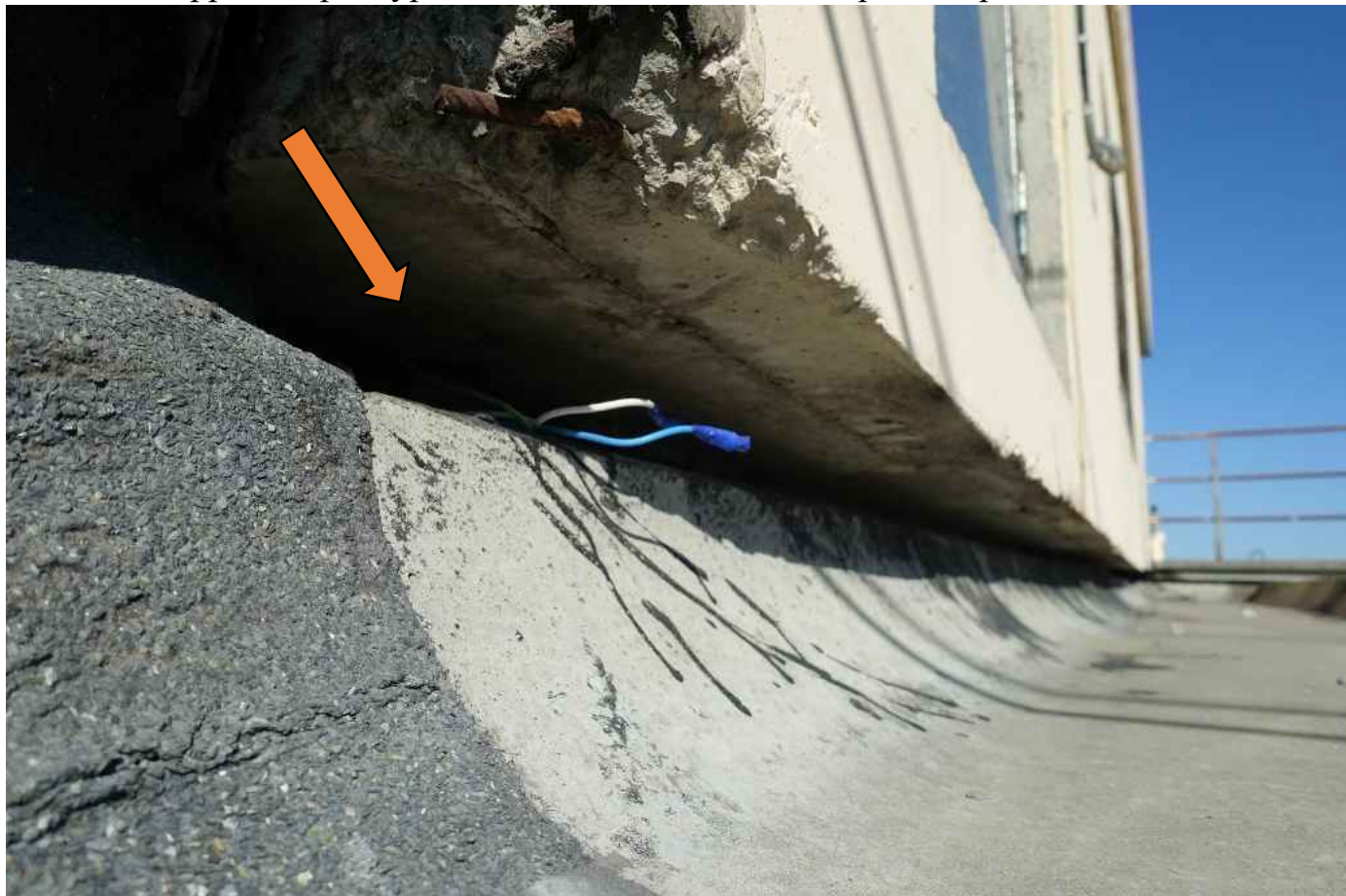
Фото 88. Не закрытое примыкание. Места попадания осадков.
