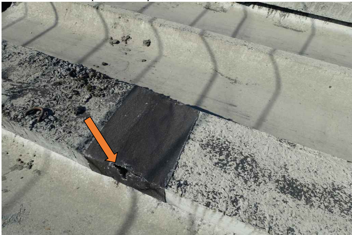
Фото 72. Место осмотра стыка. Повреждение.
