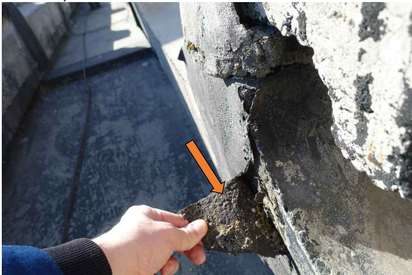
Фото 48. Гидроизоляция отходит от основания.
