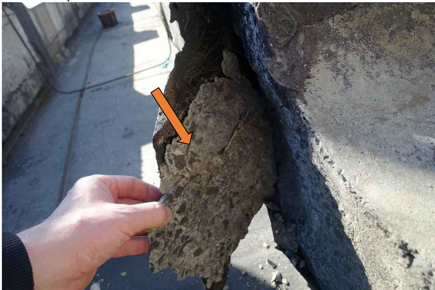
Фото 50. Гидроизоляция отслоилась вместе с бетонным основанием.
