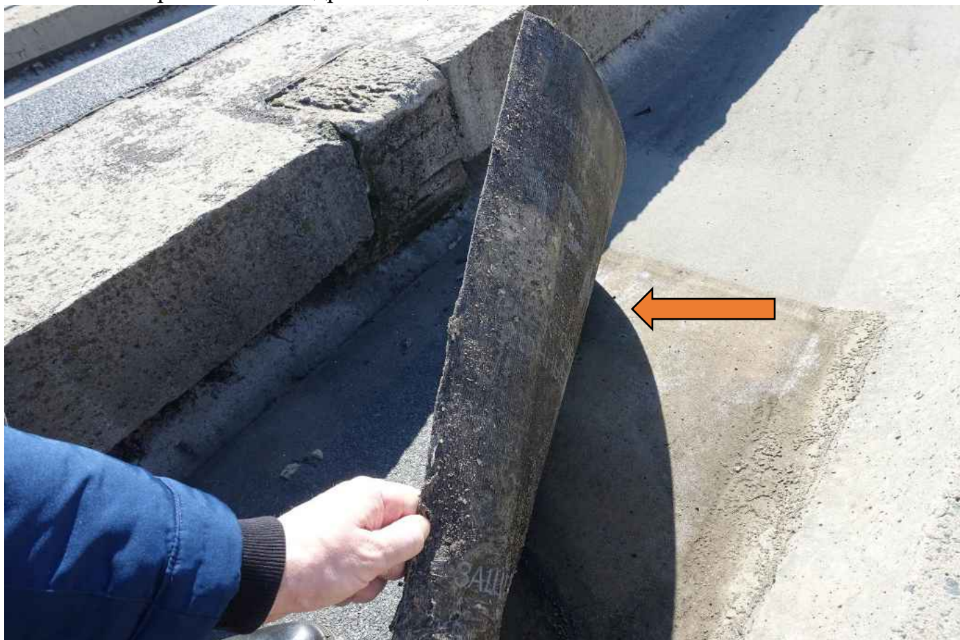
Фото 96. Гидроизоляция на стыках находится в неудовлетворительном состоянии.
