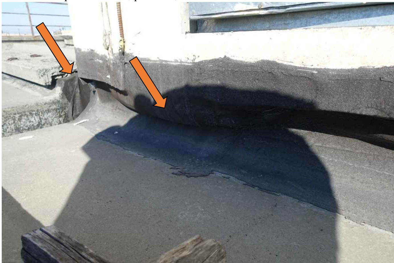
Фото 14. Не проклеенная гидроизоляция.
