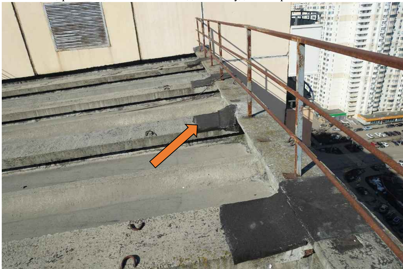
Фото 96. Гидроизоляция на стыках находится в неудовлетворительном состоянии.
