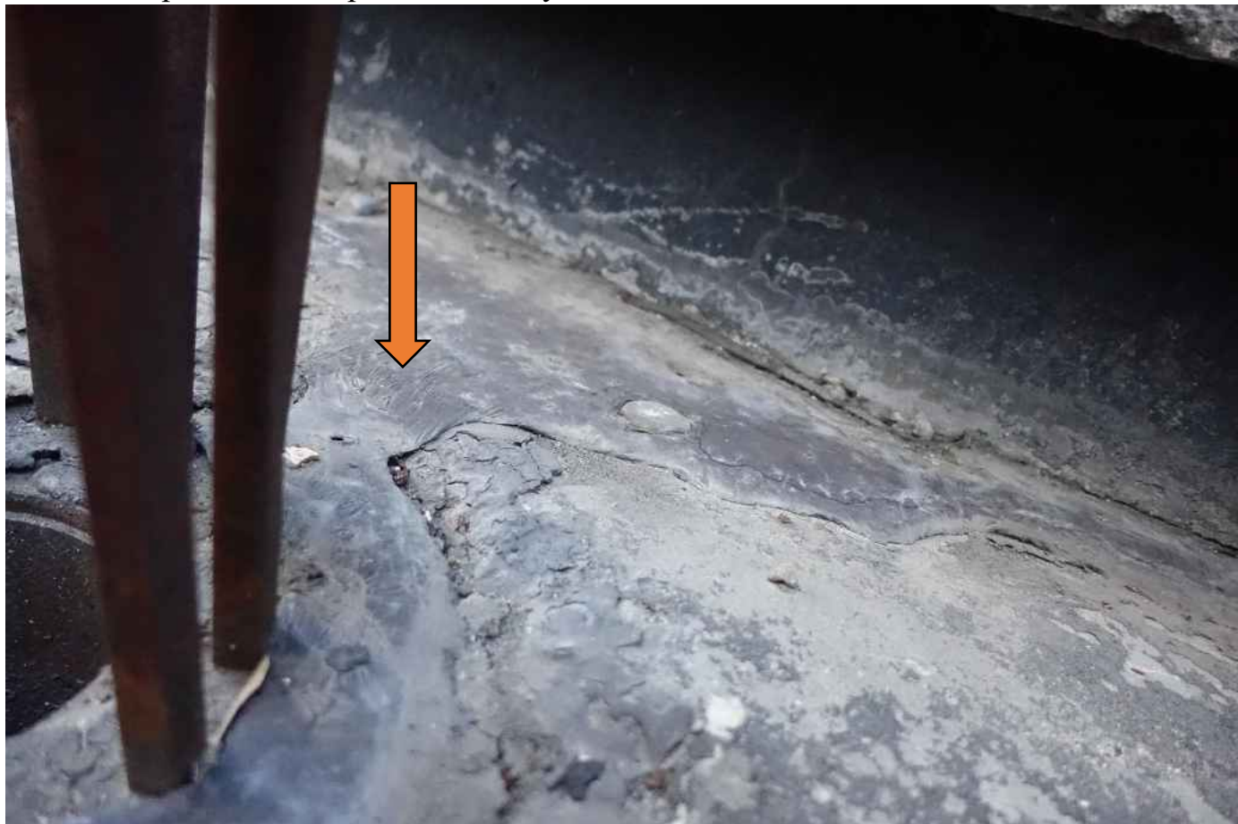
Фото 32. Не качественно проклеенная гидроизоляция.
