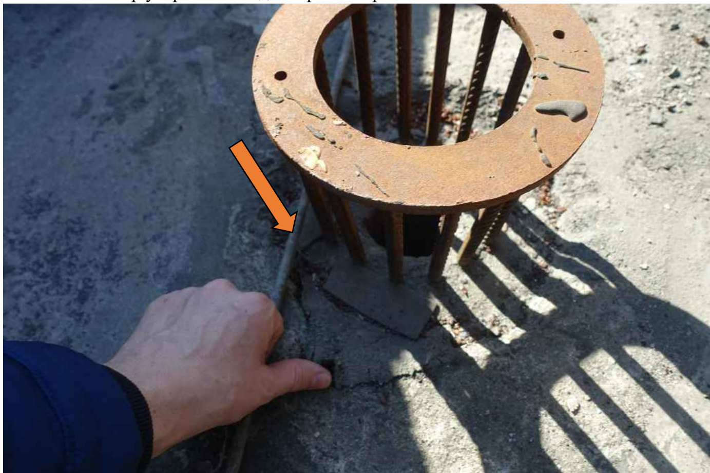
Фото 18. Гидроизоляция отходит от основания.
