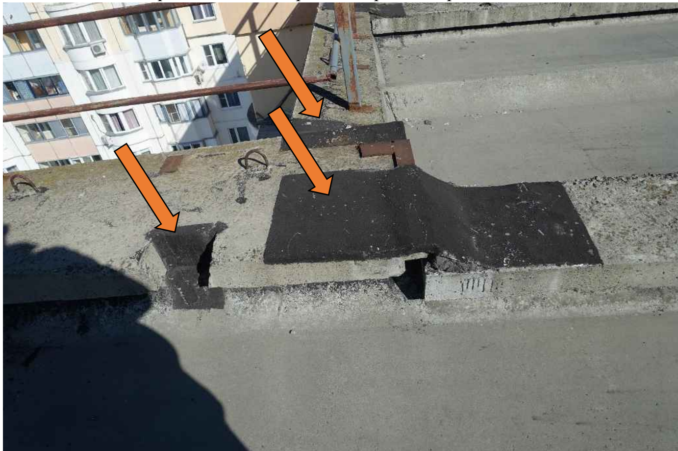
Фото 24. Общий вид кровли. Следы коррозии на металле.
