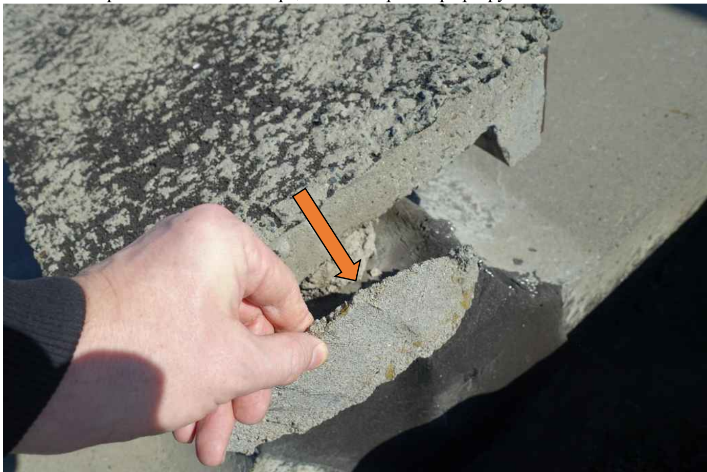
Фото 70. Устройство стыков на торцах плит из раствора разрушаются.
