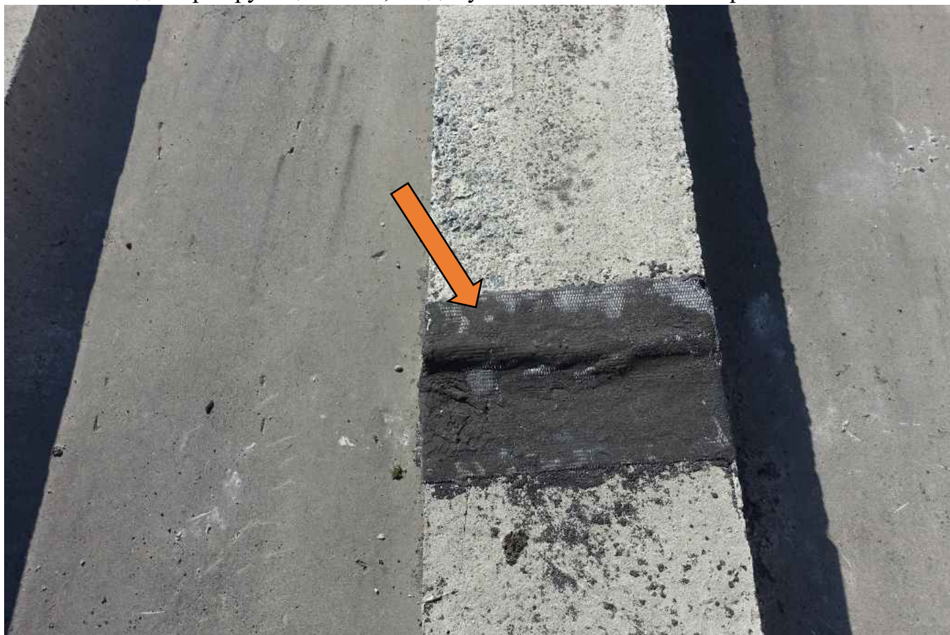
Фото 98. Виден армирующий слой, не допустимое состояние материала.
