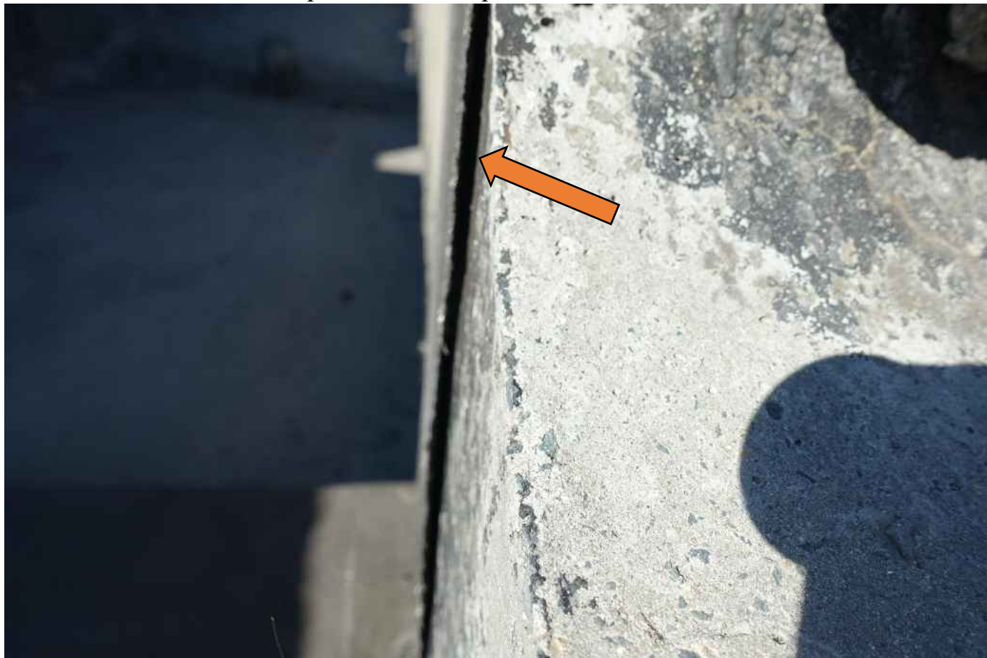
Фото 64. Не качественно проклеенная гидроизоляция.
