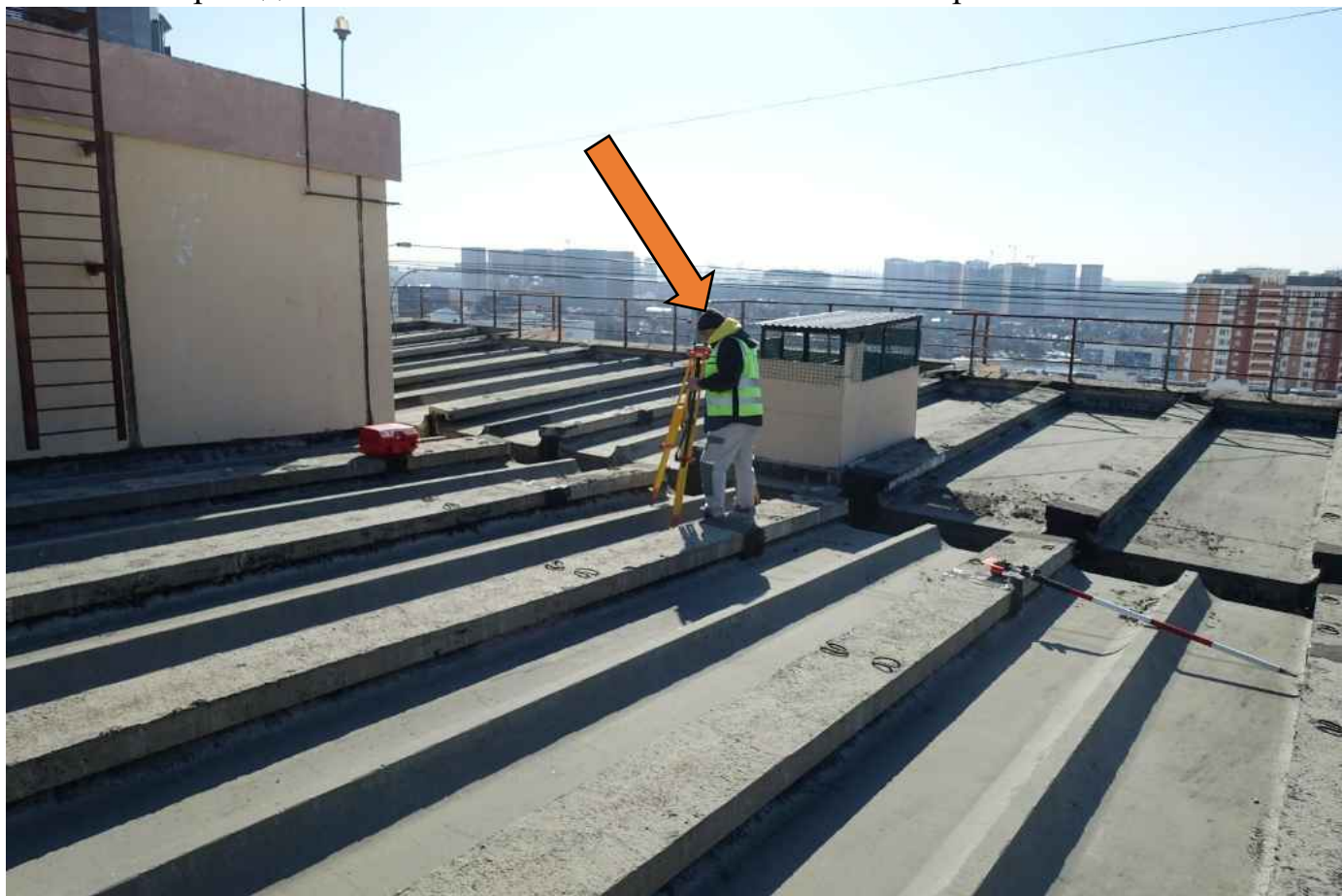
Фото 122. Проведение исполнительной геоэзической съемки кровли.
