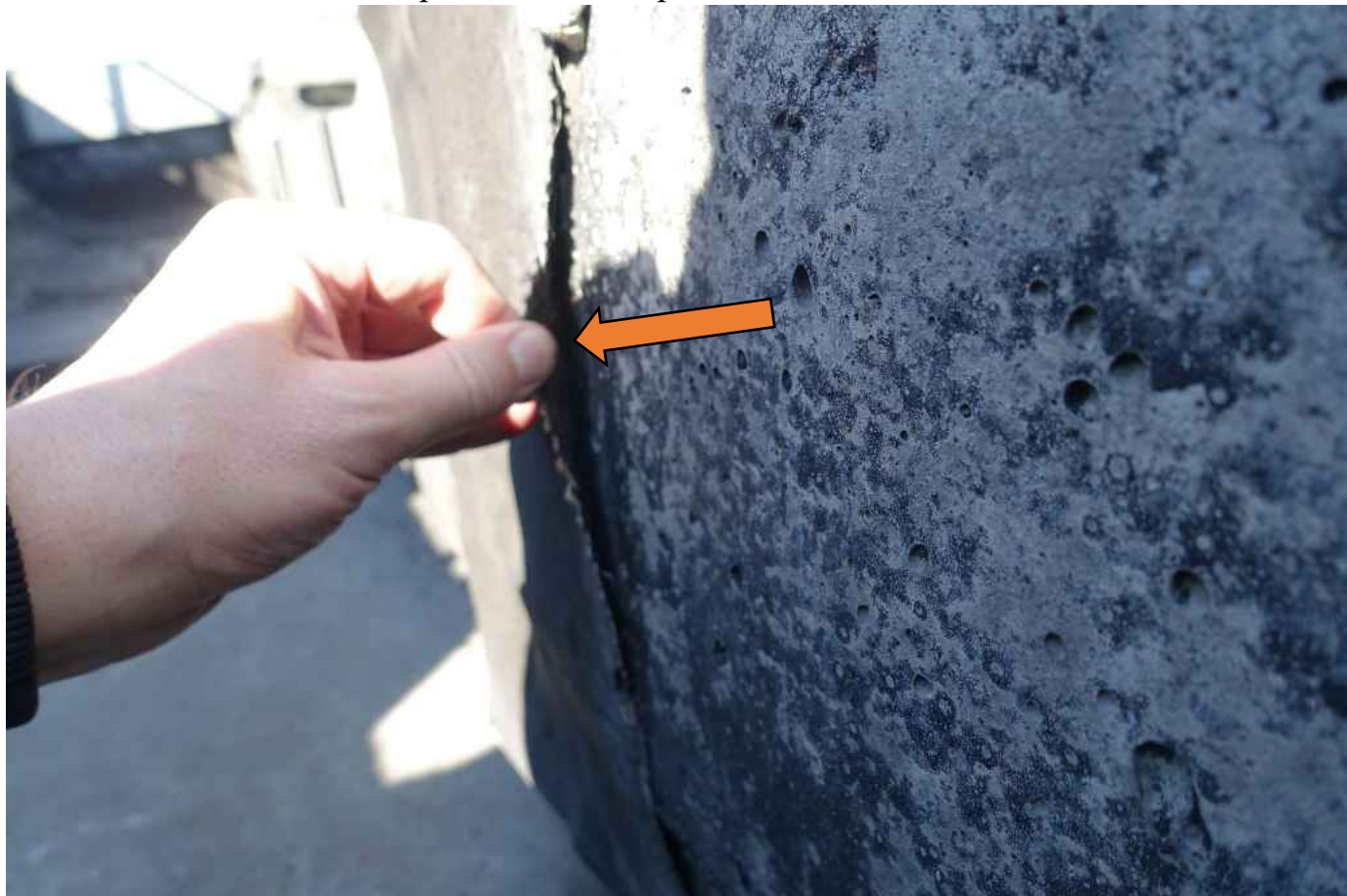
Фото 64. Не качественно проклеенная гидроизоляция.
