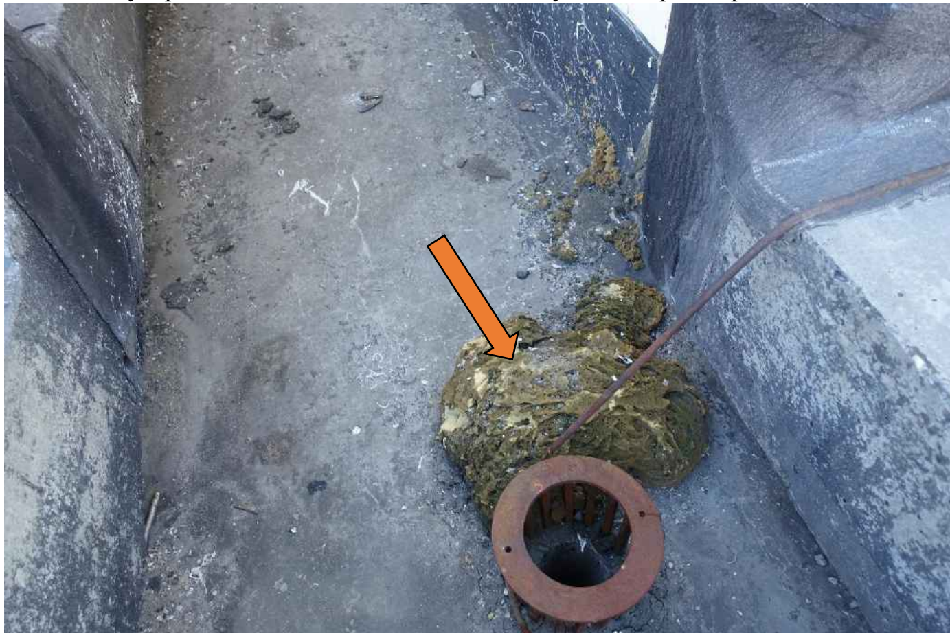
Фото 76. Мусор в виде остатков монтажной пены у водосборной воронки.
