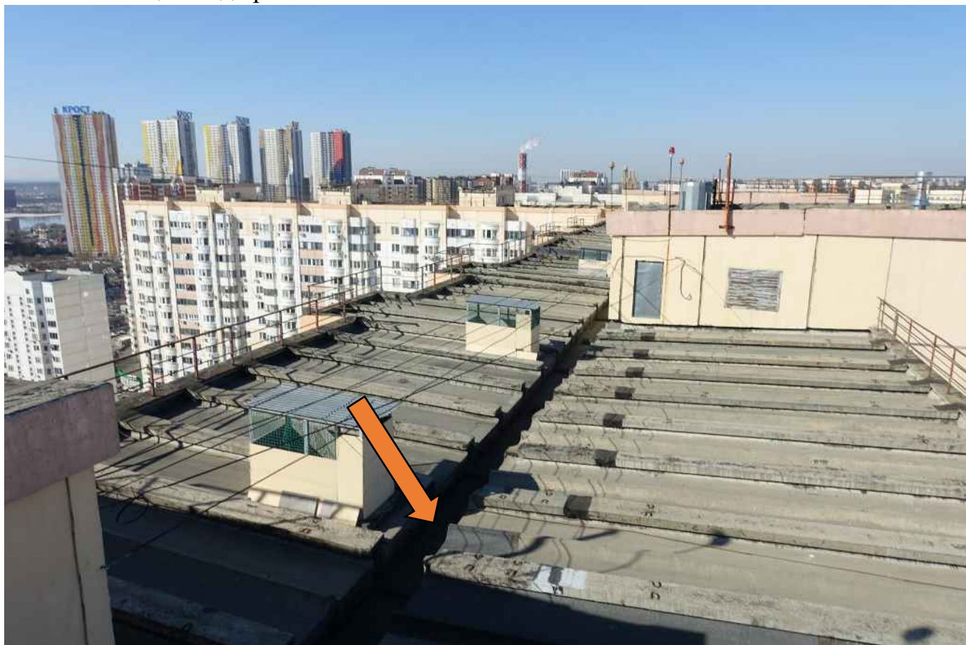
Фото 70. Устройство стыков на торцах плит из раствора разрушаются.
