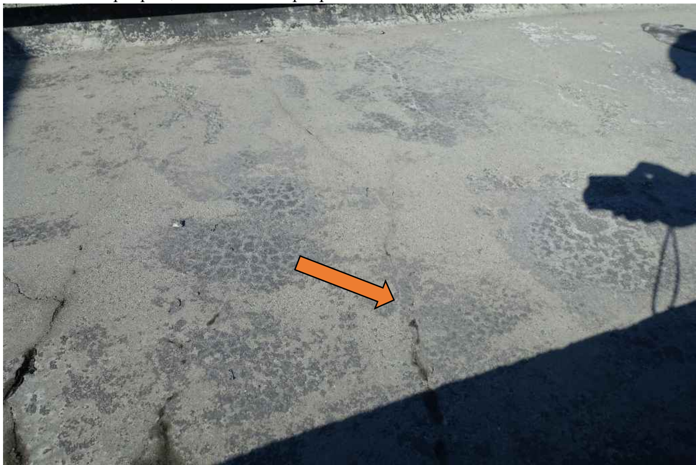
Фото 84. Микротрещины в плите перекрытия.
