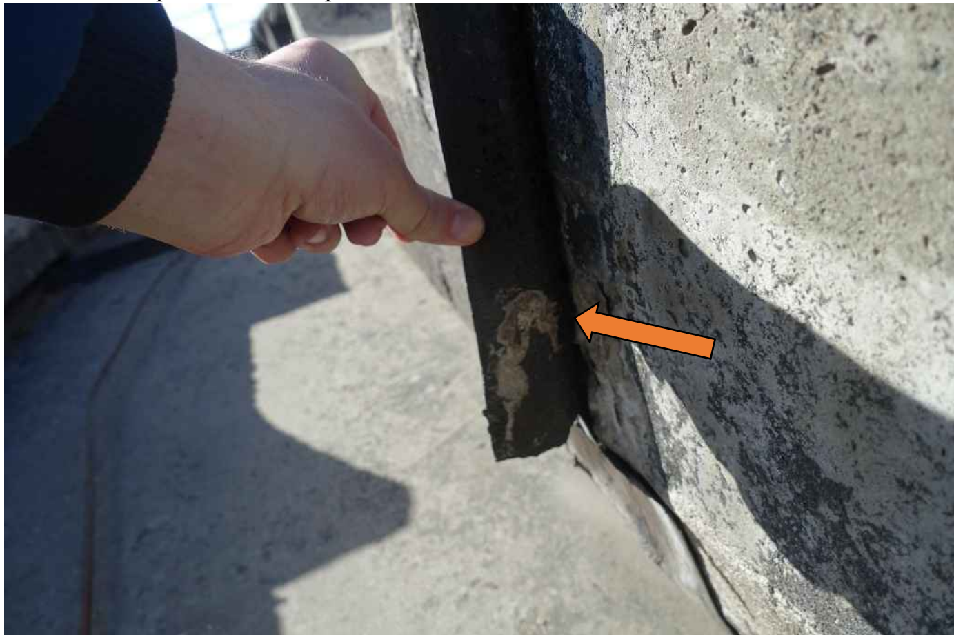
Фото 16. Не закрытый от осадков участок примыкания кровли.
