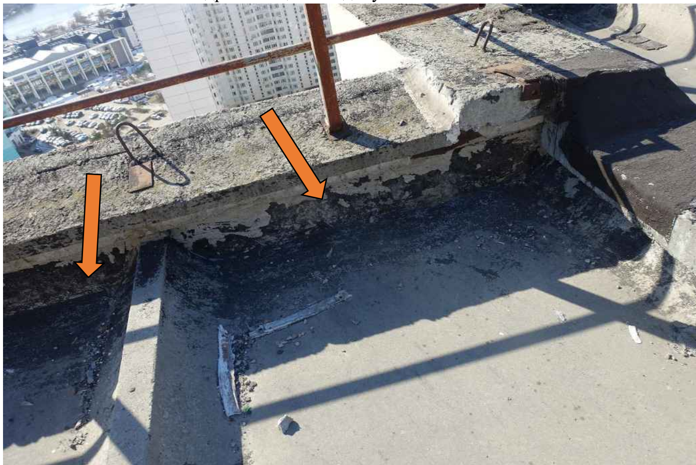
Фото 100. Обмазочная гидроизоляция в недопустимом состоянии.
