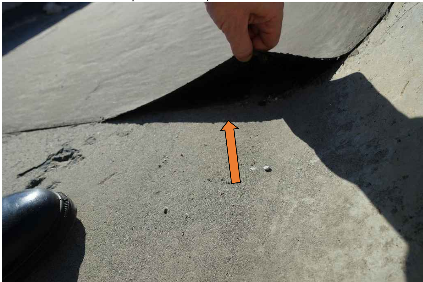
Фото 100. Обмазочная гидроизоляция в недопустимом состоянии.
