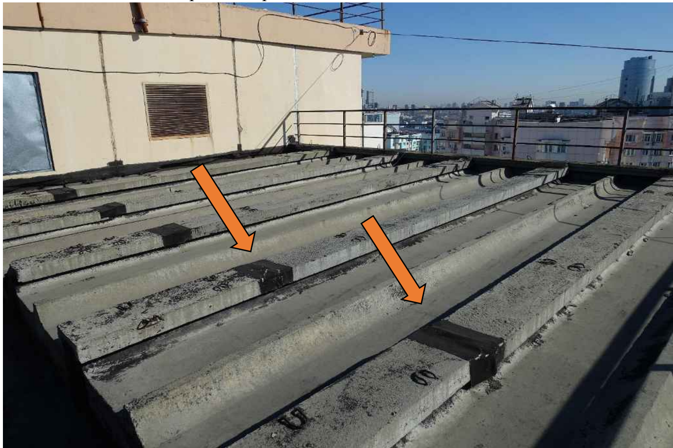
Фото 9. Штыки плит покрыты гидроизоляцией.
