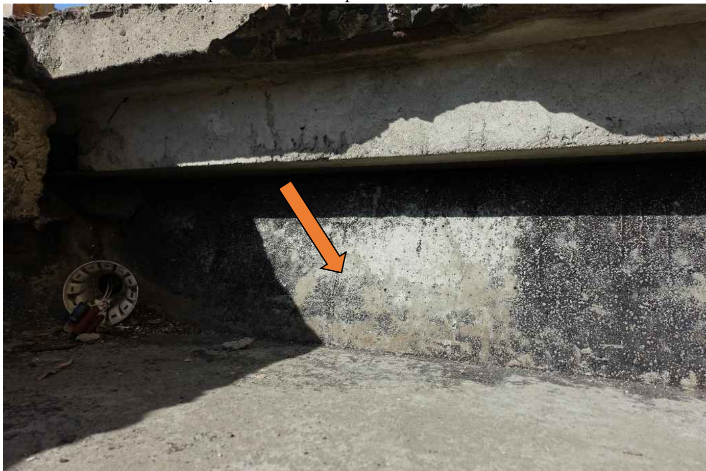
Фото 58. Обмазочная гидроизоляция выгорела и износилась.
