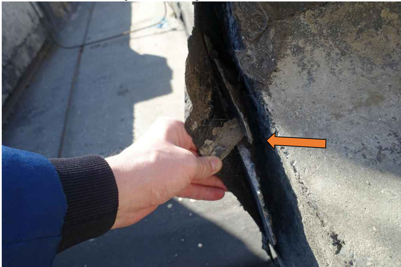
Фото 50. Гидроизоляция отслоилась вместе с бетонным основанием.
