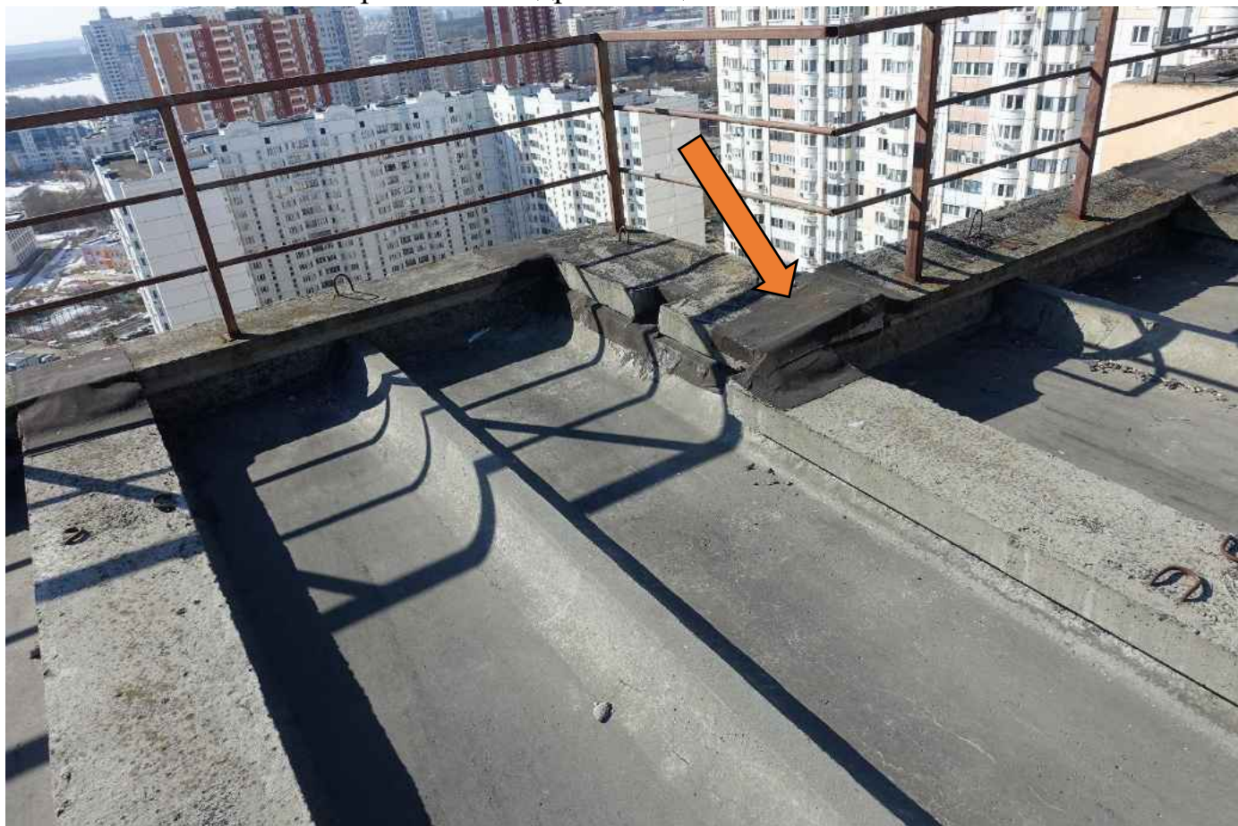
Фото 86. Не качественно проклеенная гидроизоляция.
