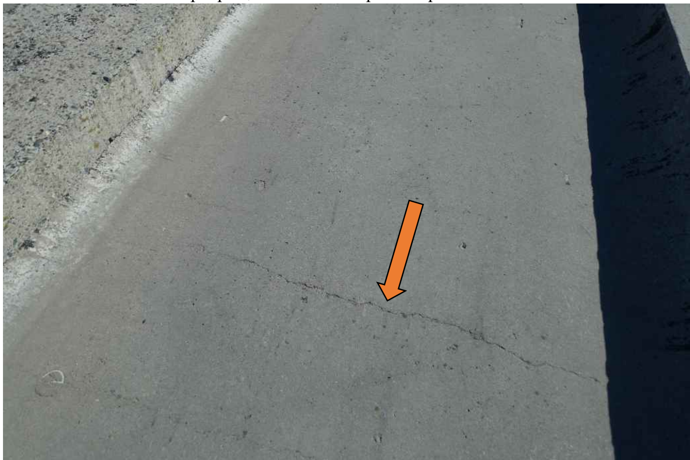
Фото 26. Фиксация микротрещин в плите покрытия кровли.
