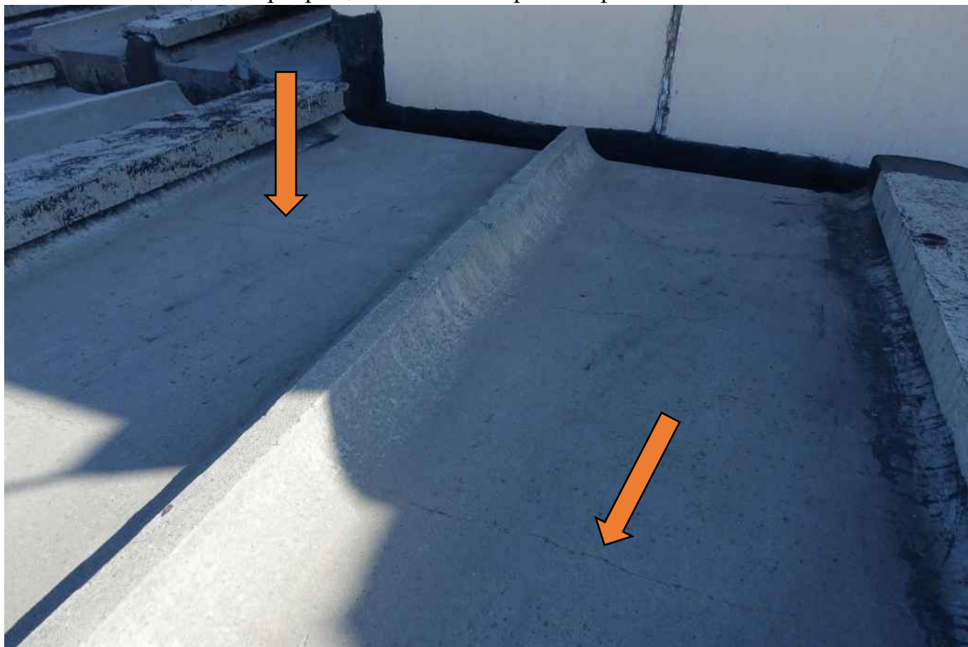
Фото 28. Фиксация микротрещин в плите покрытия кровли.
