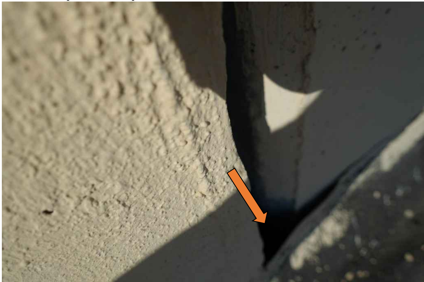
Фото 48. Гидроизоляция отходит от основания.
