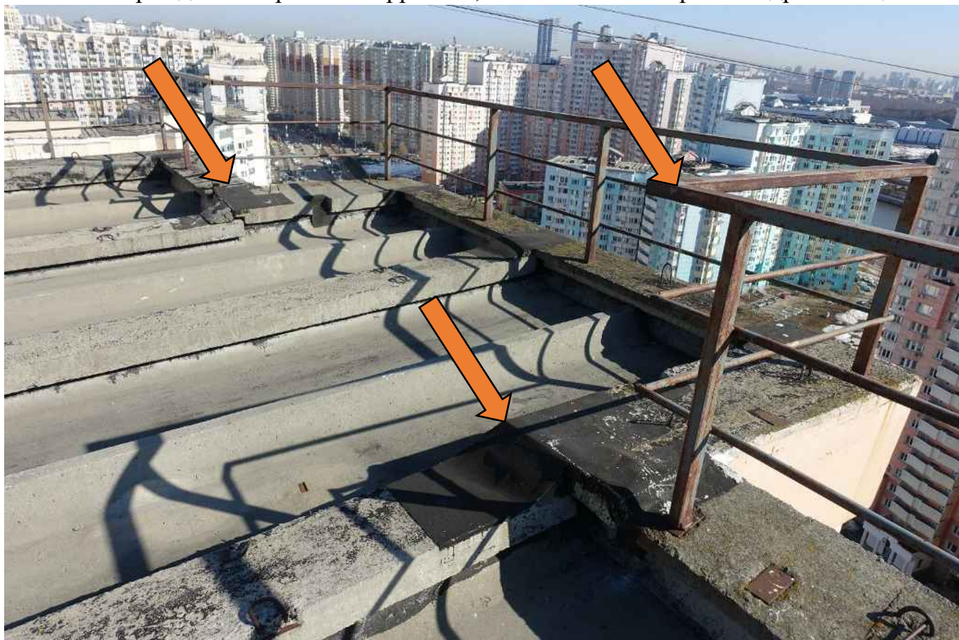
Фото 42. Ограждение поражено коррозией, места стыков покрыты гидроизоляцией.
