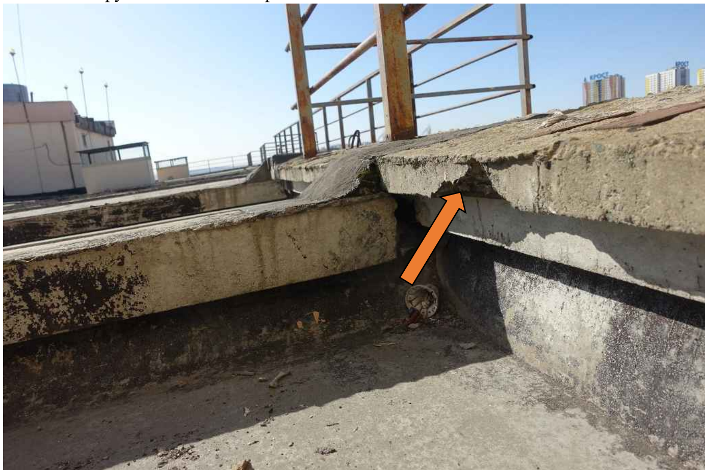
Фото 58. Обмазочная гидроизоляция выгорела и износилась.
