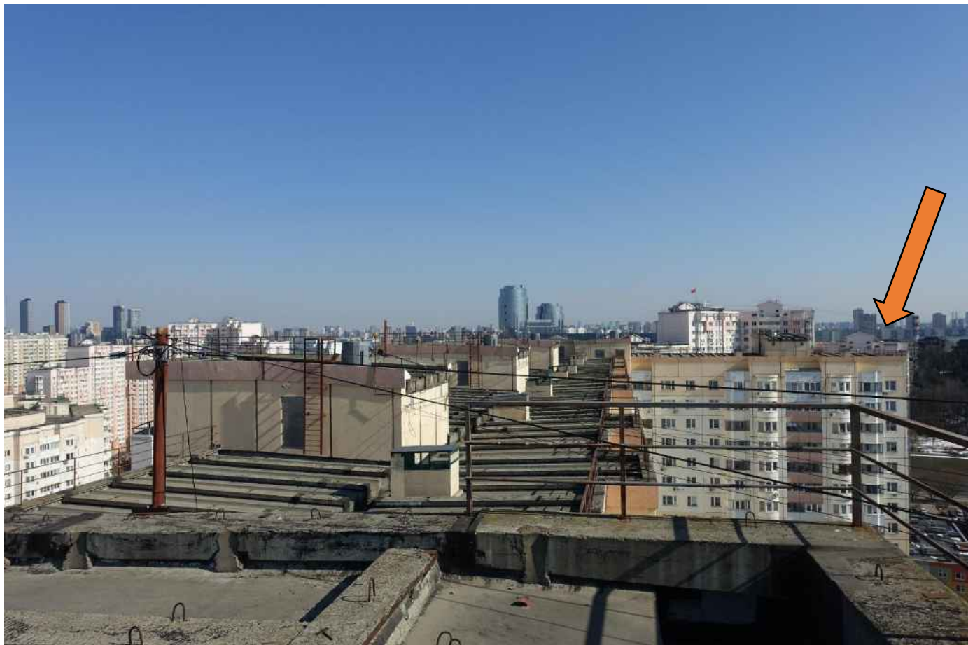
Фото 128. Мусор, остатки гидроизоляции.
