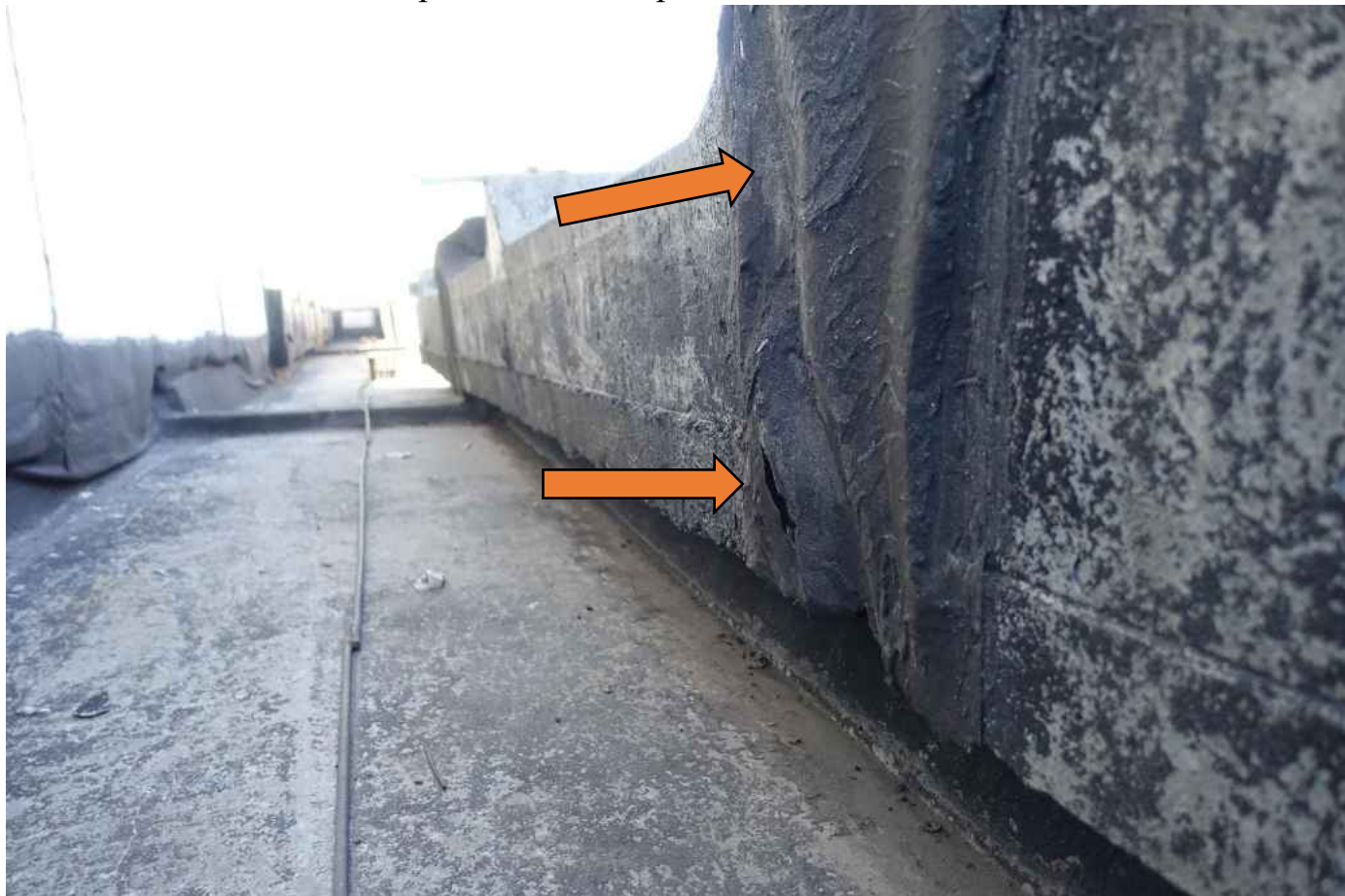
Фото 32. Не качественно проклеенная гидроизоляция.
