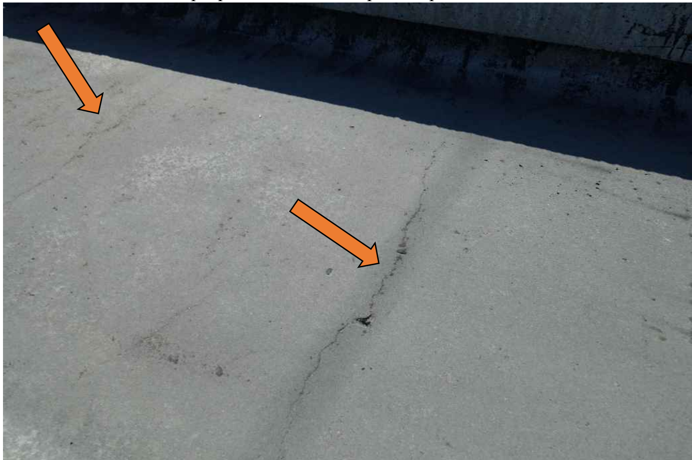
Фото 28. Фиксация микротрещин в плите покрытия кровли.
