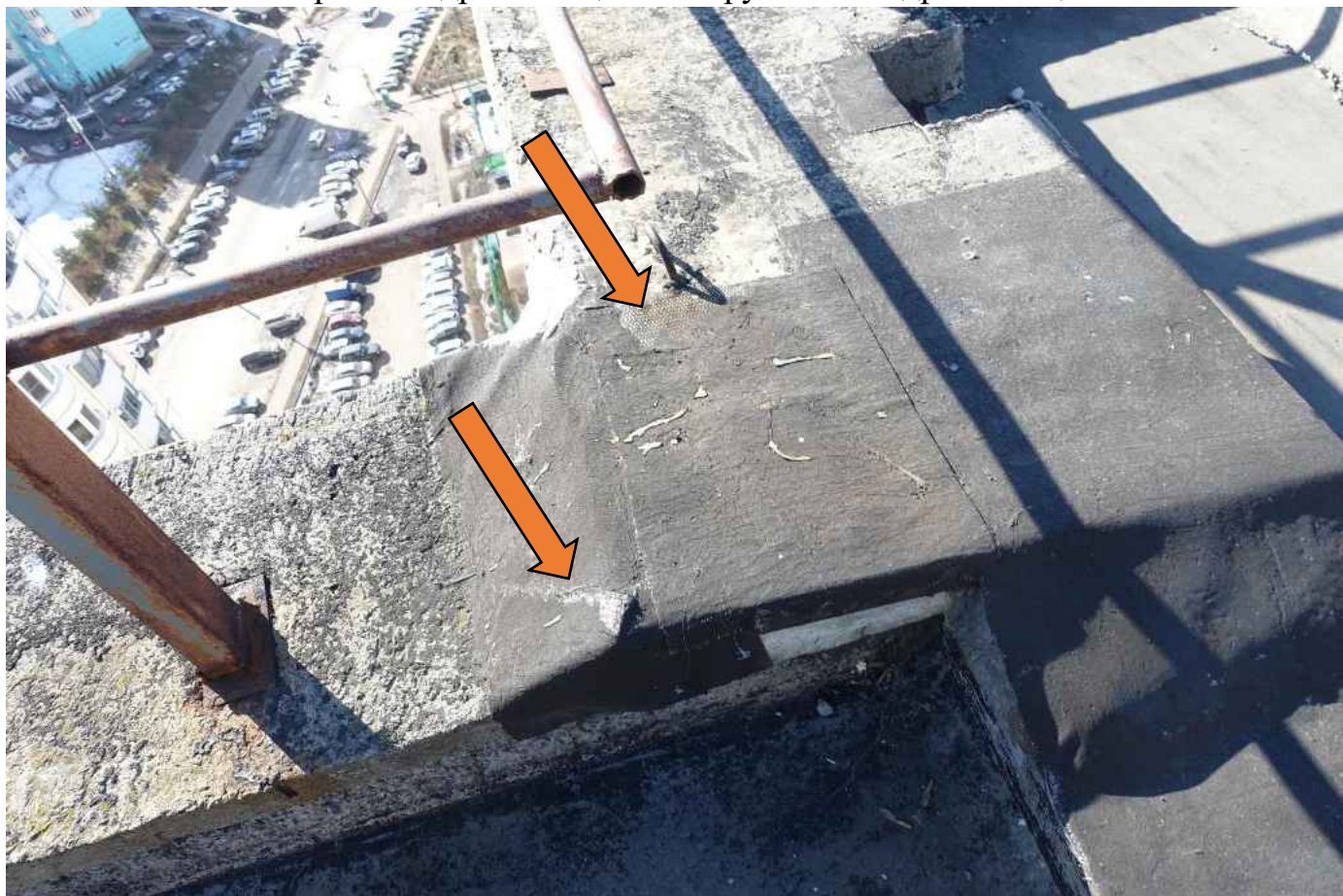
Фото 90. Не ровное основание плиты, место скопления осадков.
