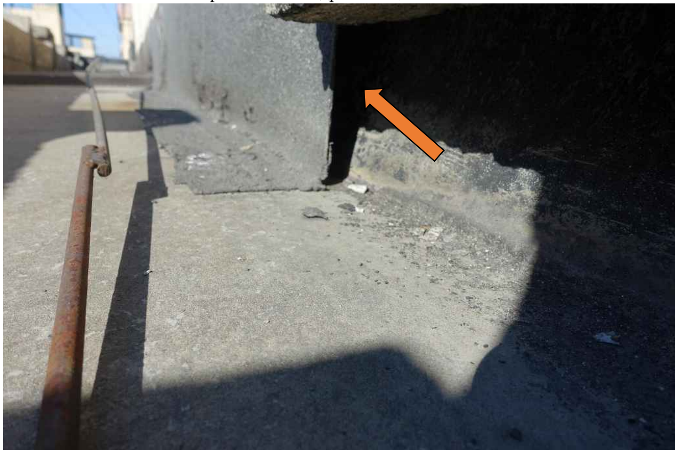
Фото 86. Не качественно проклеенная гидроизоляция.
