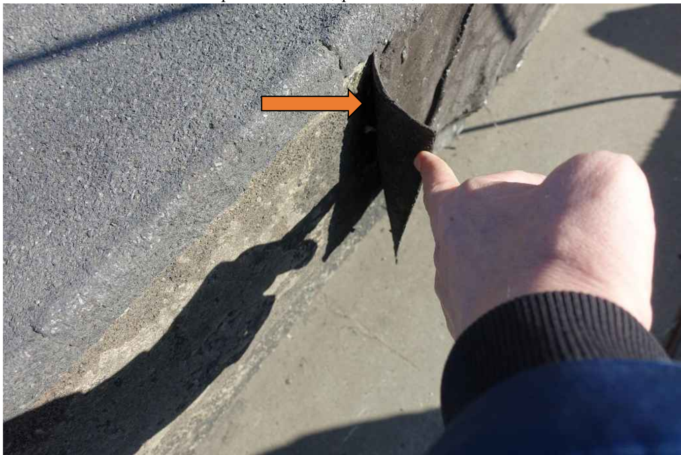
Фото 104. Не качественно проклеенная гидроизоляция.
