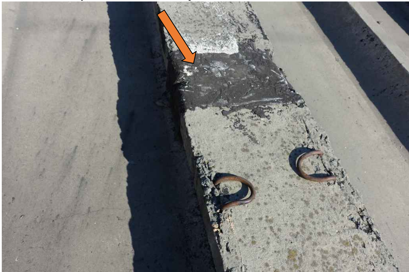
Фото 124. Недопустимое состояние гидроизола.
