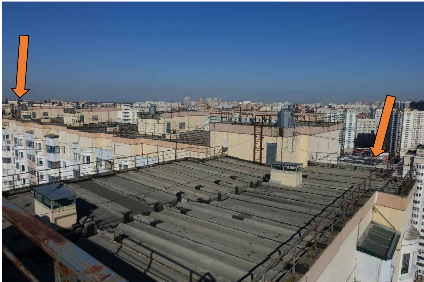
Фото 42. Ограждение поражено коррозией, места стыков покрыты гидроизоляцией.
