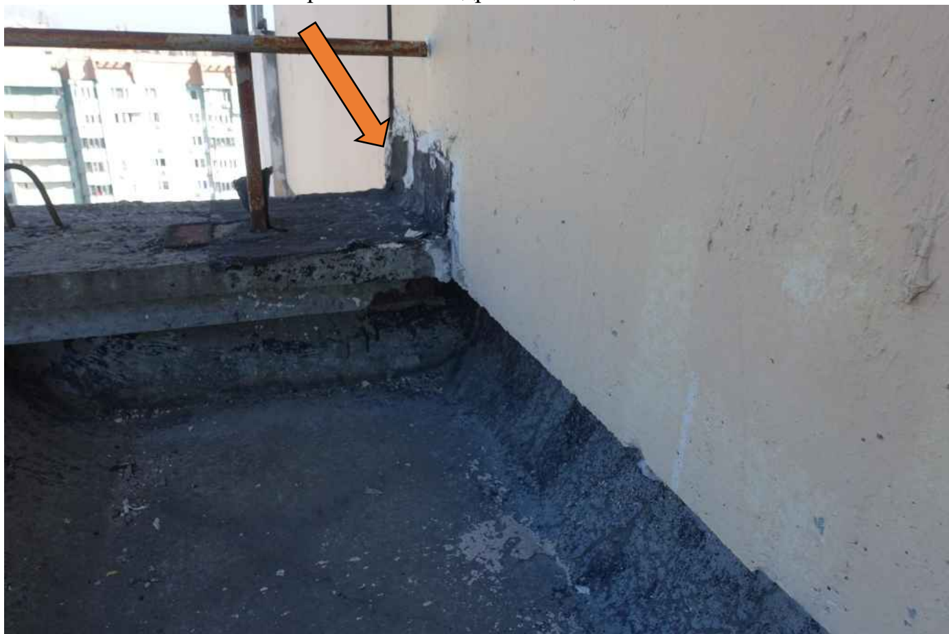
Фото 118. Не качественно проклеенная гидроизоляция.
