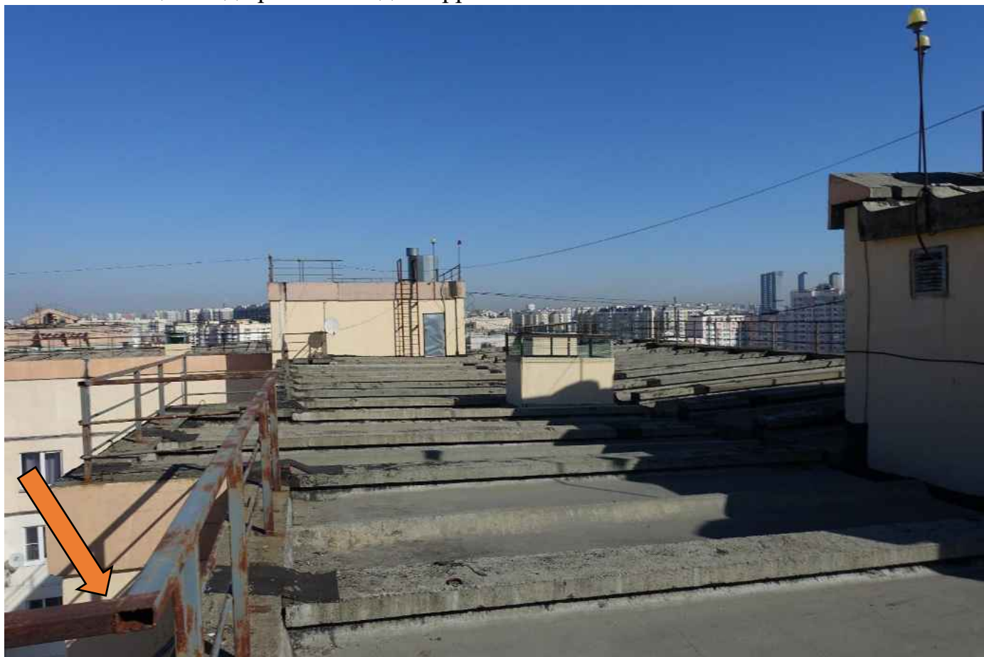
Фото 24. Общий вид кровли. Следы коррозии на металле.
