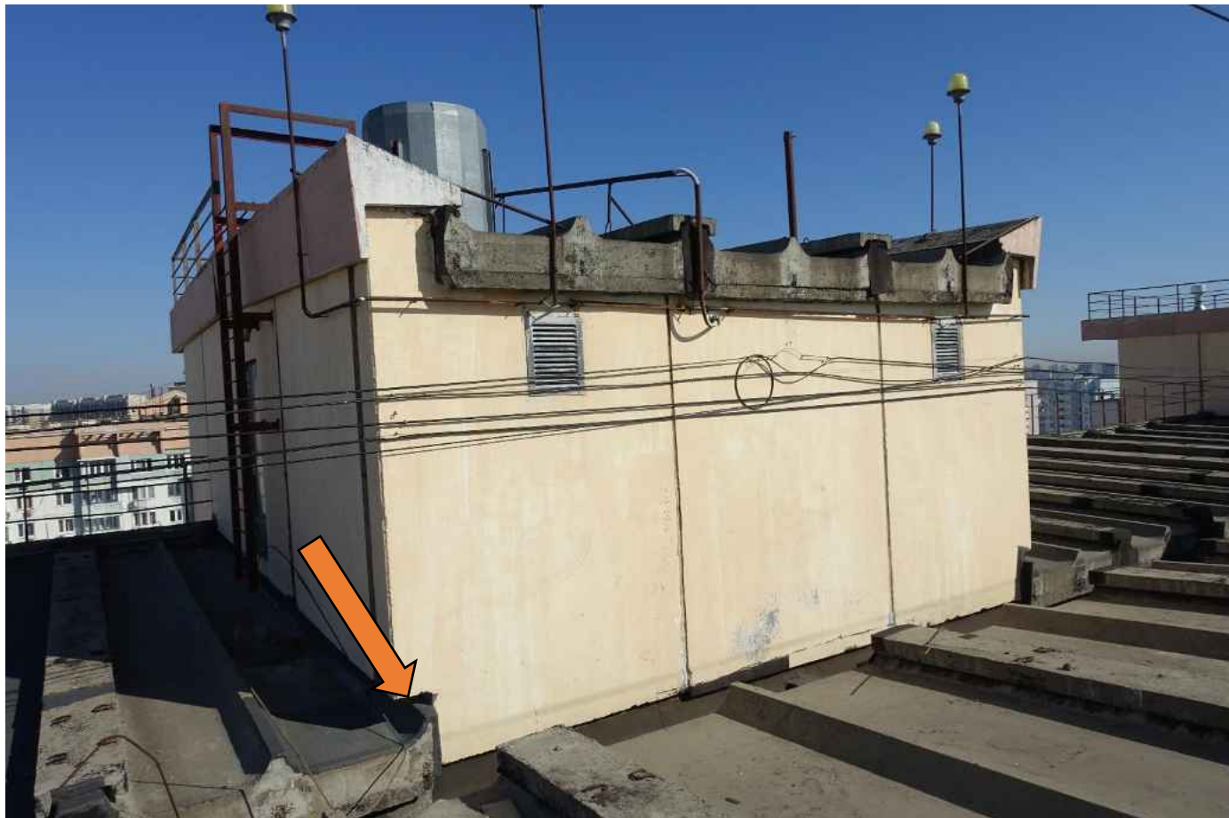
Фото 104. Не качественно проклеенная гидроизоляция.
