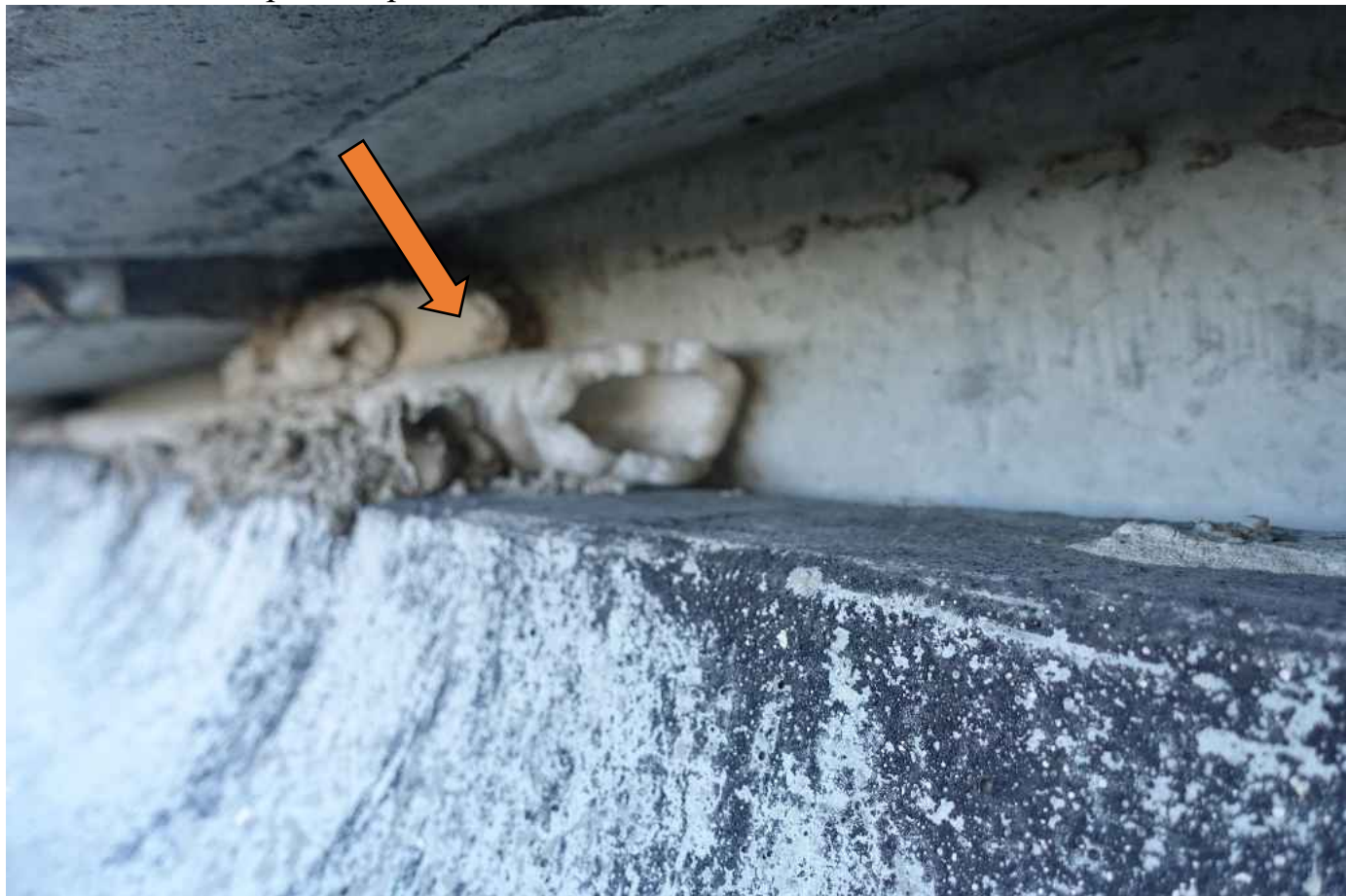
Фото 118. Не качественно проклеенная гидроизоляция.
