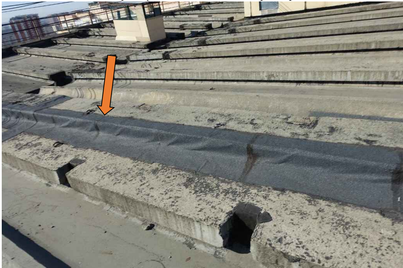
Фото 94. Гидроизоляция выполнена не качественно, вздутие, стыки.
