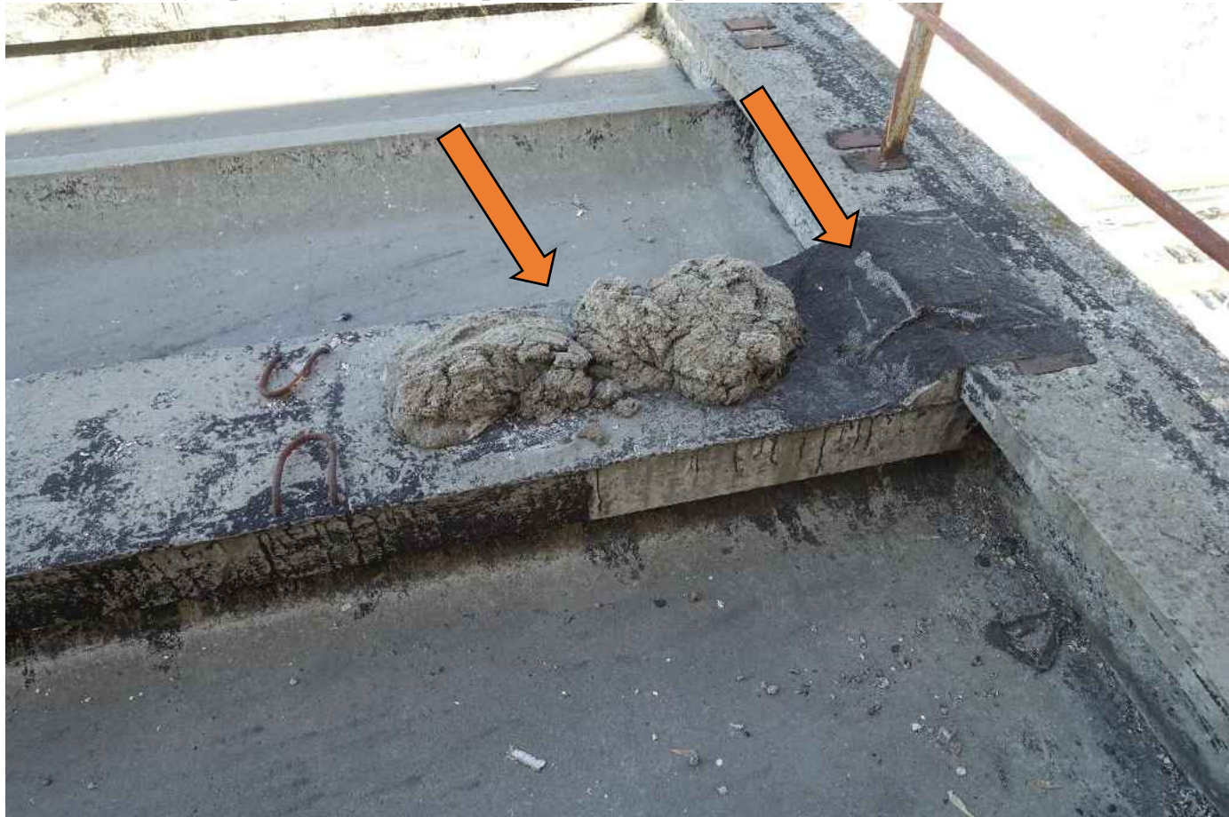
Фото 120. Мусор в виде остатков раствора. Гидроизол в недопустимом состоянии.
