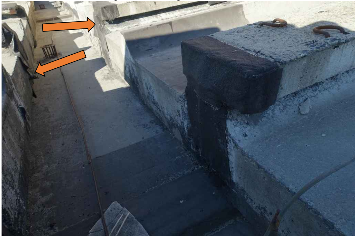
Фото 112. Не качественно проклеенная гидроизоляция.
