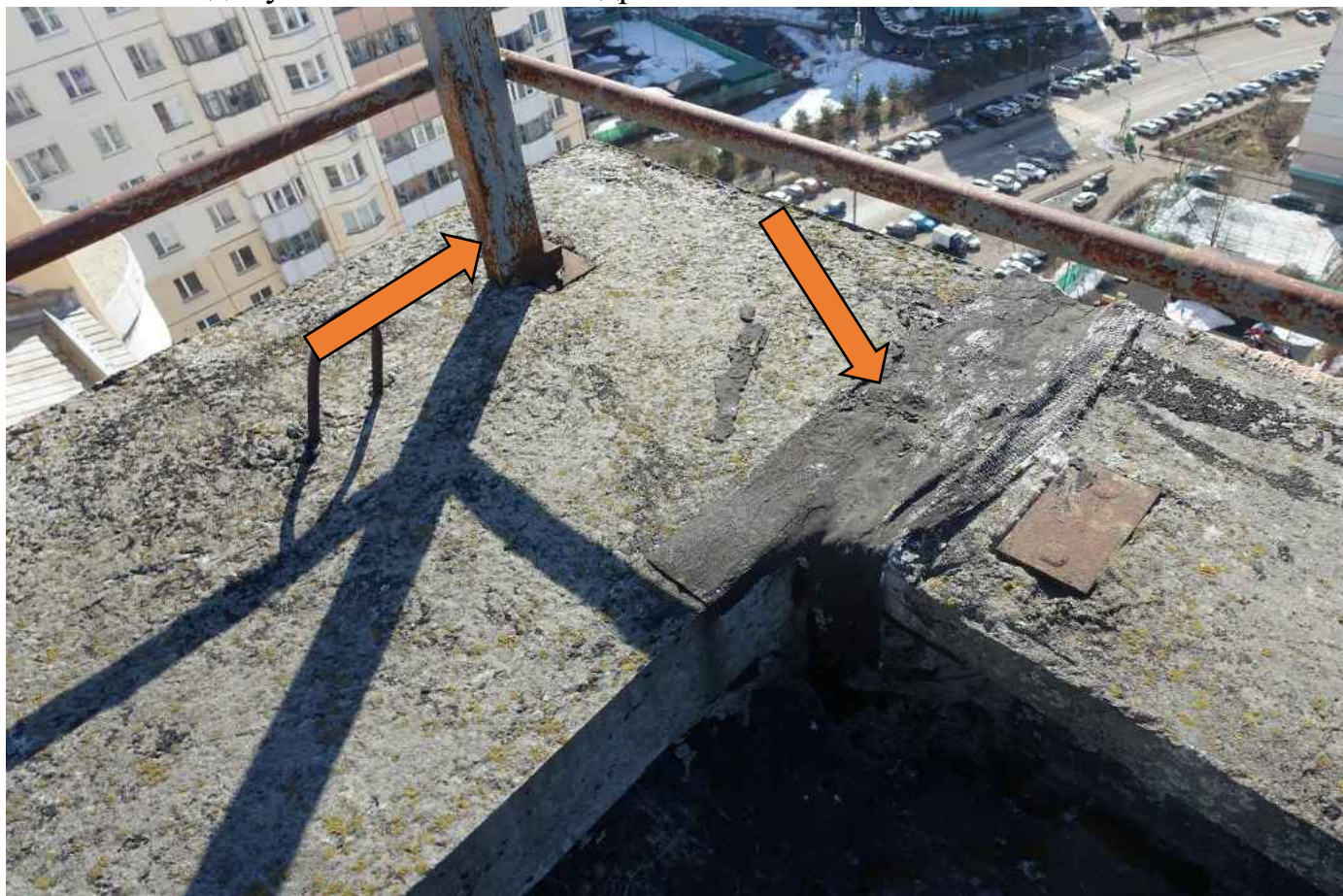
Фото 102. Не качественно проклеенная гидроизоляция.
