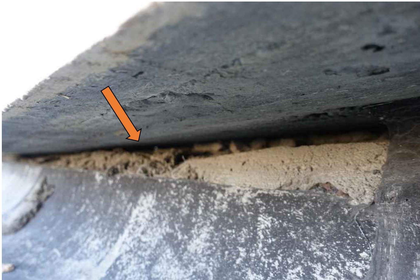
Фото 80. Не закрытое примыкание, монтажная пена выгорела.
