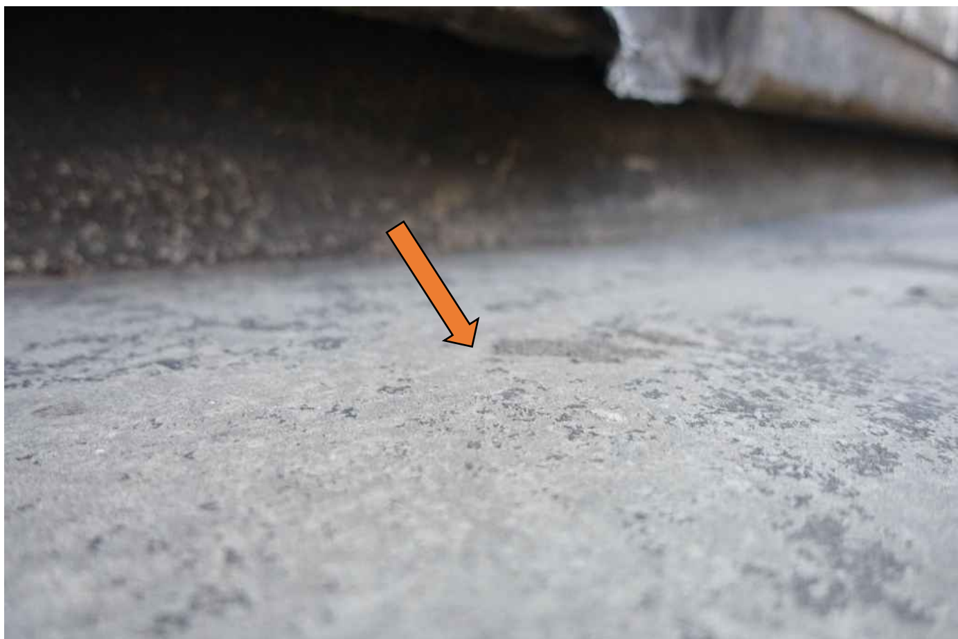
Фото 20. Осмотр лотка водотока. Покрытие из состава на битумной основе изношено.
