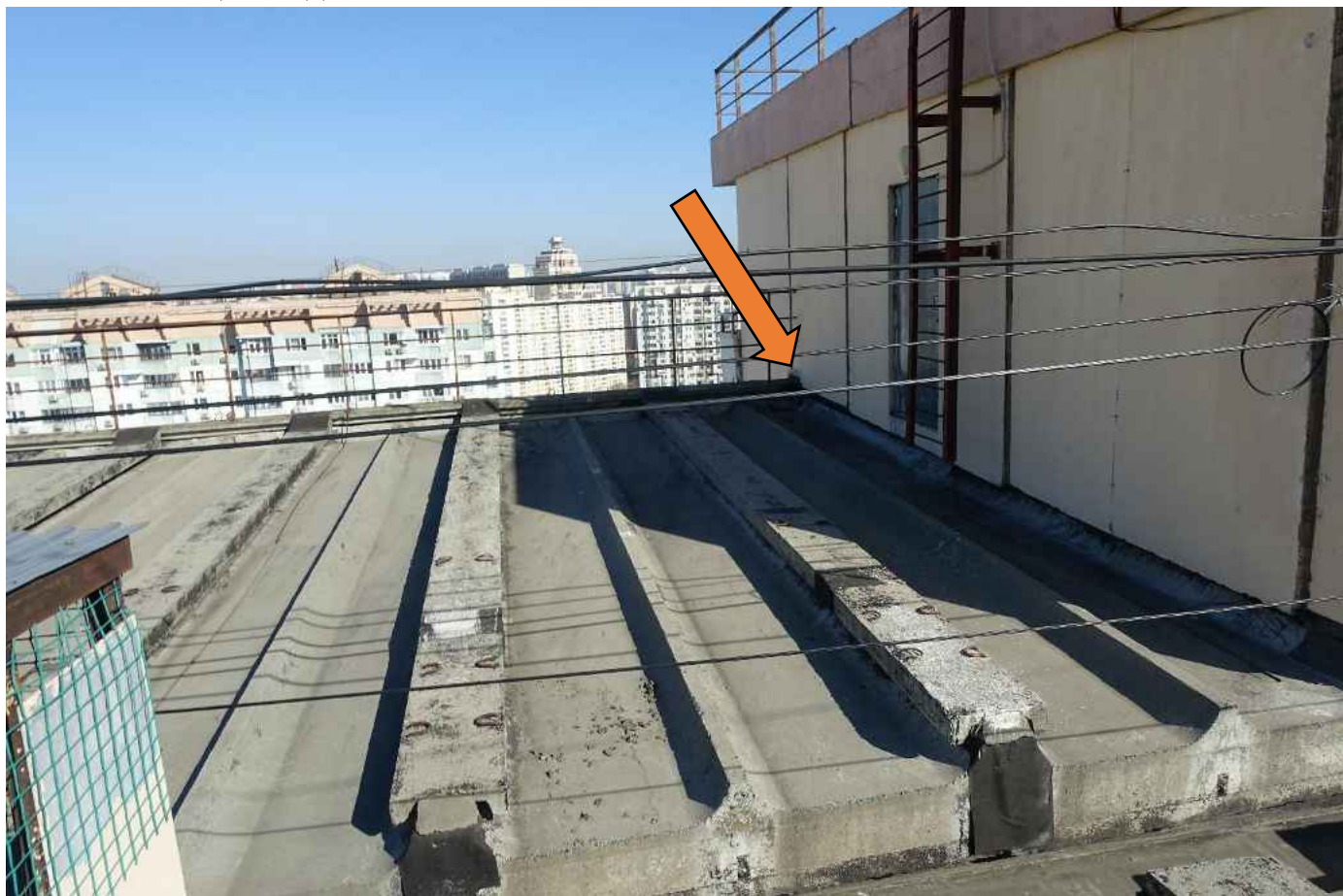
Фото 92. Не закрытое примыкание. Металл покрыт коррозией.
