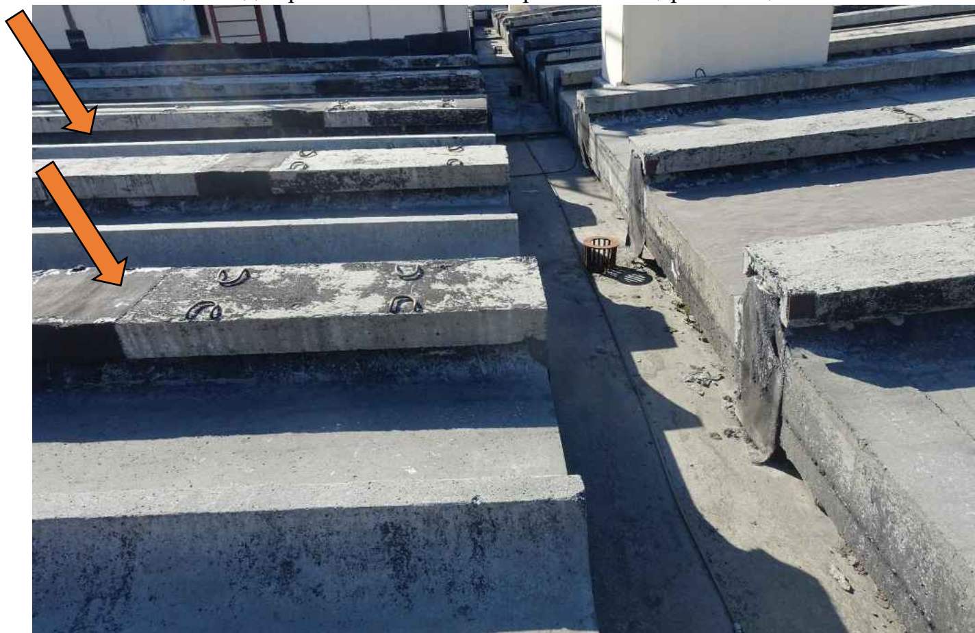
Фото 54. Общий вид. Примыкания и стыки проклеены гидроизоляцией.
