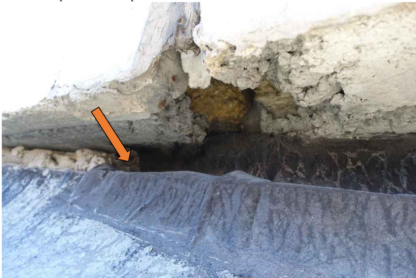
Фото 116. Примыкание закрыто частично.
