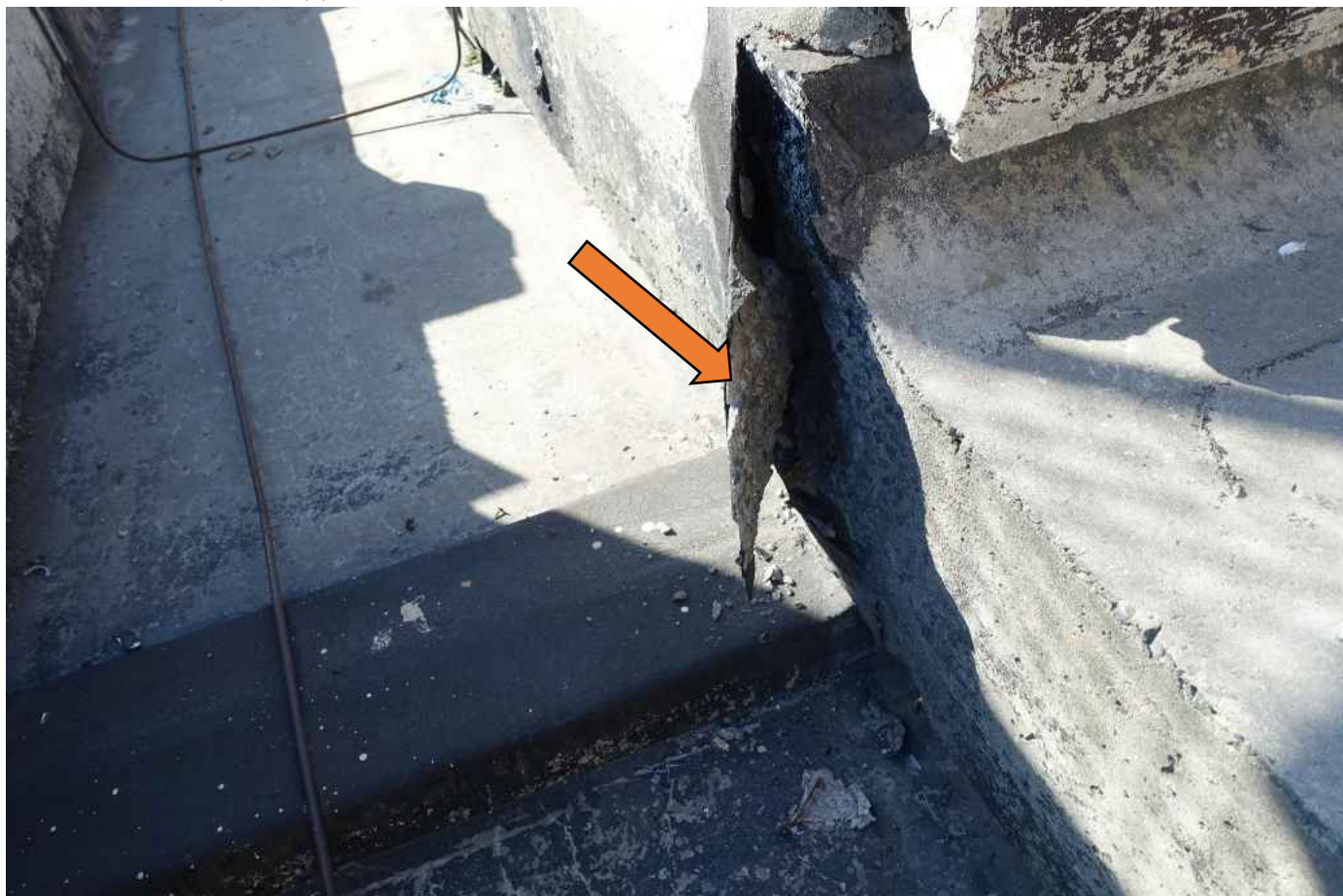
Фото 52. Коррозия рабочей арматуры. Гидроизоляция не проклеена.
