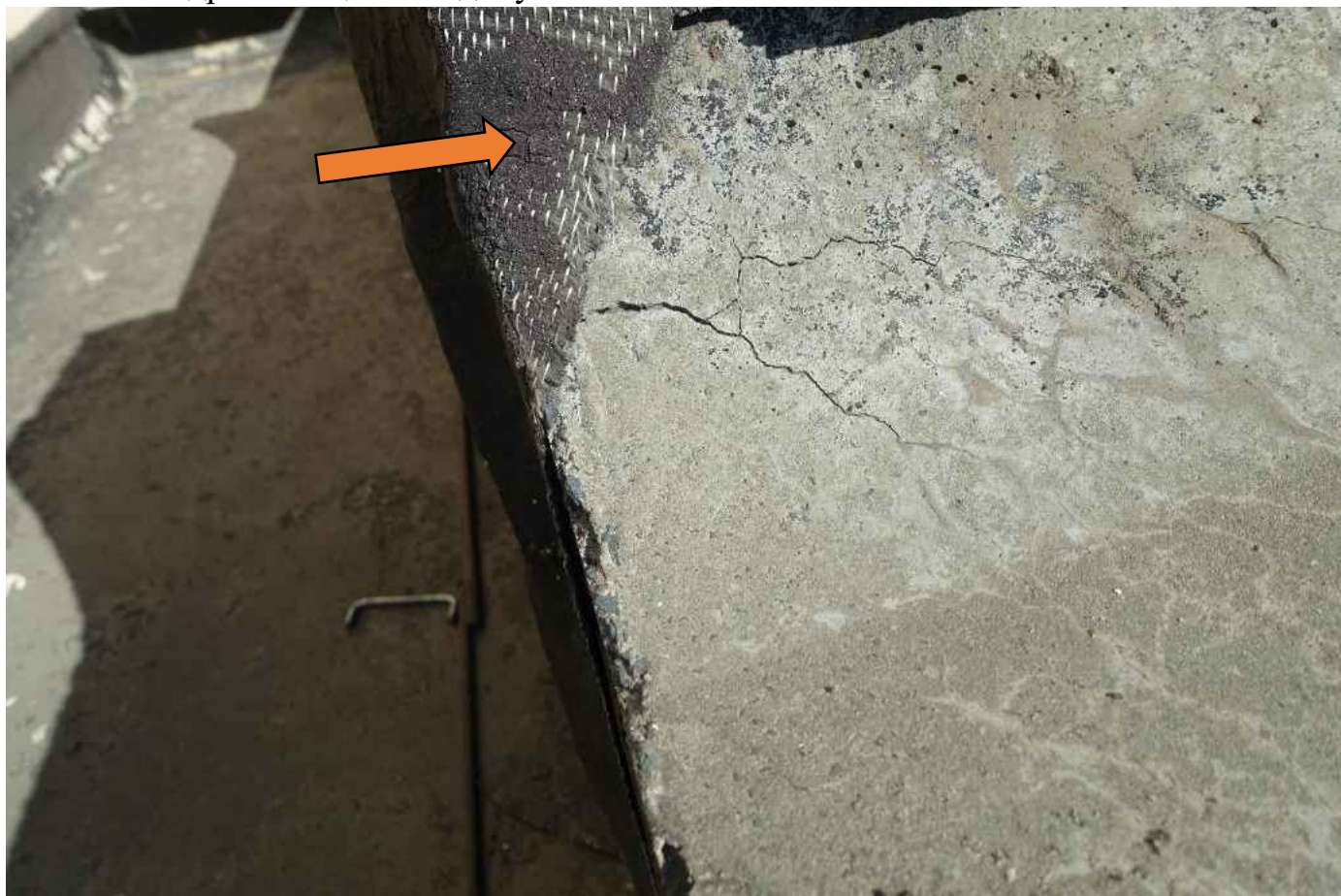
Фото 44. Гидроизоляция - не допустимое состояние.
