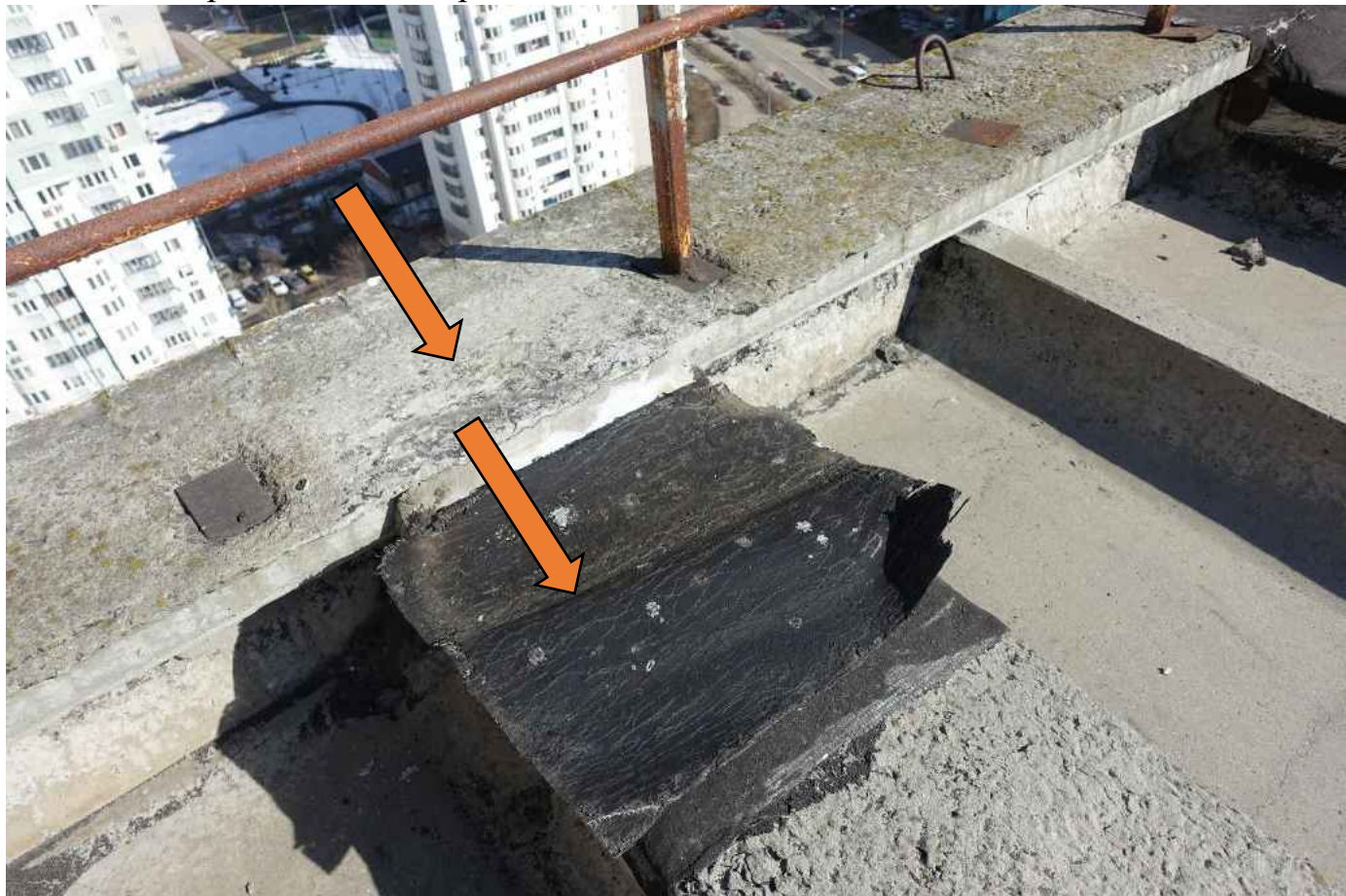
Фото 98. Виден армирующий слой, не допустимое состояние материала.
