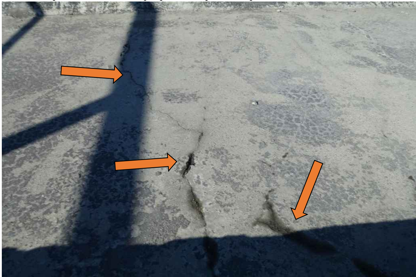
Фото 84. Микротрещины в плите перекрытия.
