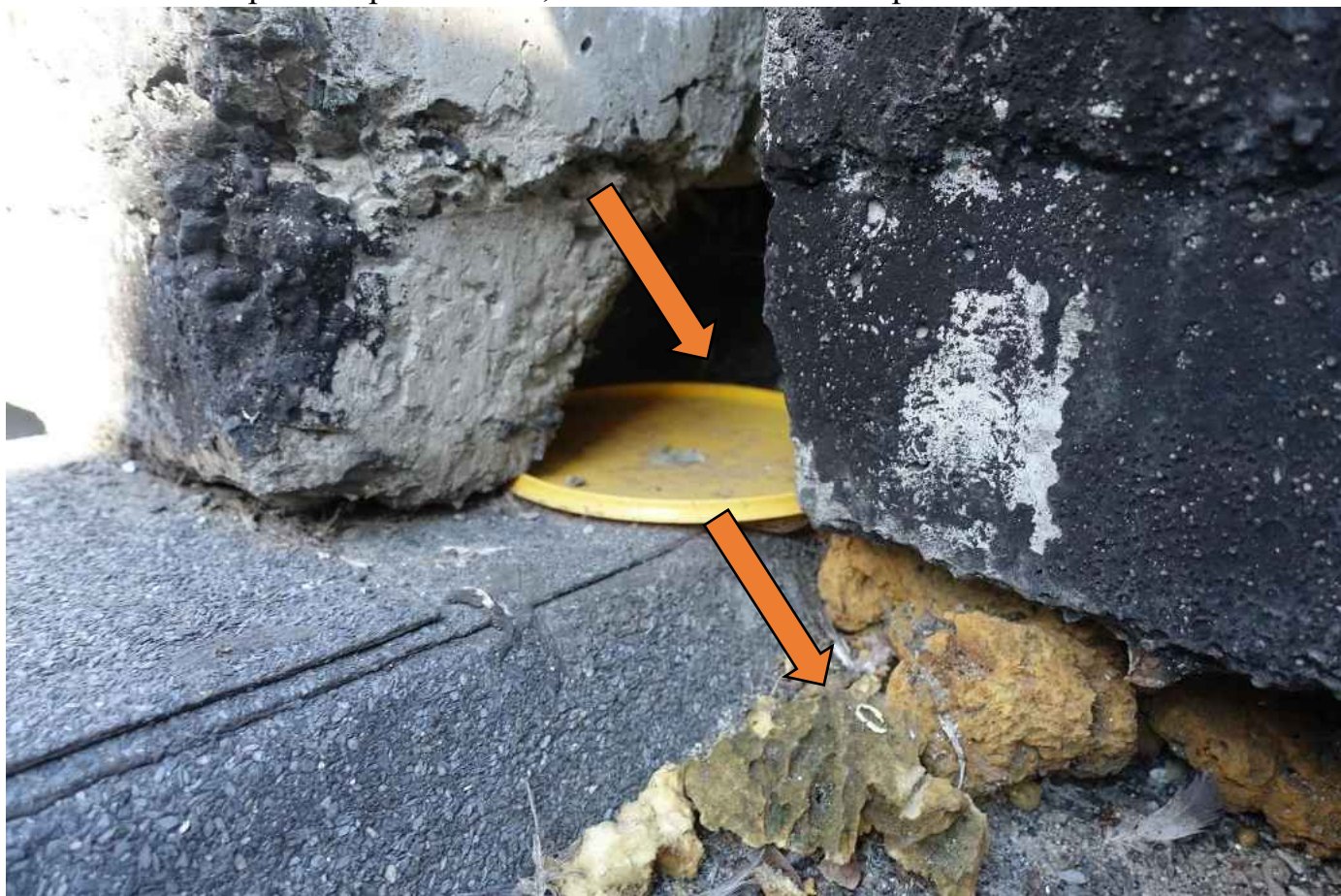
Фото 80. Не закрытое примыкание, монтажная пена выгорела.
