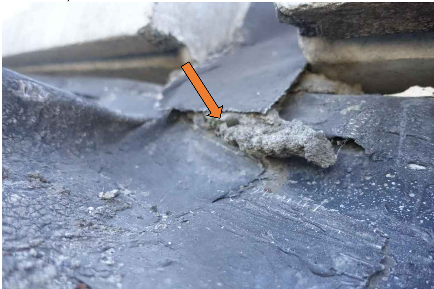
Фото 38. Гидроизоляция нанесена не качественно.
