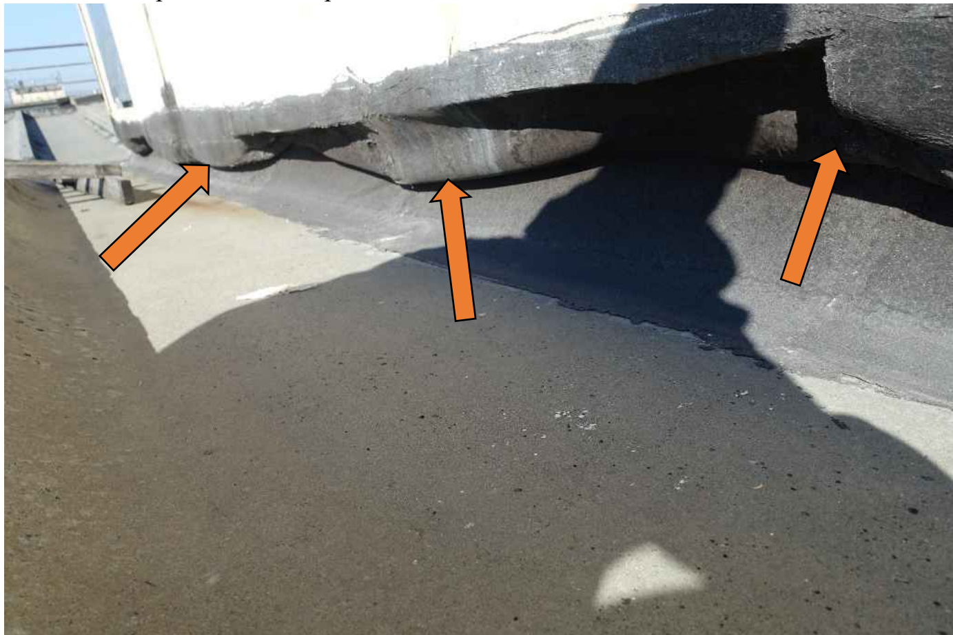
Фото 14. Не проклеенная гидроизоляция.
