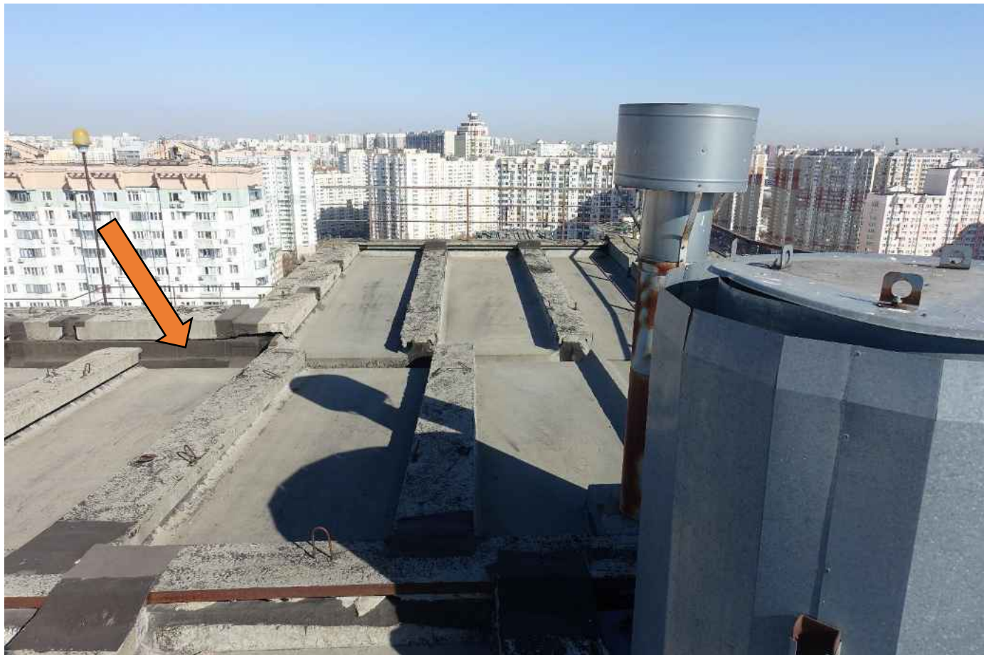
Фото 60. Ограждение поражено коррозией.
