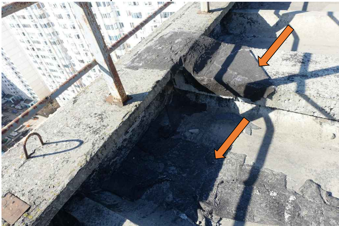
Фото 102. Не качественно проклеенная гидроизоляция.
