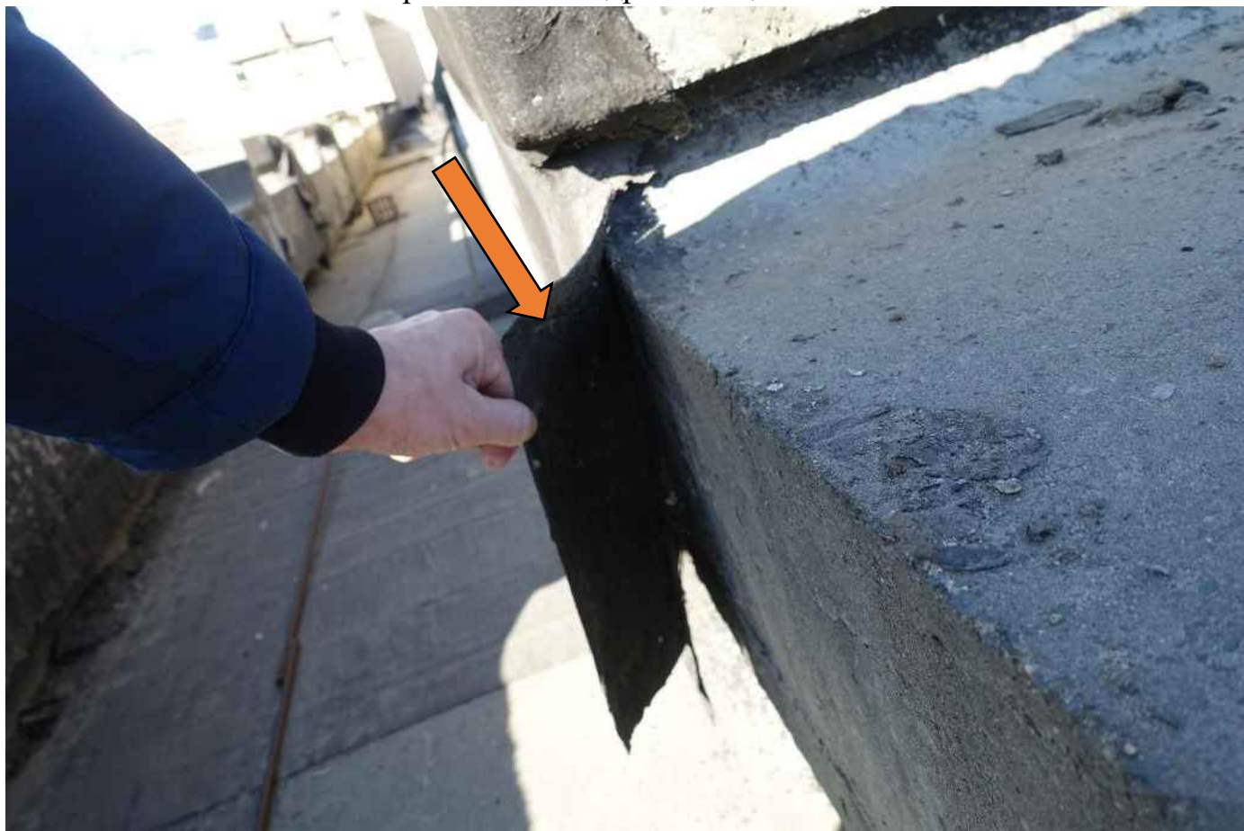
Фото 110. Не качественно проклеенная гидроизоляция.
