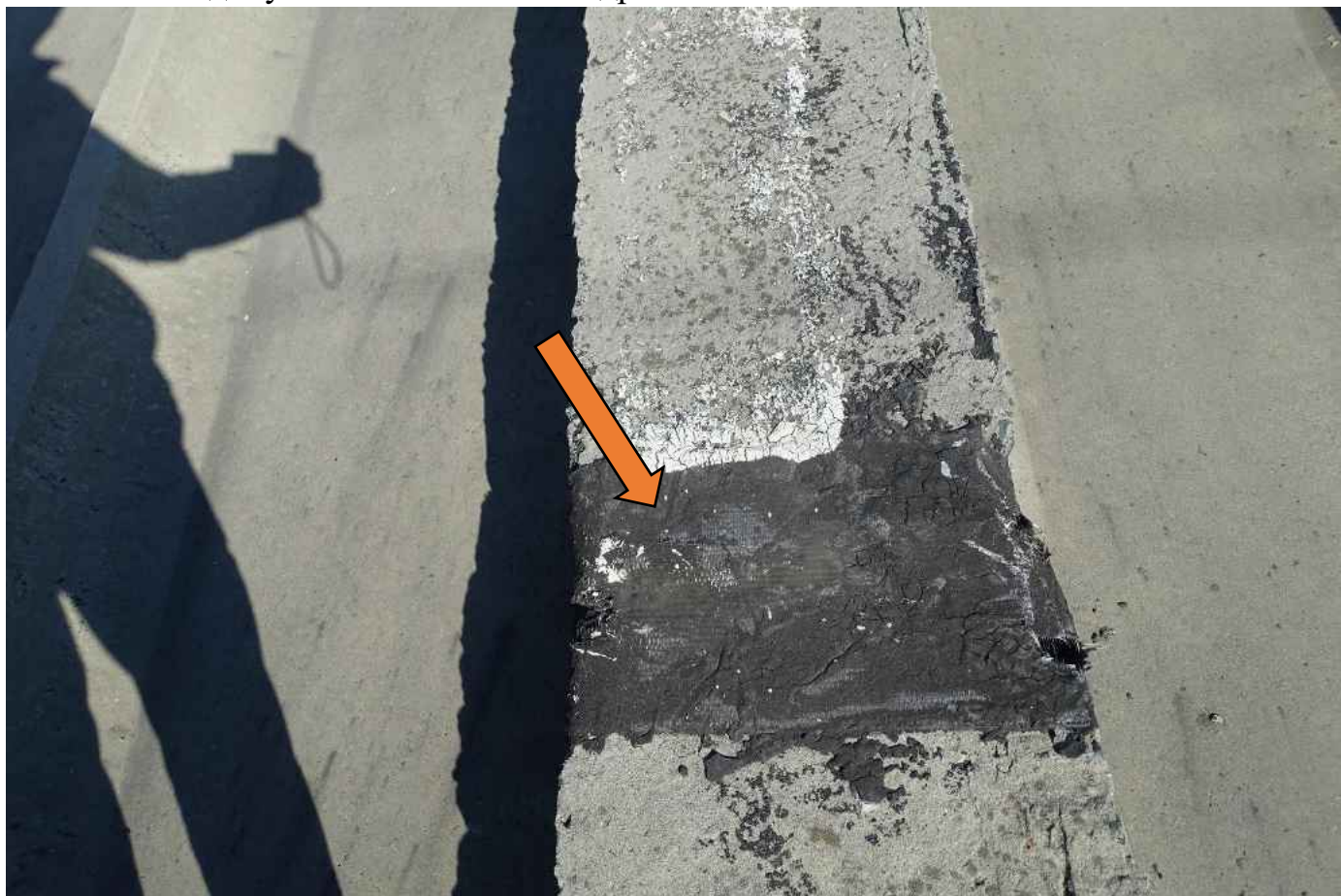
Фото 124. Недопустимое состояние гидроизола.
