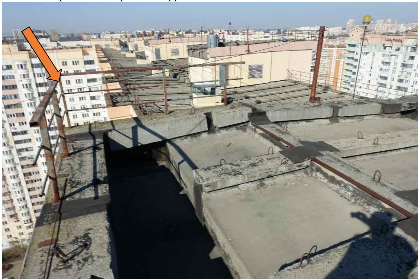
Фото 60. Ограждение поражено коррозией.
