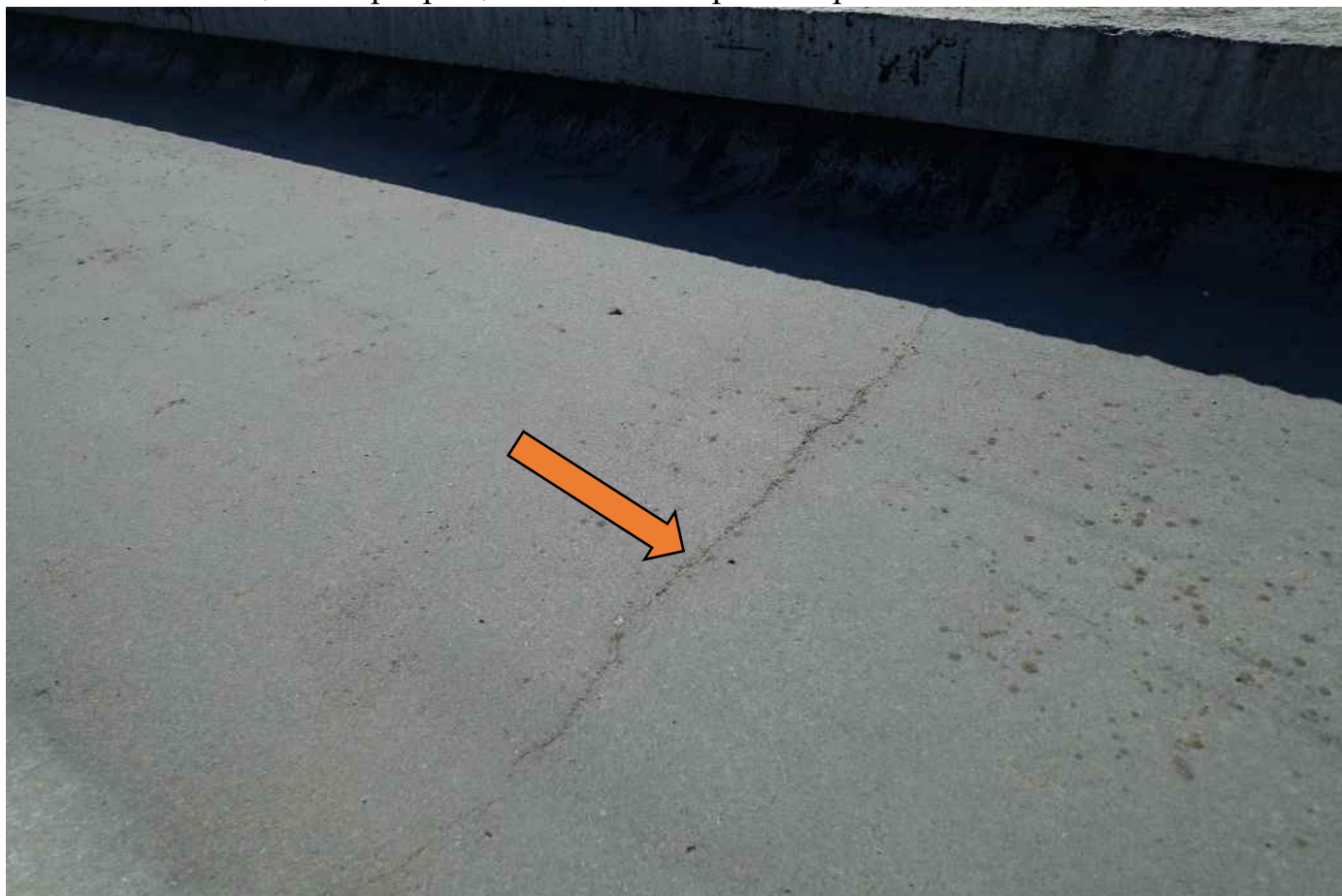
Фото 26. Фиксация микротрещин в плите покрытия кровли.
