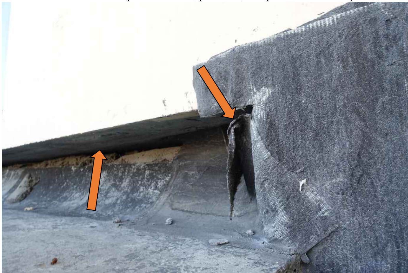
Фото 78. Не качественно проклеенная гидроизоляция. Примыкание не закрыто.
