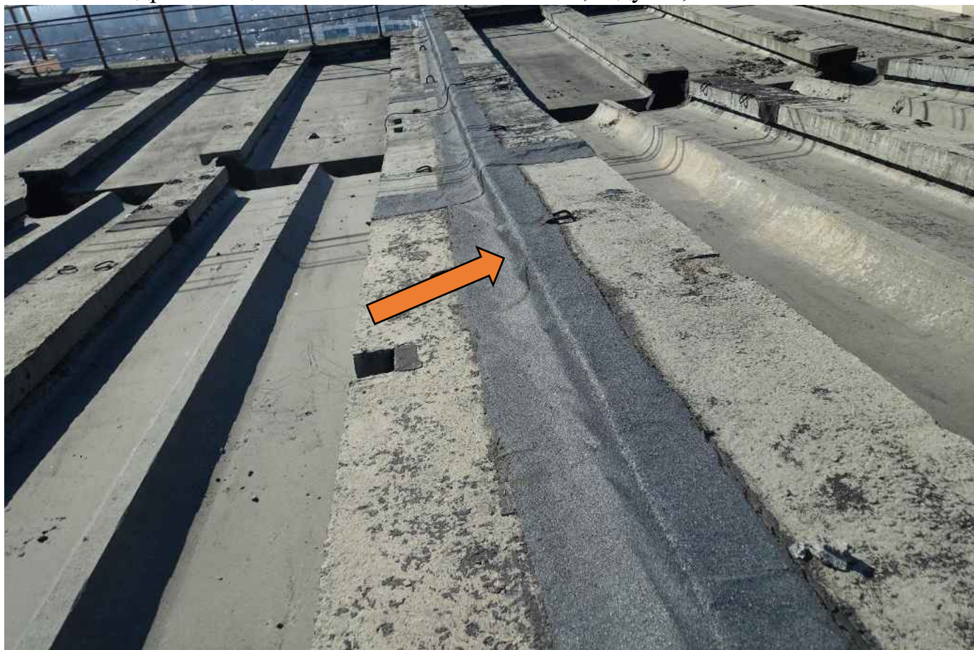
Фото 94. Гидроизоляция выполнена не качественно, вздутие, стыки.
