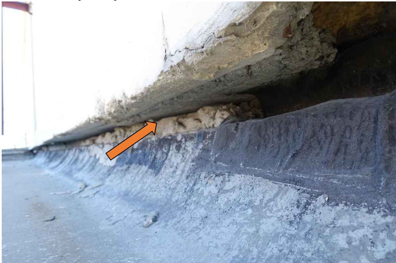
Фото 116. Примыкание закрыто частично.
