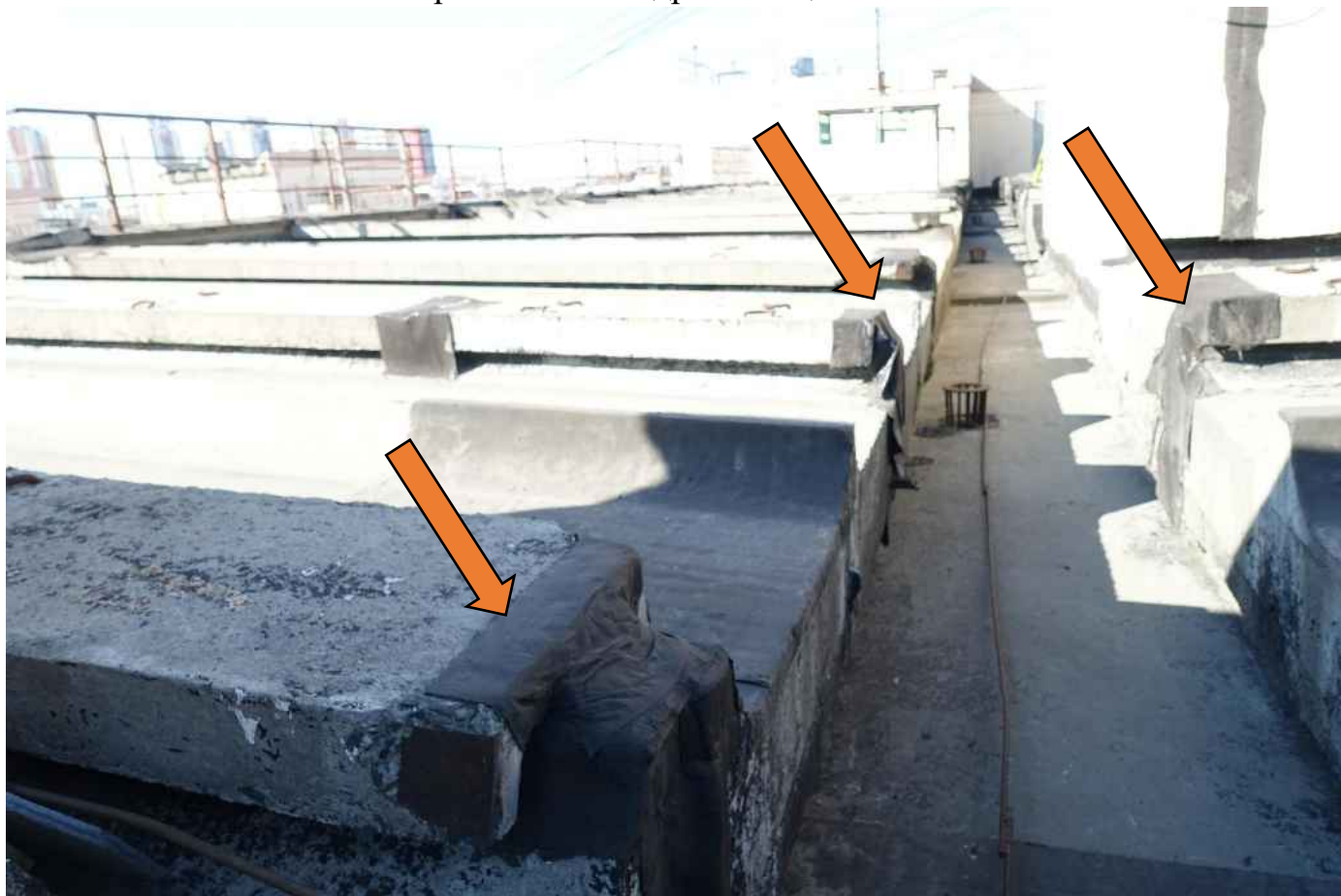
Фото 112. Не качественно проклеенная гидроизоляция.
