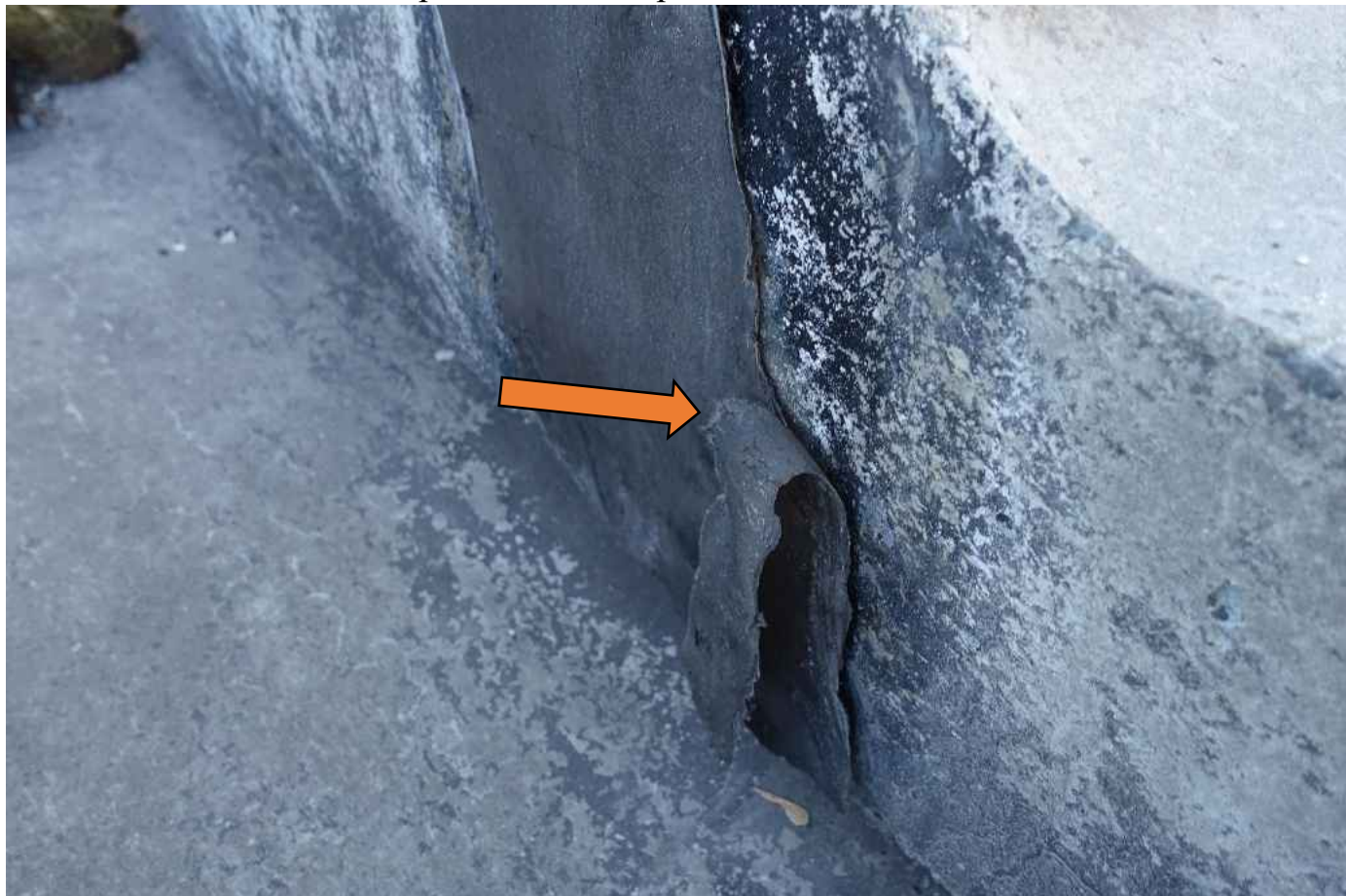
Фото 76. Мусор в виде остатков монтажной пены у водосборной воронки.
