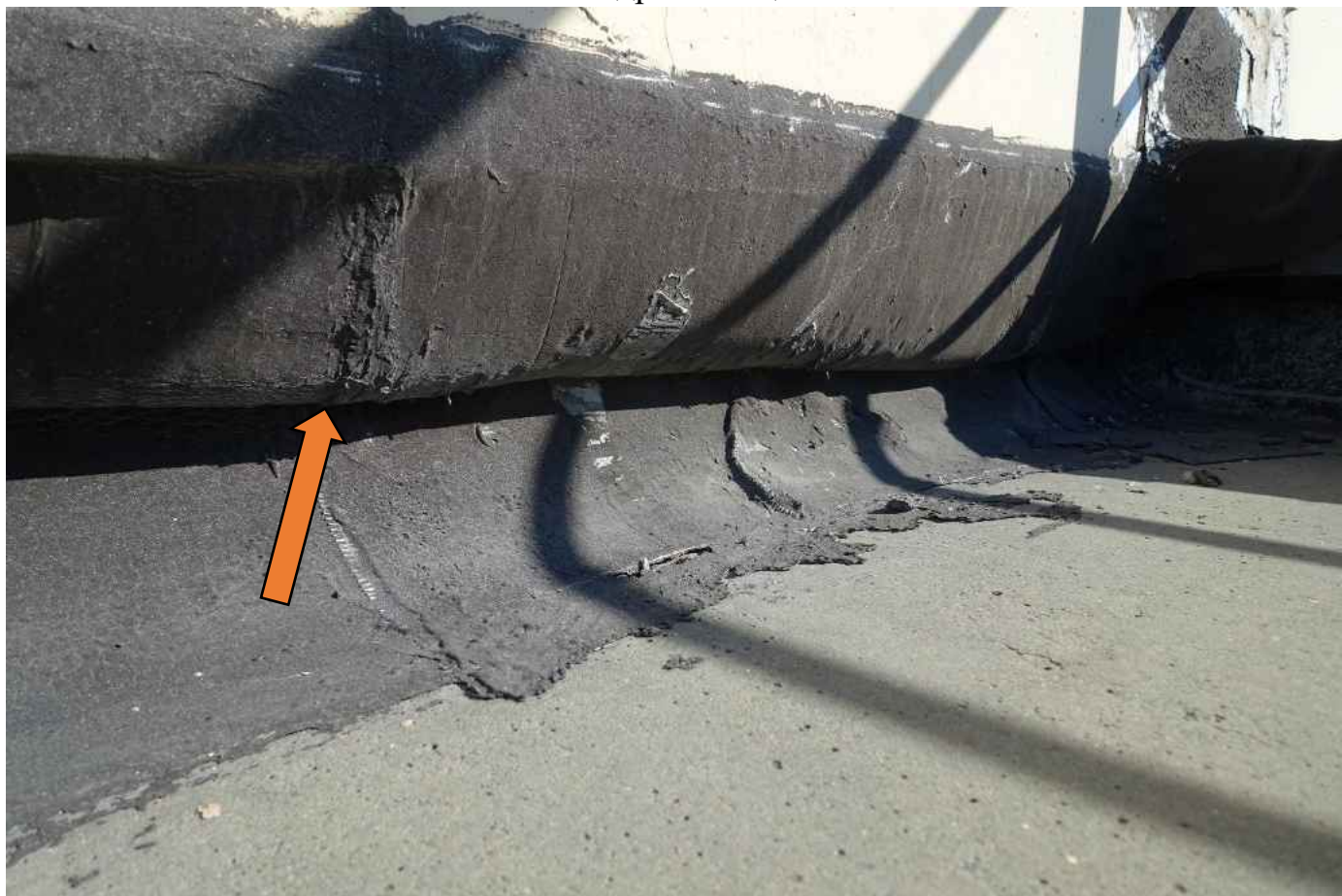
Фото 12. Не качественно наклеенная гидроизоляция.
