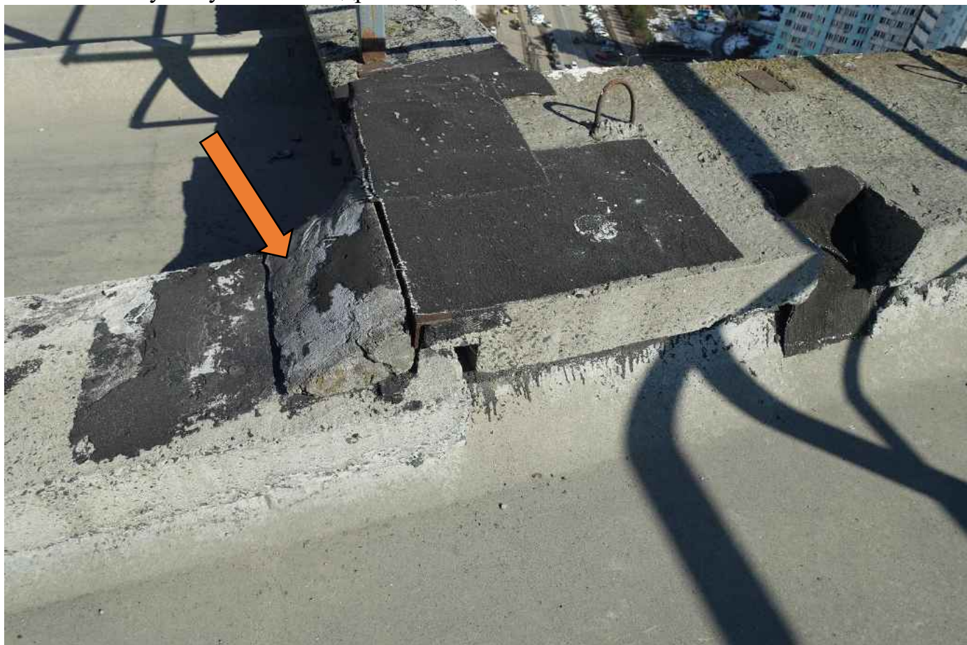
Фото 44. Гидроизоляция - не допустимое состояние.
