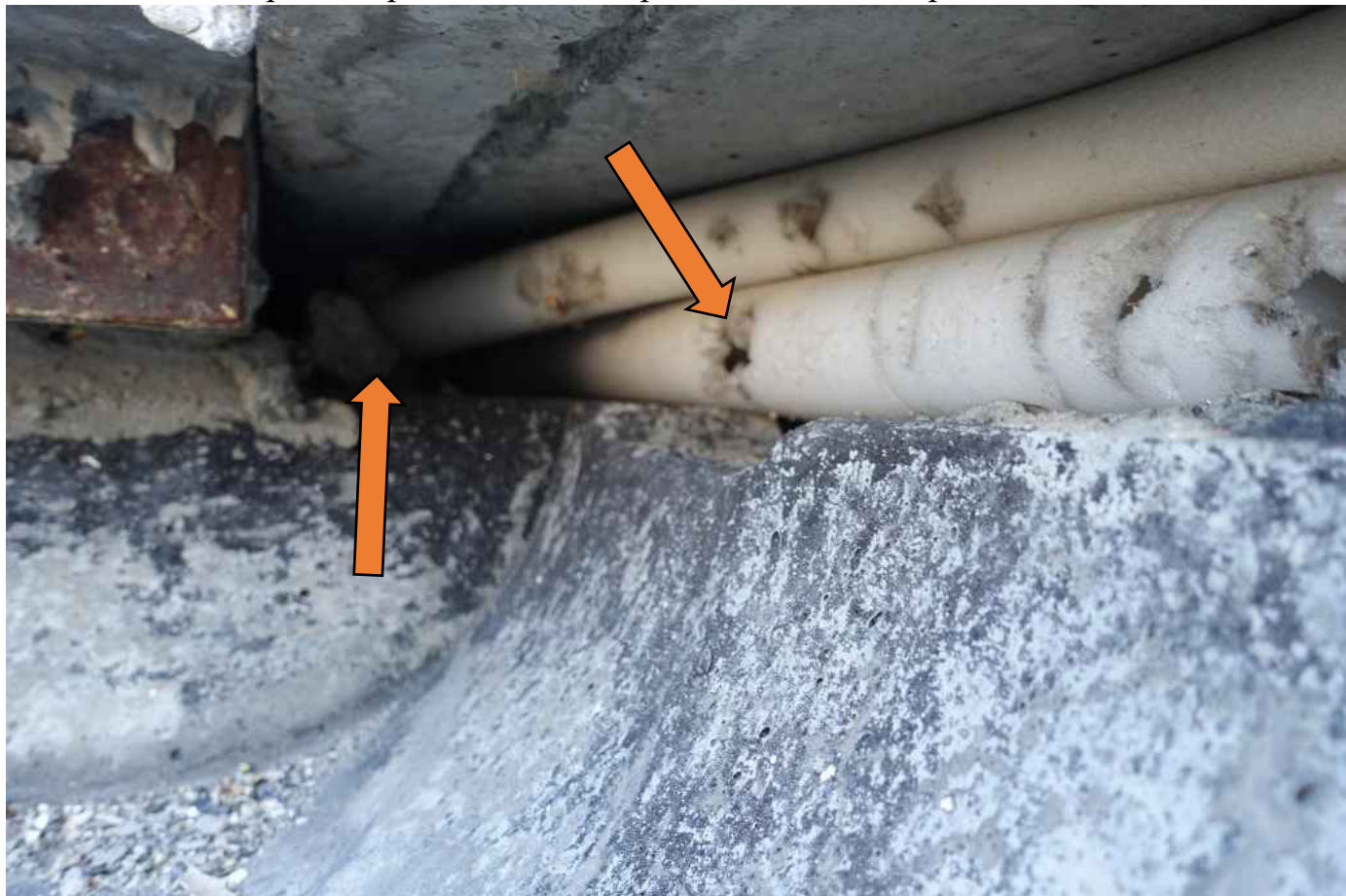
Фото 120. Мусор в виде остатков раствора. Гидроизол в недопустимом состоянии.
