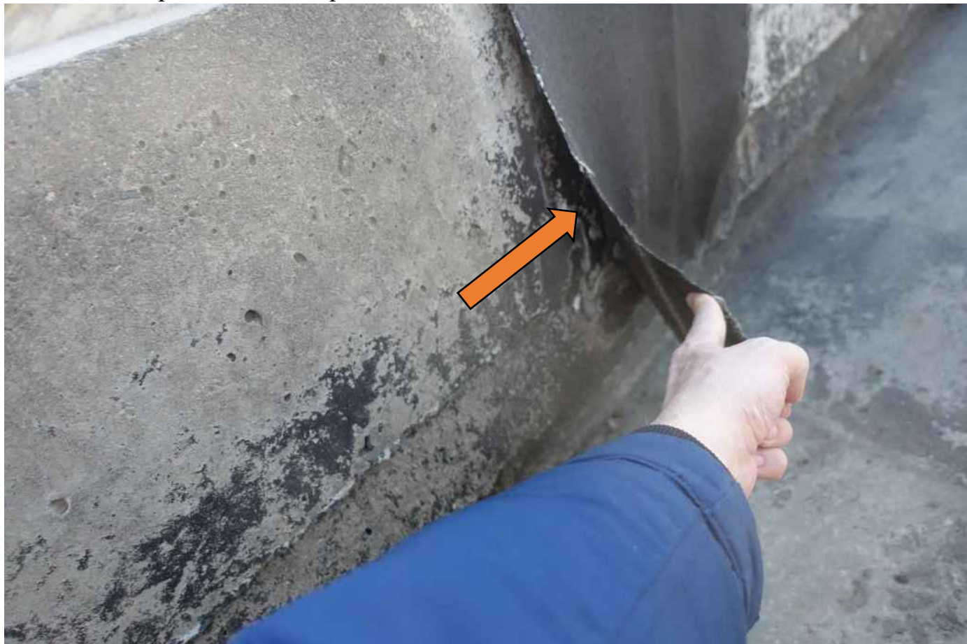
Фото 20. Осмотр лотка водотока. Покрытие из состава на битумной основе изношено.
