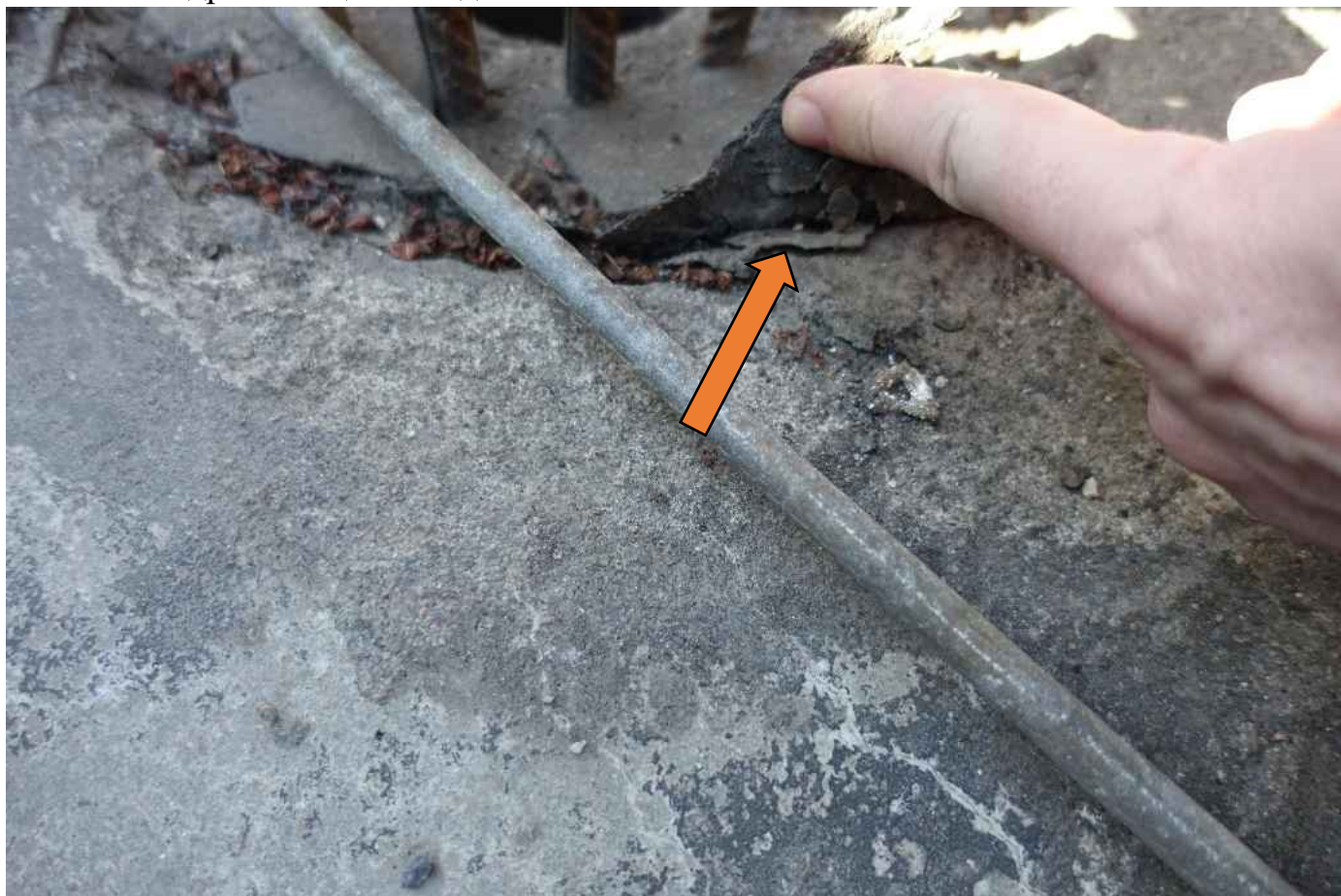
Фото 18. Гидроизоляция отходит от основания.
