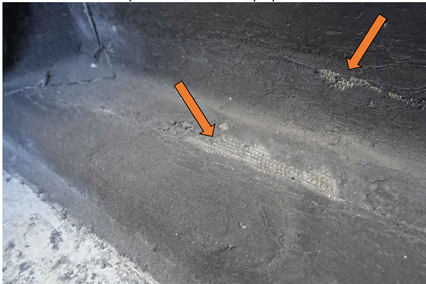
Фото 62. Изношенная гидроизоляция, виден слой армированной сетки.
