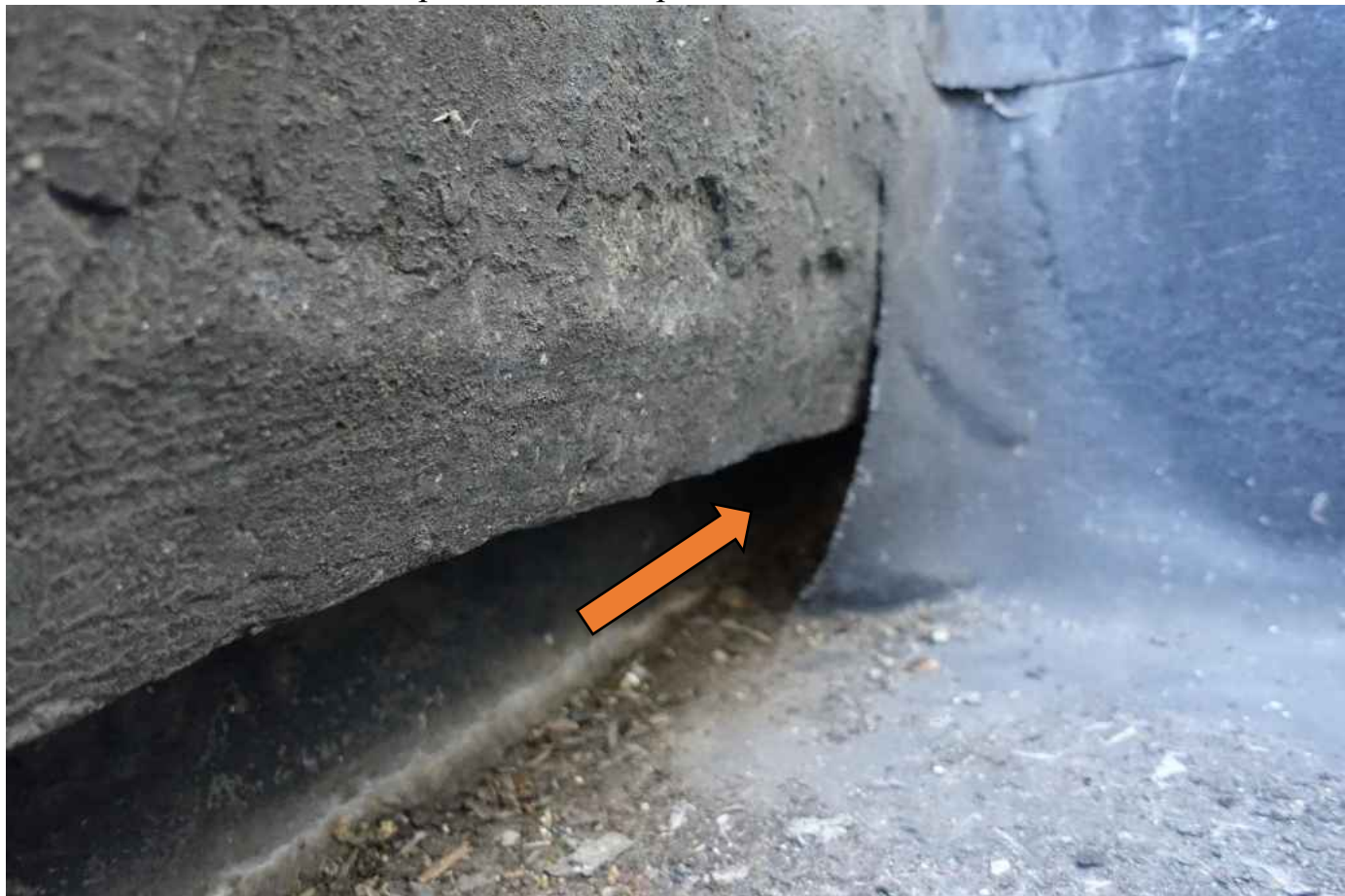
Фото 78. Не качественно проклеенная гидроизоляция. Примыкание не закрыто.
