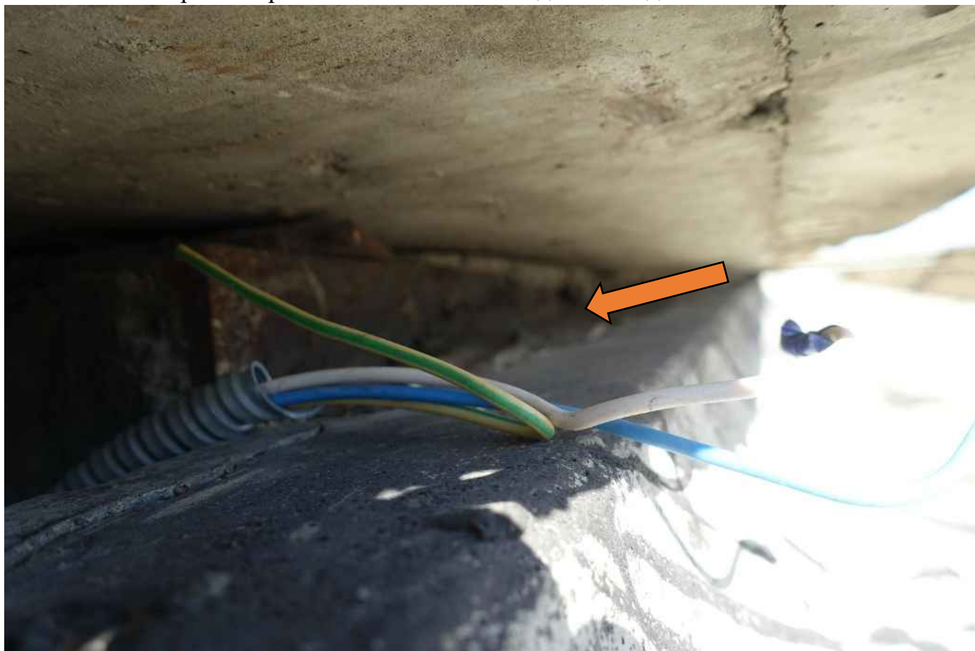
Фото 88. Не закрытое примыкание. Места попадания осадков.
