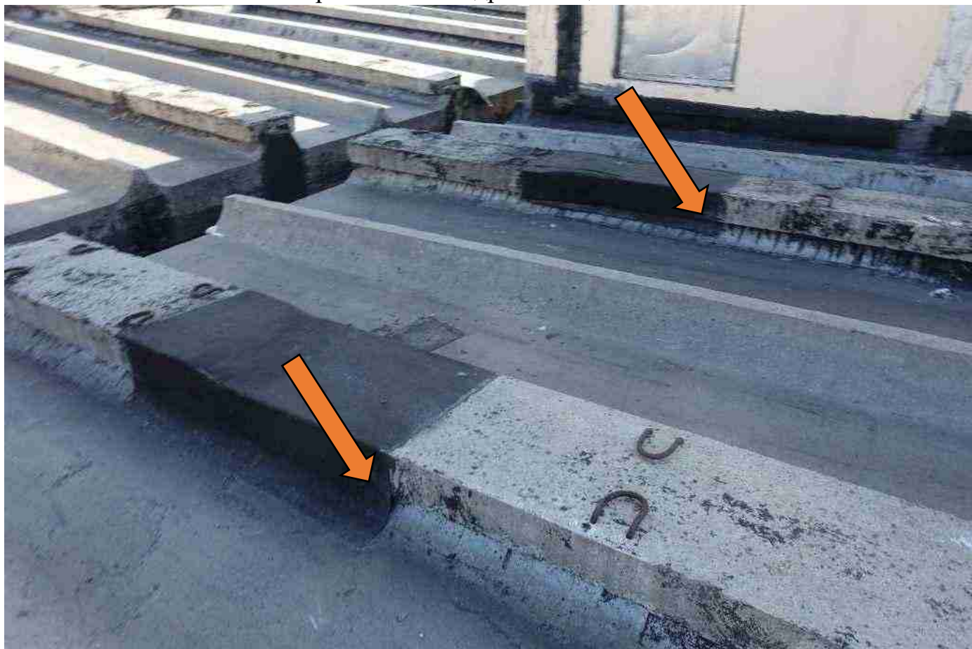
ь ото 6562х е качественно проклеенная гидроизоляция2
