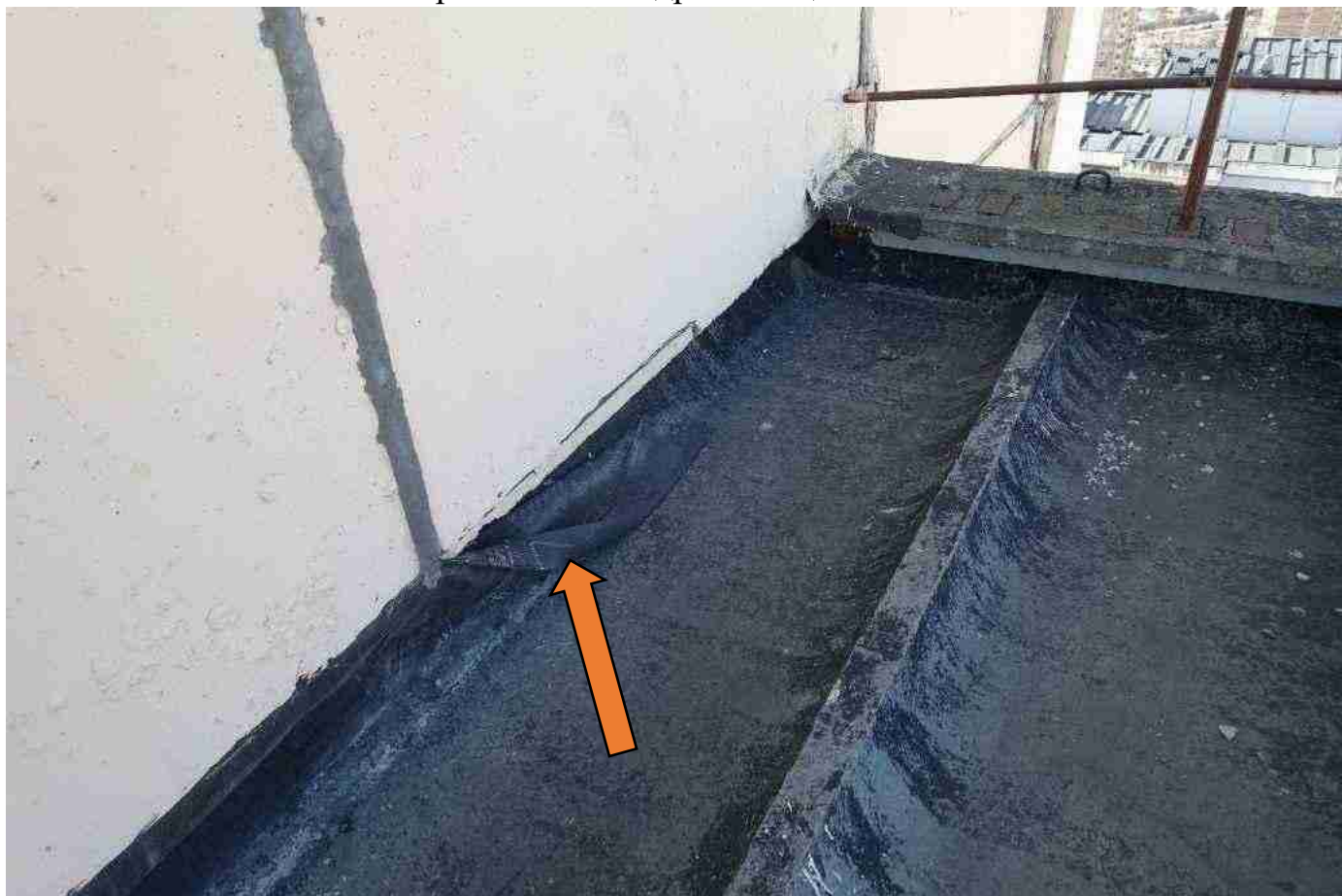
ь ото 6942х е закрытое примыкание от осадков2
