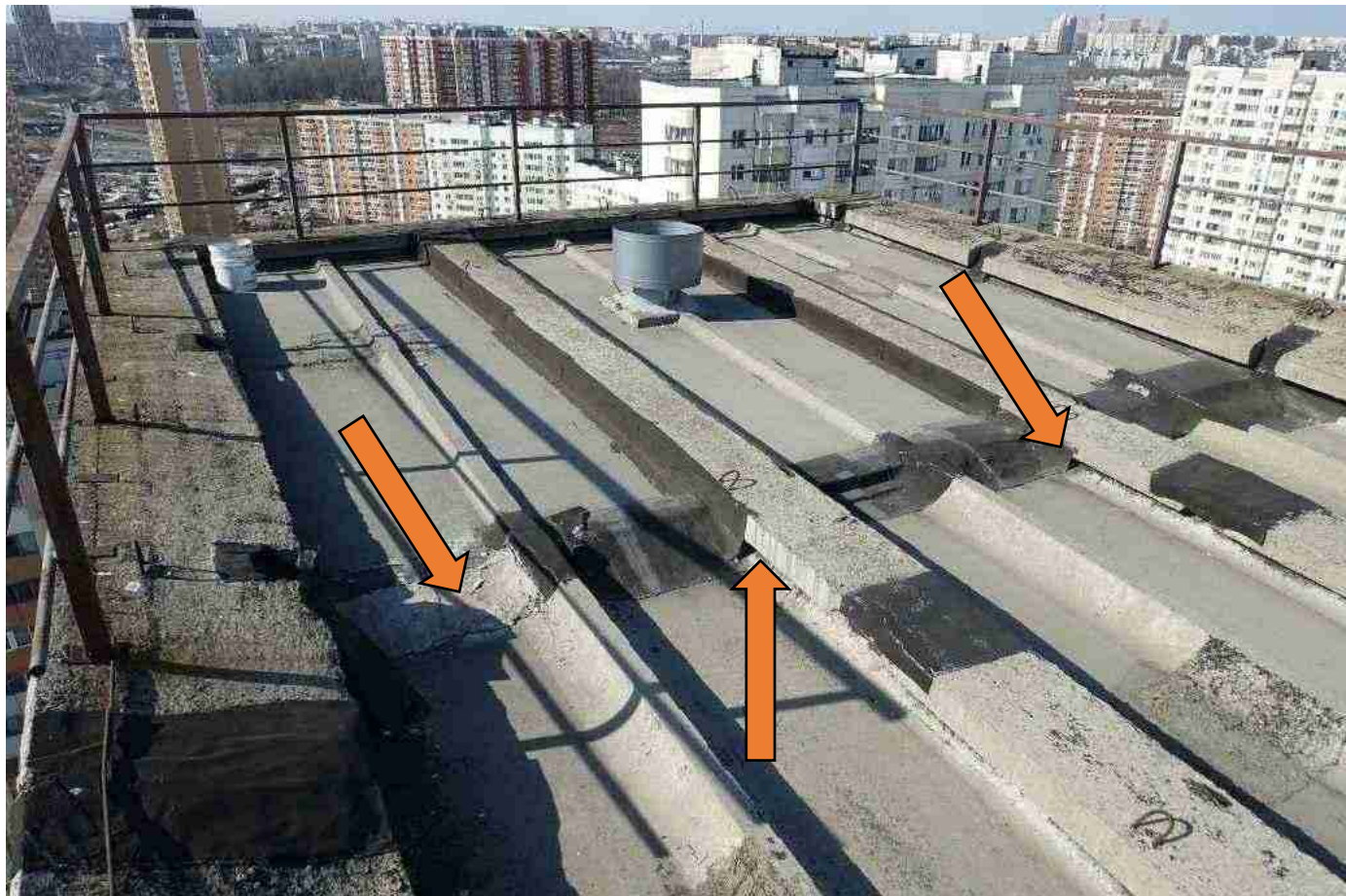
Б ото 6: 92х е качественно проклеенная гидроизоляция2
