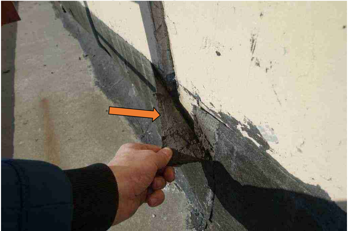
ь ото 6782х е качественно проклеенная гидроизоляция2
