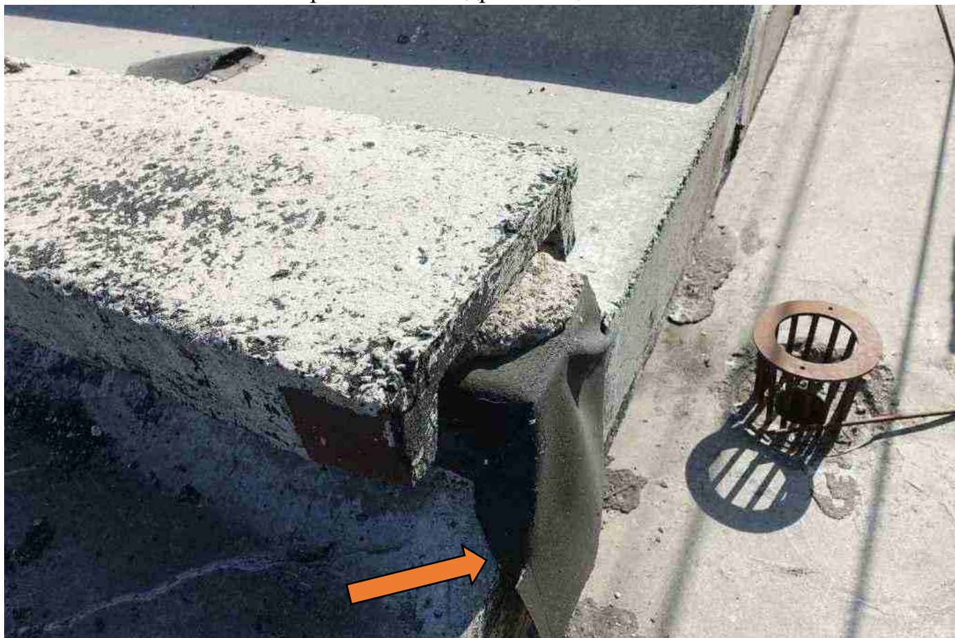
ь ото 6782х е качественно проклеенная гидроизоляция2
