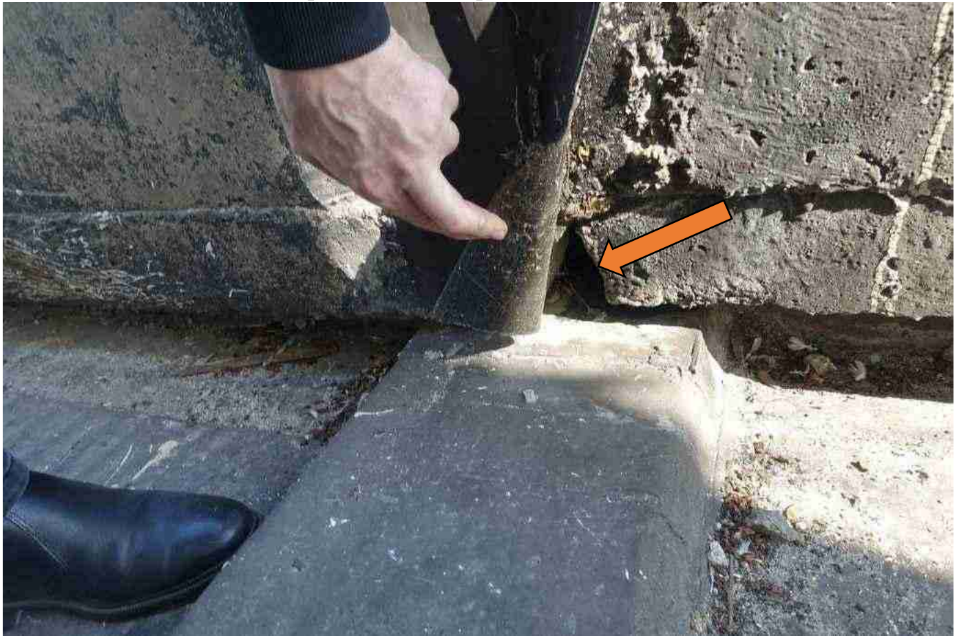
ь ото 6972х е качественно проклеенная гидроизоляция2
