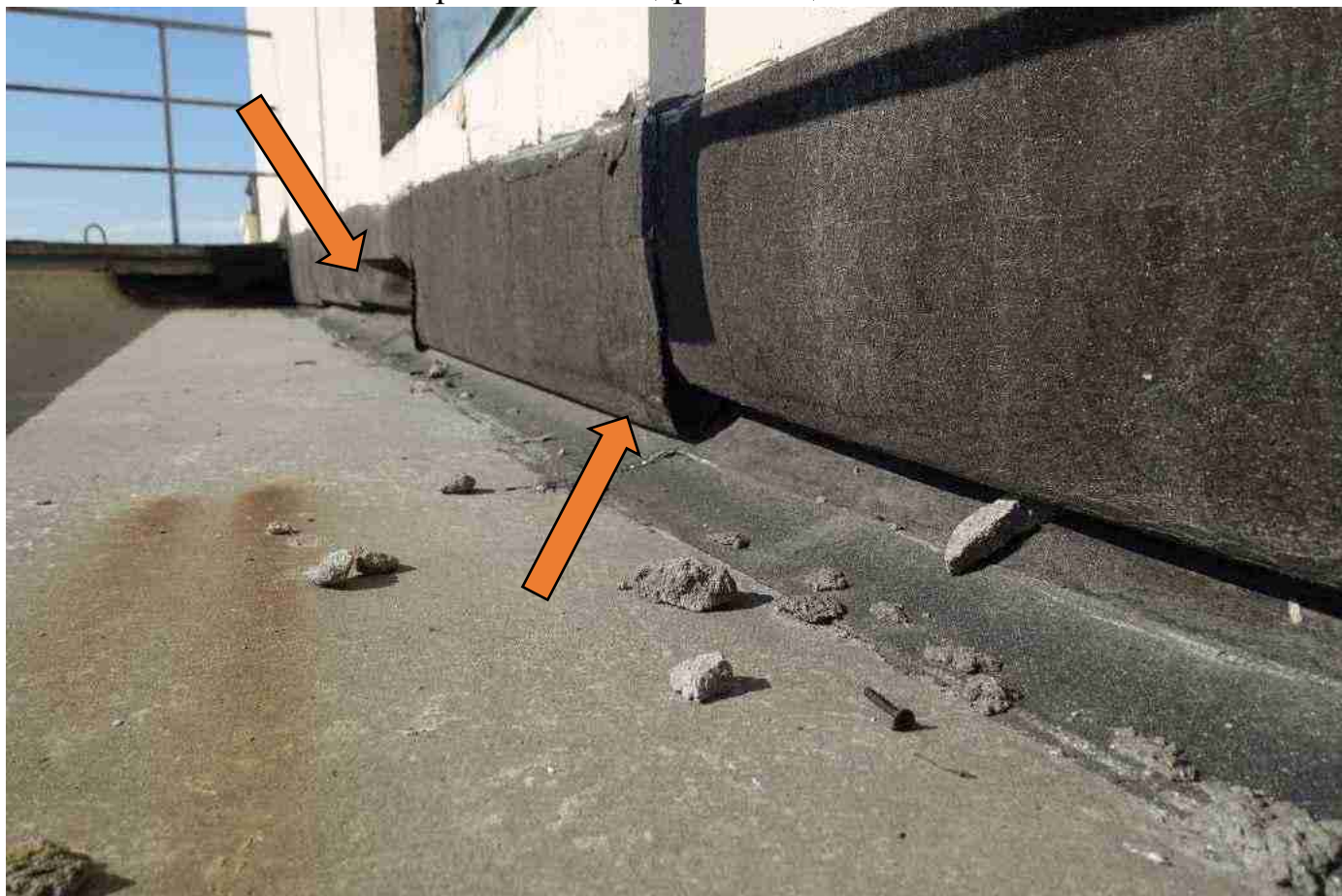
ь ото 65: 2х е качественно проклеенная гидроизоляция2
