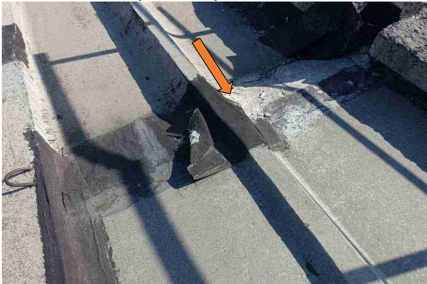
ь ото 6: 82х е качественно проклеенная гидроизоляция2
