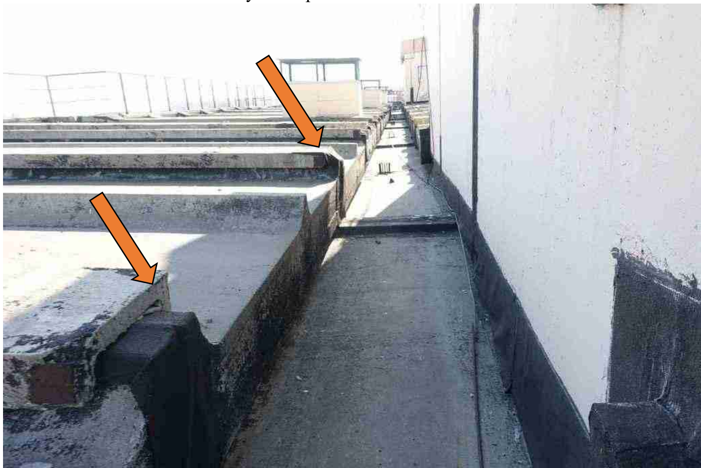
ь ото 6682пазное исполнение узлов примыкания2
