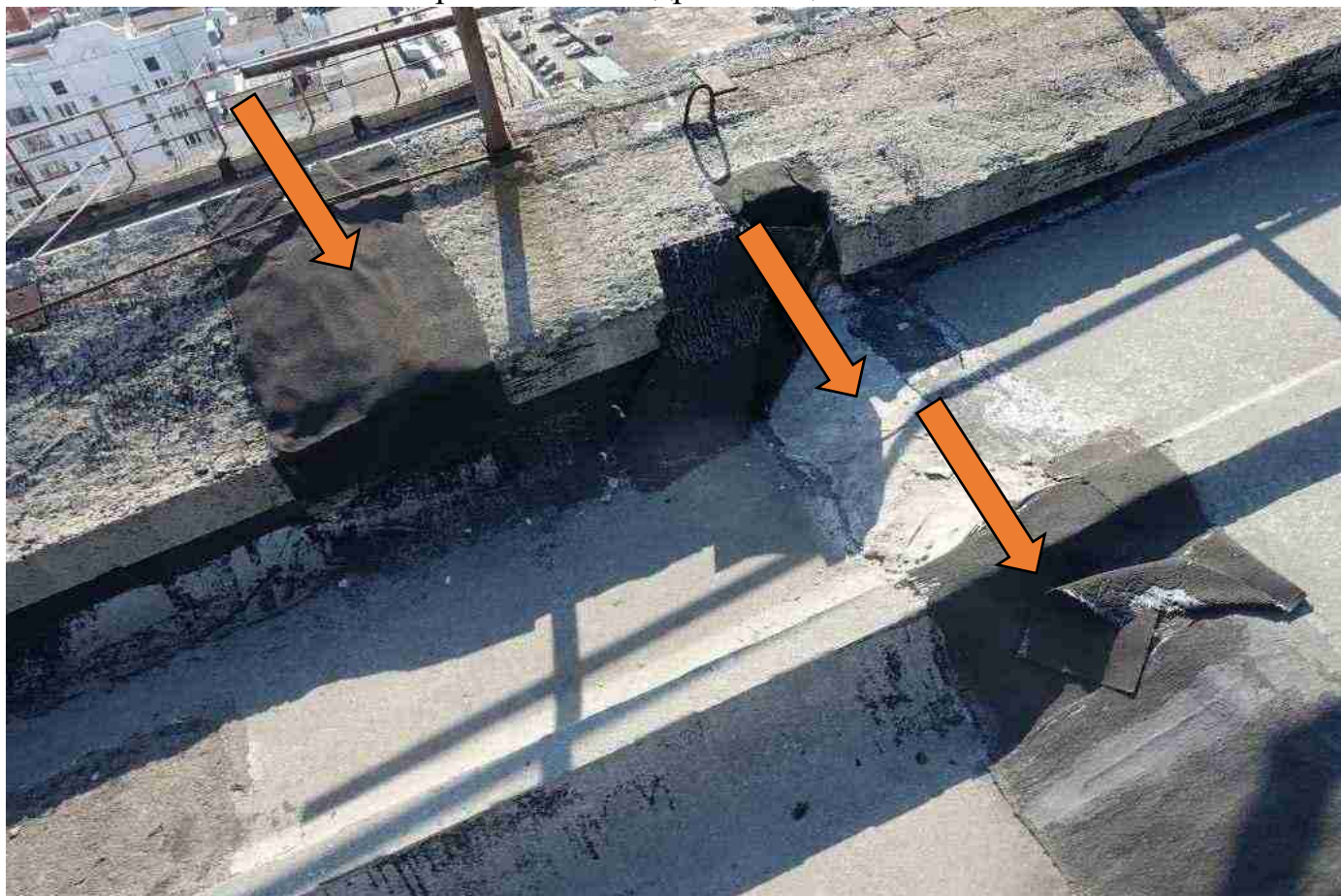
Б ото 6: 92х е качественно проклеенная гидроизоляция2
