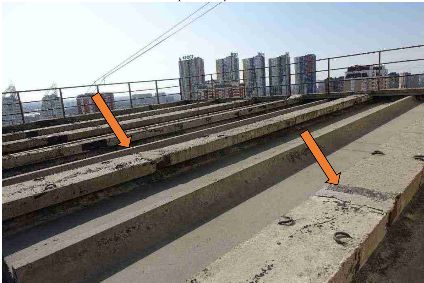
ь ото 6: 52ц бщий вид2щтыки не закрыты гидроизоляцией2
