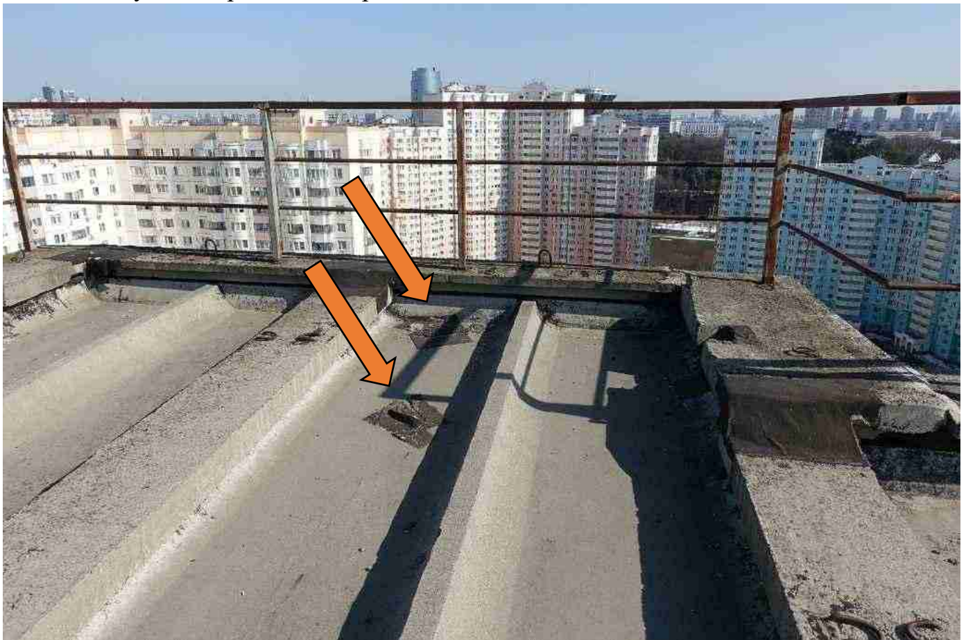
ь ото 5962т е уски оторванной гидроизоляции2
