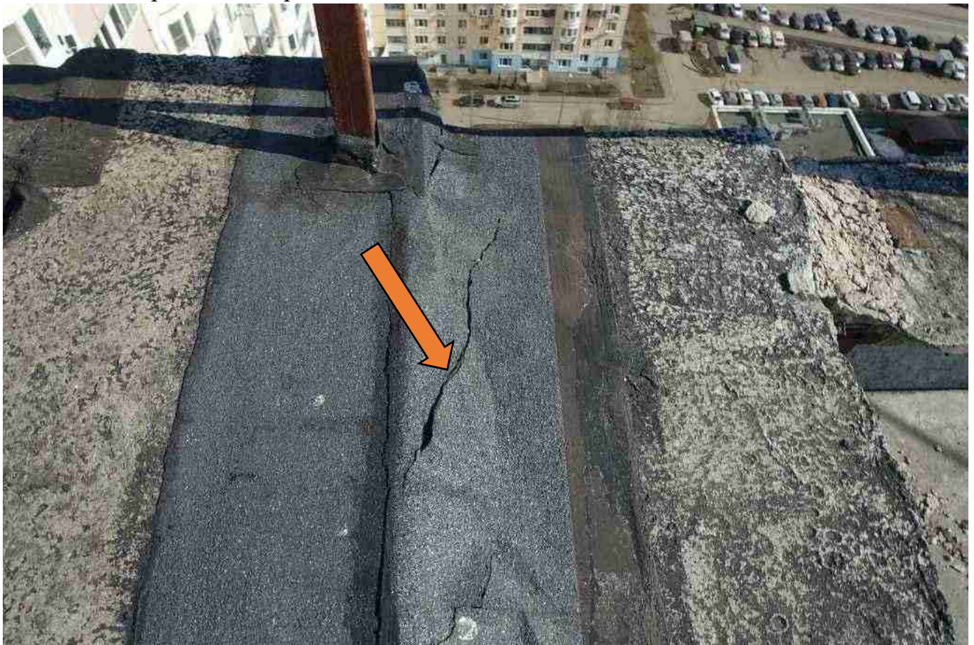
ь ото 5882ч орванная гидроизоляция2
