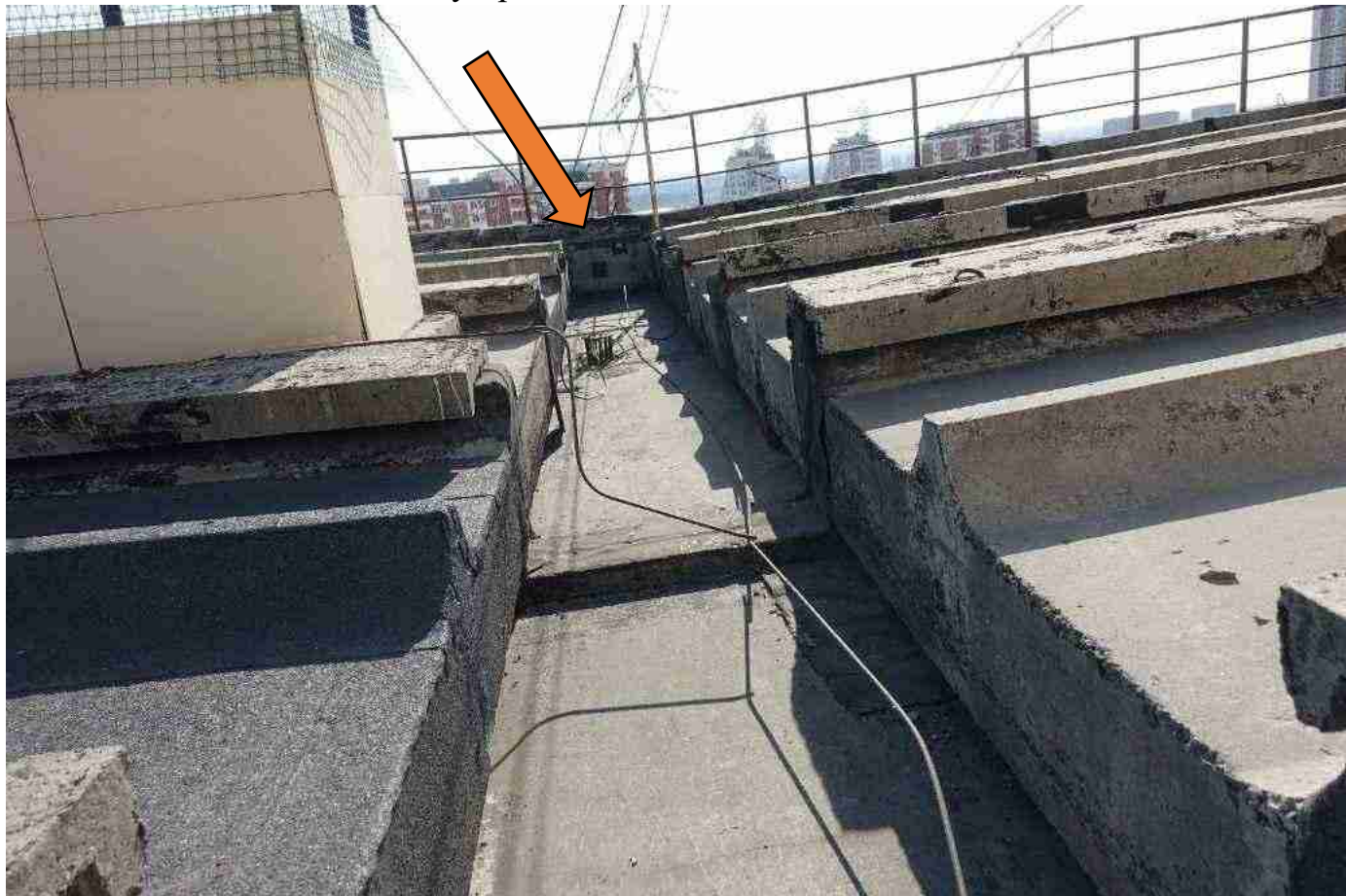
ь ото 6: 52ц бщий вид2щтыки не закрыты гидроизоляцией2
