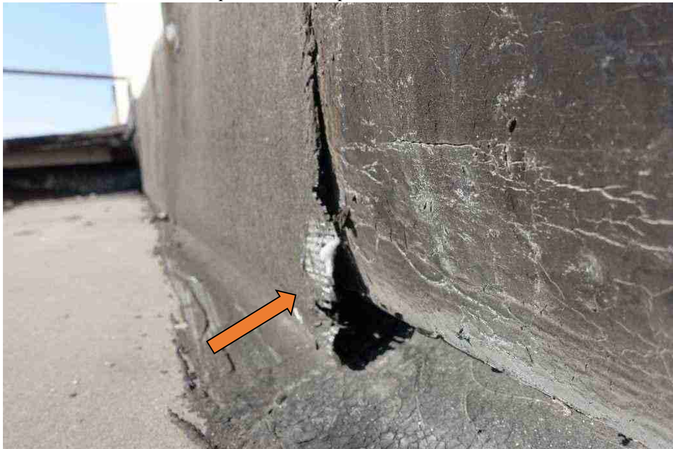
ь ото 6842х е качественно проклеенная гидроизоляция2
