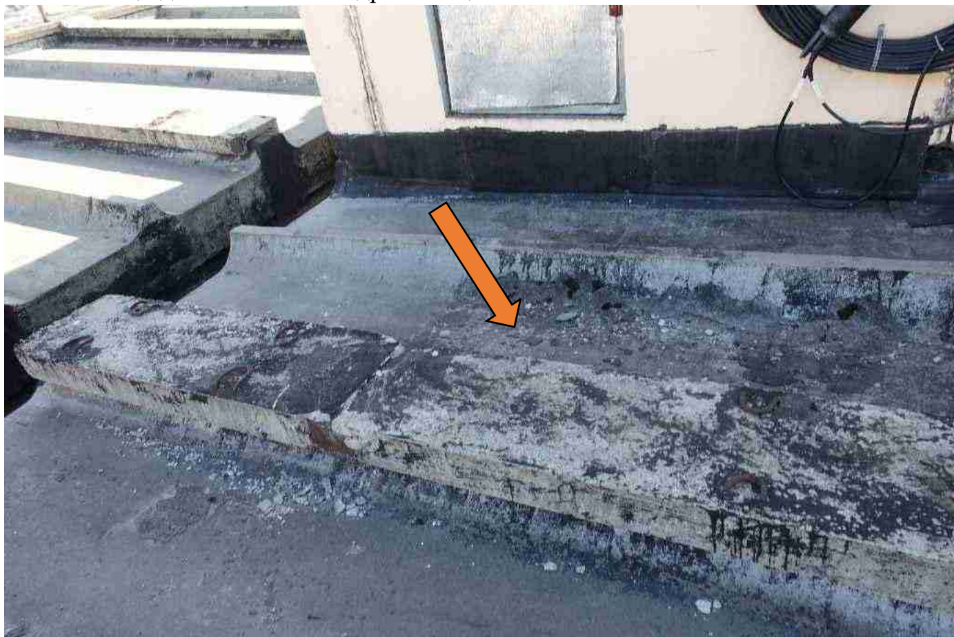
ь ото 6682щеды обмазочной гидроизоляции2
