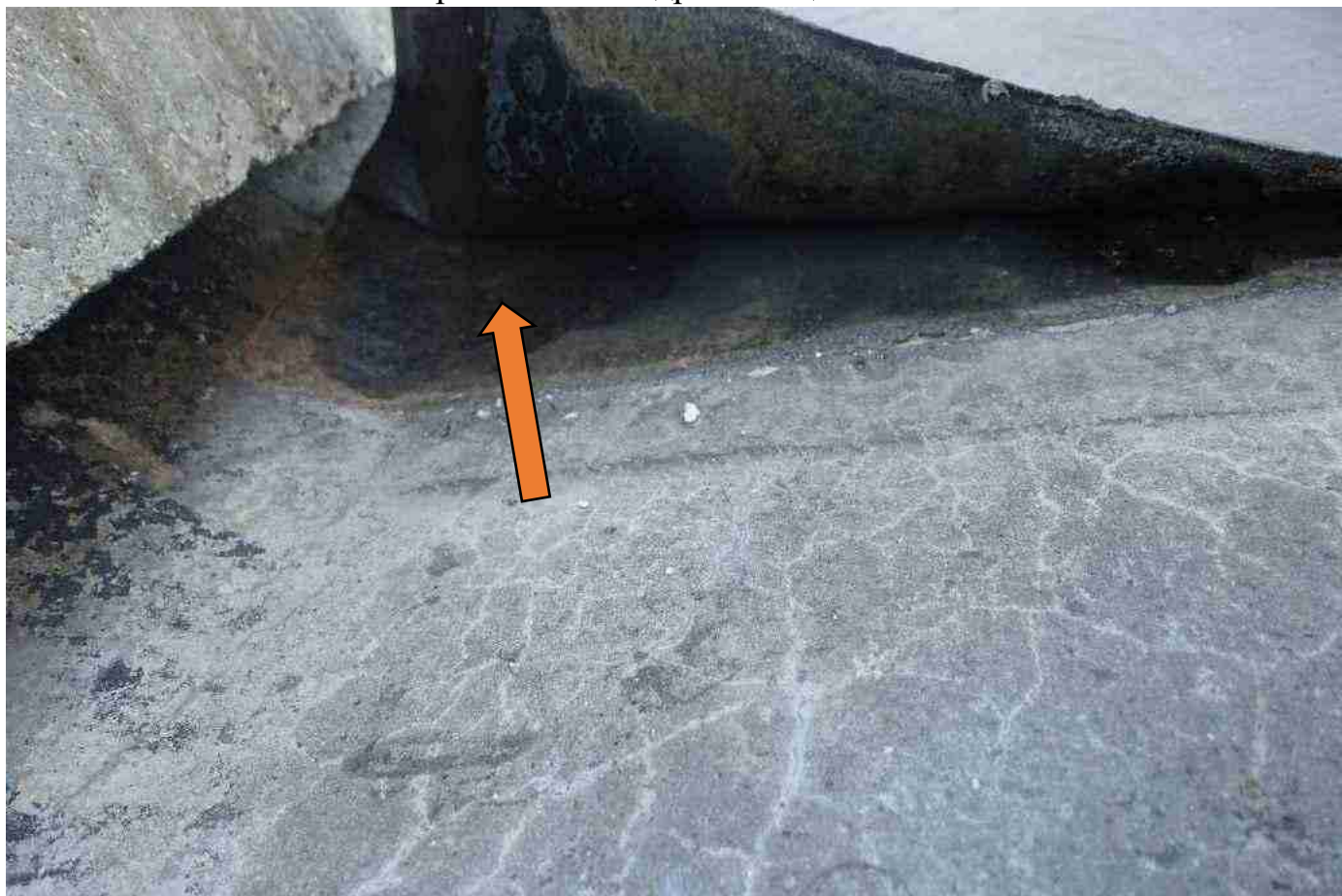
ь ото 6972х е качественно проклеенная гидроизоляция2
