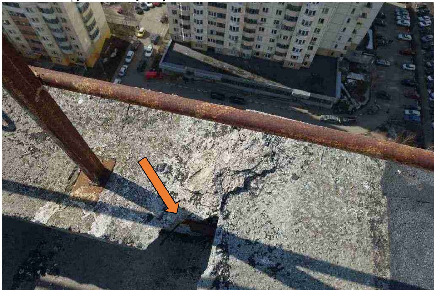
ь ото 6482пазрушение0отсутствует часть плиты2
