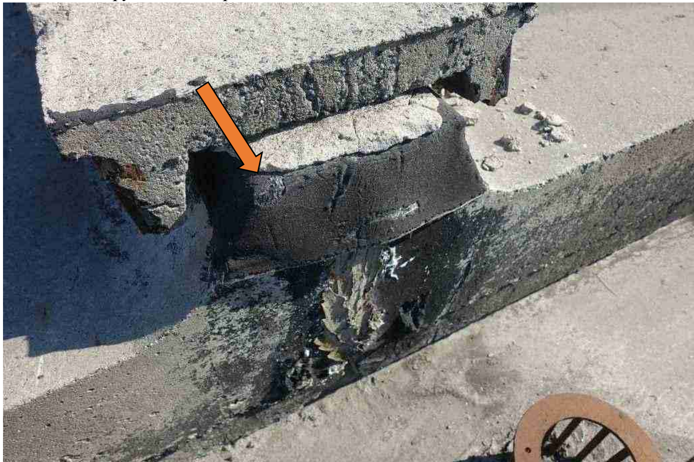
ь ото 6842х е качественно проклеенная гидроизоляция2
