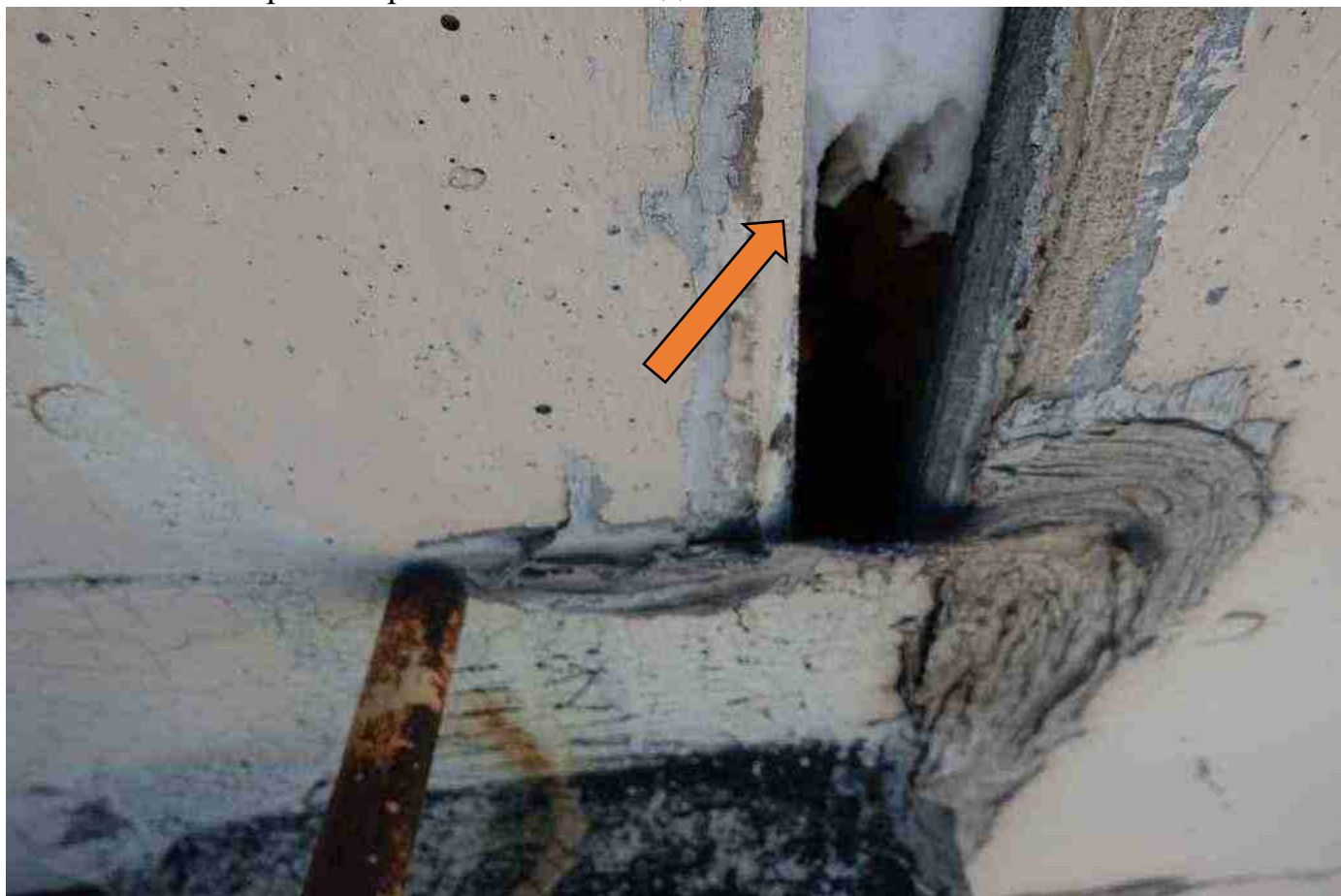
ь ото 6942х е закрытое примыкание от осадков2
