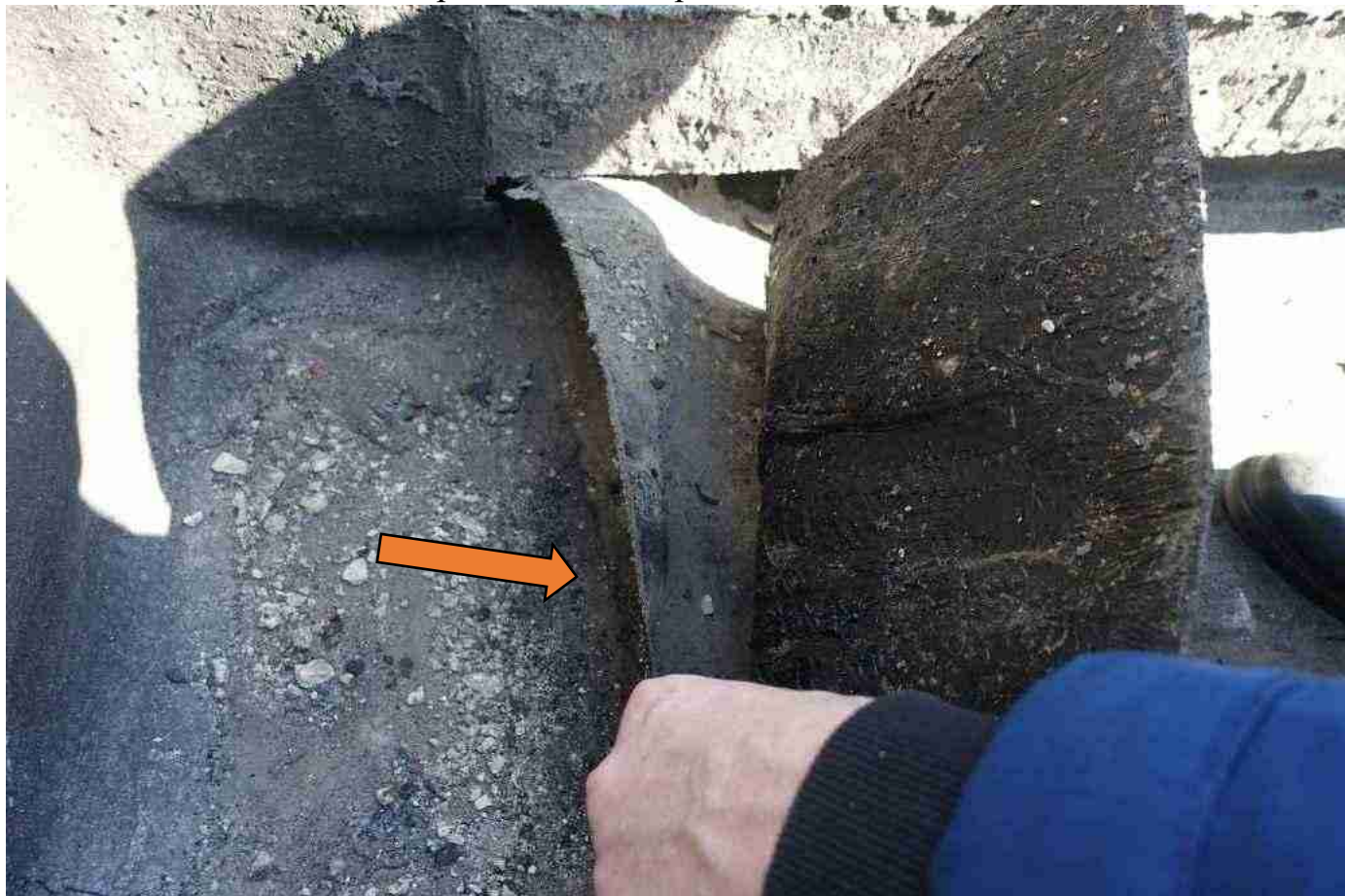
ь ото 6862х е качественно проклеенная гидроизоляция2
