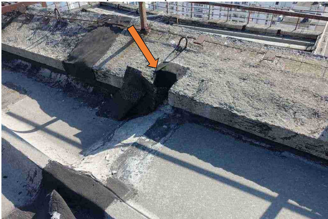
ь ото 6: 82х е качественно проклеенная гидроизоляция2
