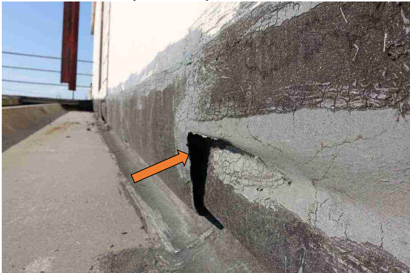
ь ото 65: 2х е качественно проклеенная гидроизоляция2
