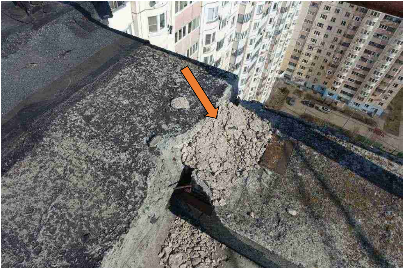
ь ото 5882ч орванная гидроизоляция2
