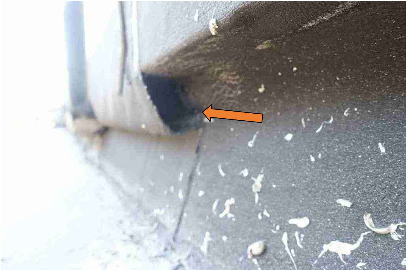
ь ото 6972х е качественно проклеенная гидроизоляция2
