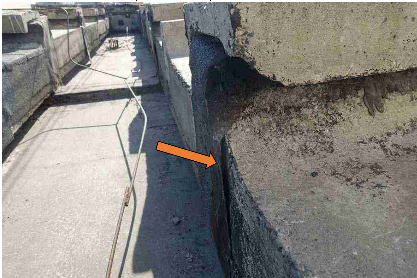
ь ото 6992х е качественно проклеенная гидроизоляция2
