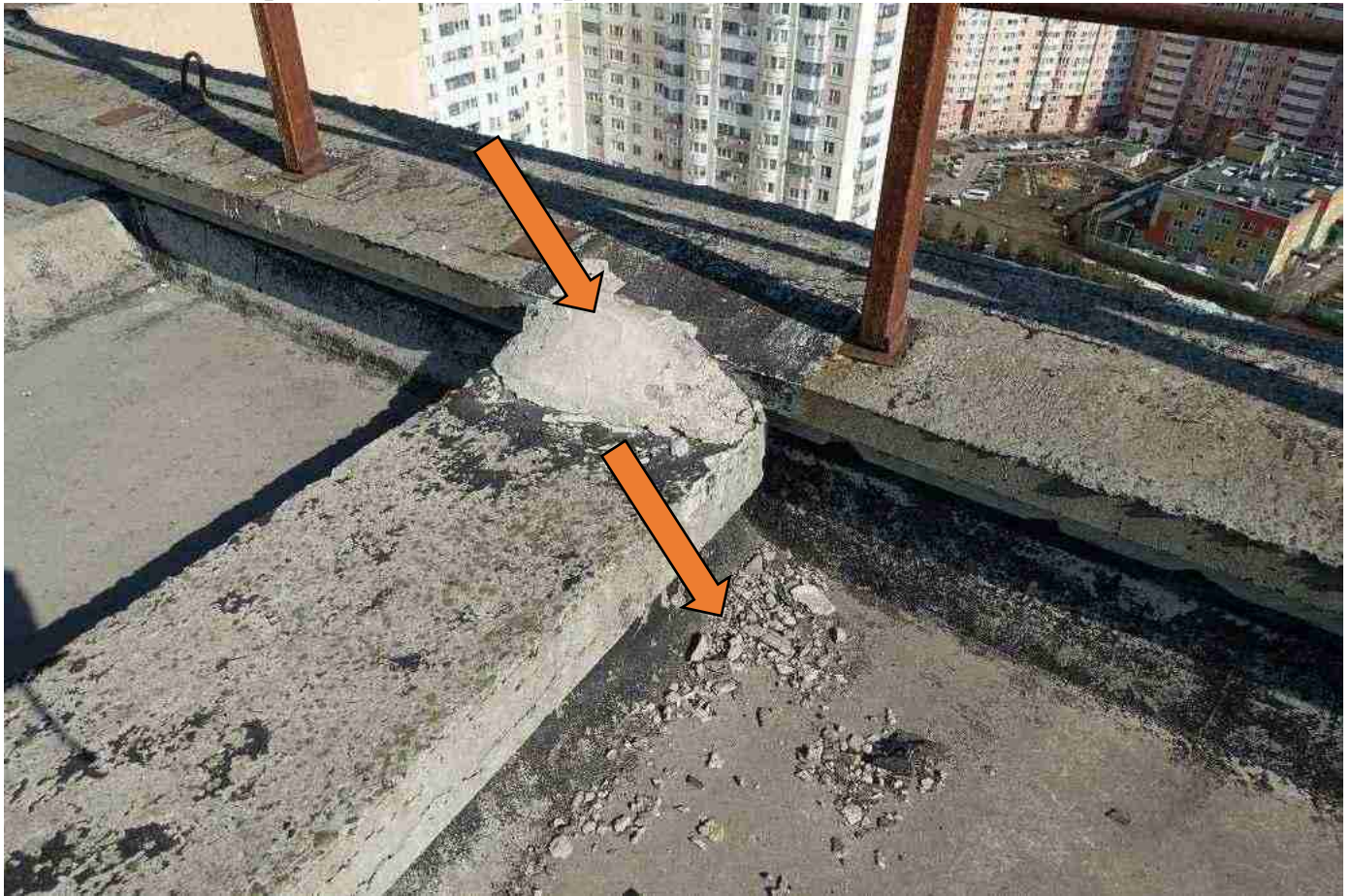
ь ото 5962т е уски оторванной гидроизоляции2
