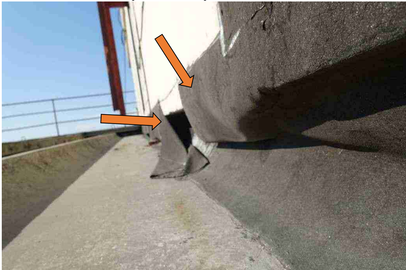
ь ото 6992х е качественно проклеенная гидроизоляция2
