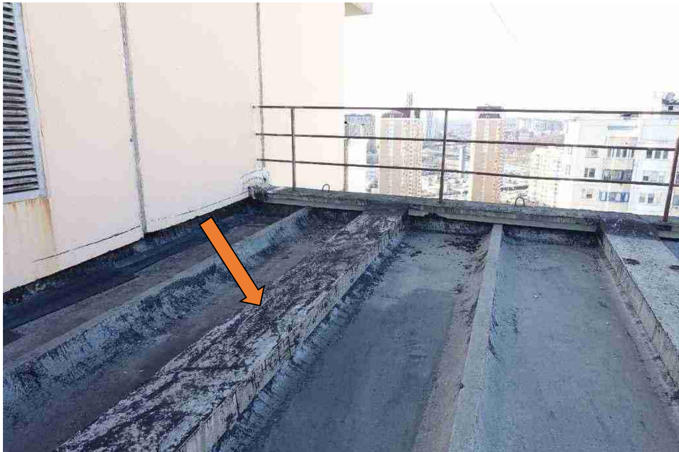
Б ото 66: 2х е качественно проклеенная гидроизоляция Отклеилась от основания2
