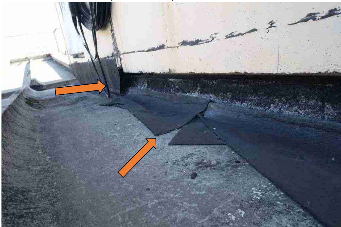
ь ото 6682пазное исполнение узлов примыкания2
