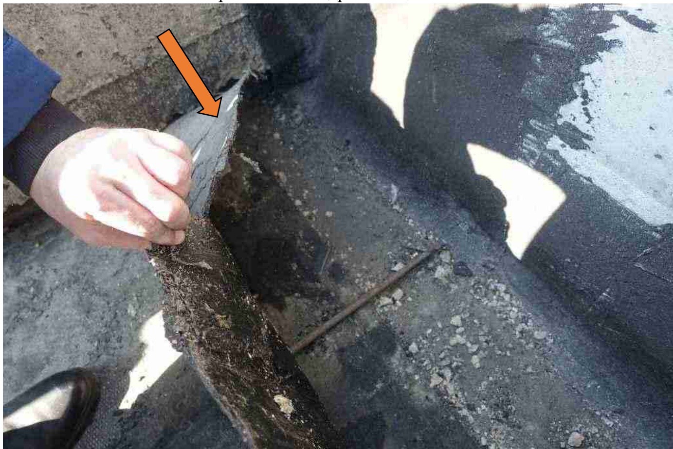
ь ото 6842х е качественно проклеенная гидроизоляция2
