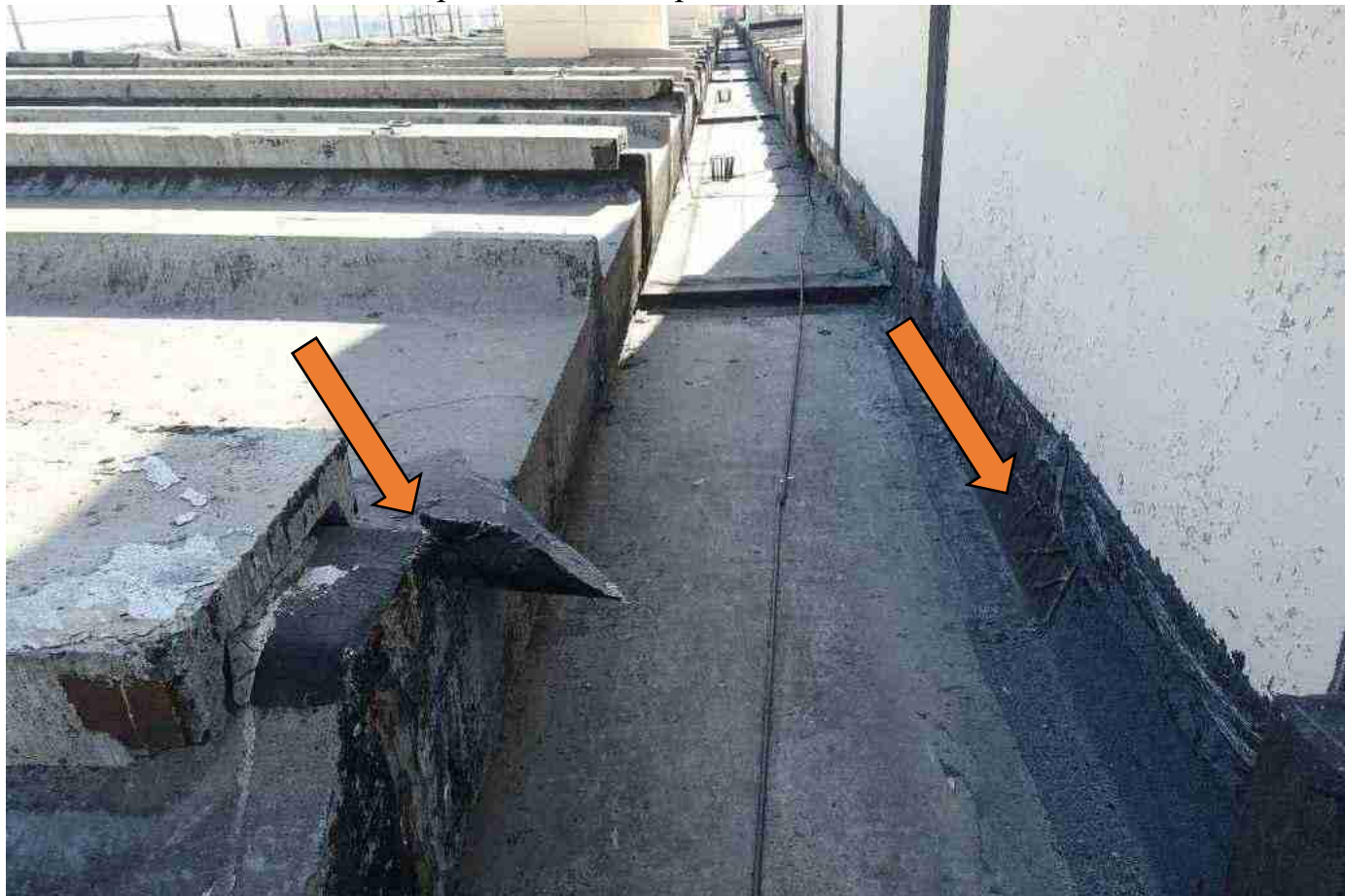
ь ото 6582х е качественно проклеенная гидроизоляция2
