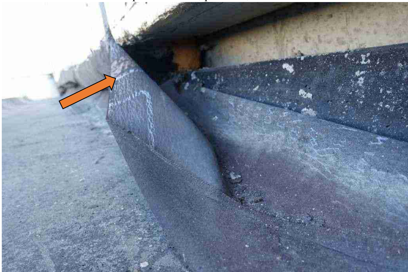
ь ото 6972х е качественно проклеенная гидроизоляция2
