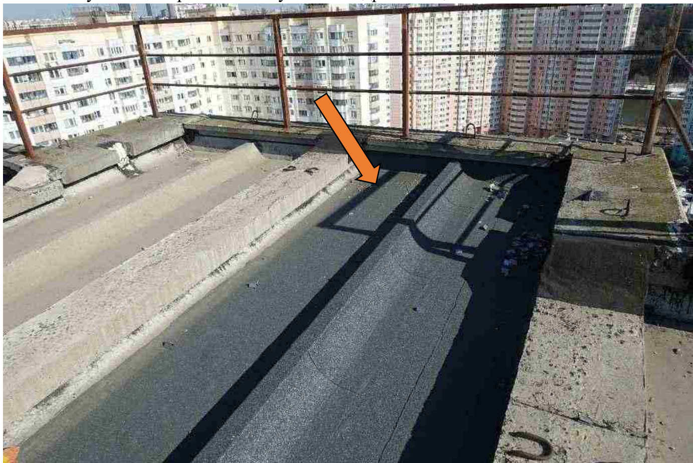
ь ото 5882у окально проклеенный участок гидроизоляцией2
