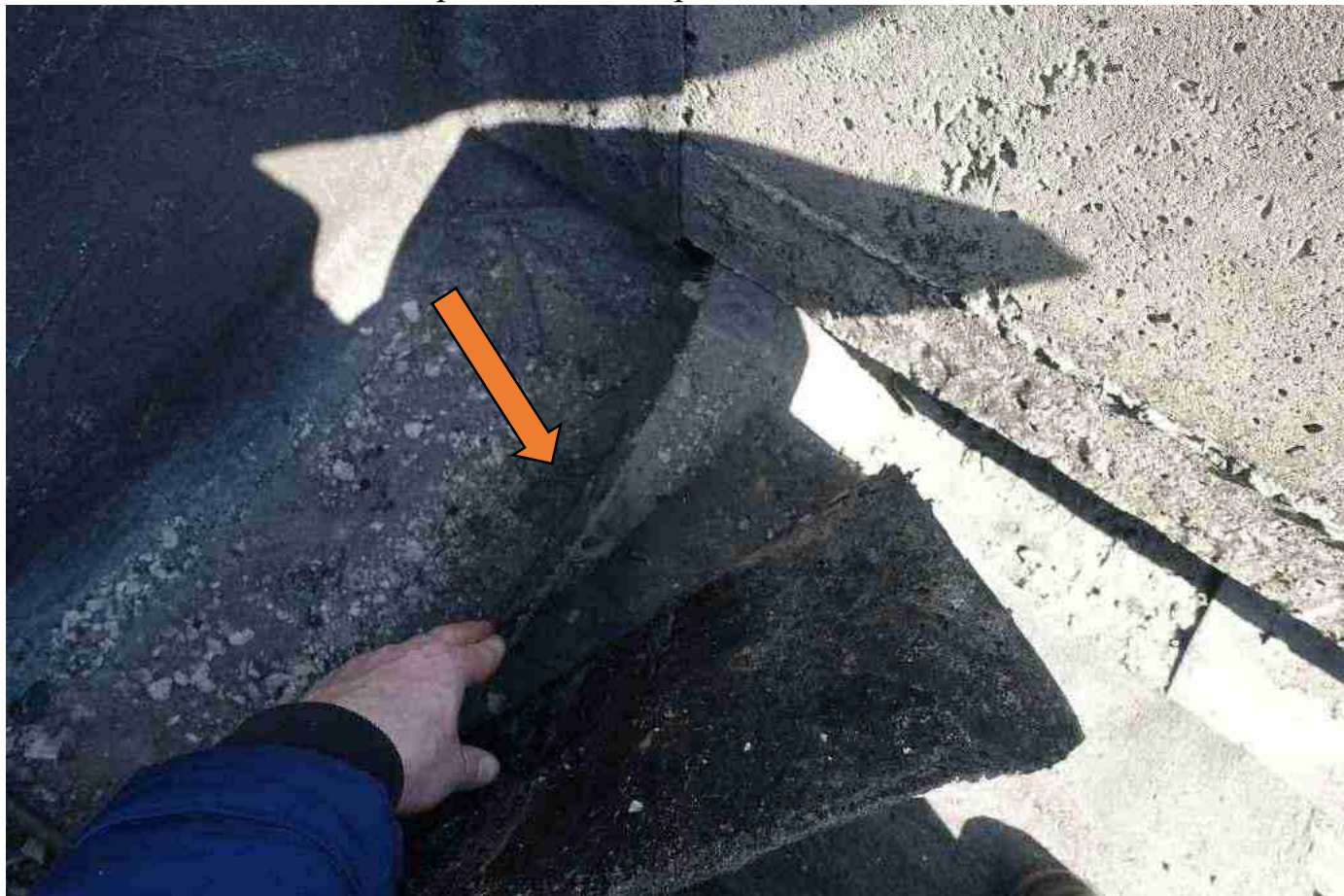
ь ото 6862х е качественно проклеенная гидроизоляция2
