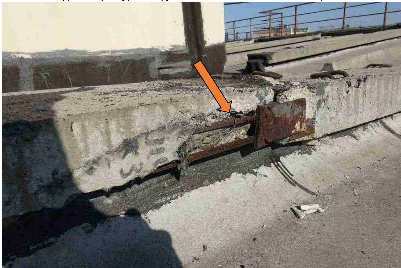
ь ото 6642т оррозия арматуры2пязрушение боковой части плиты покрытия2
