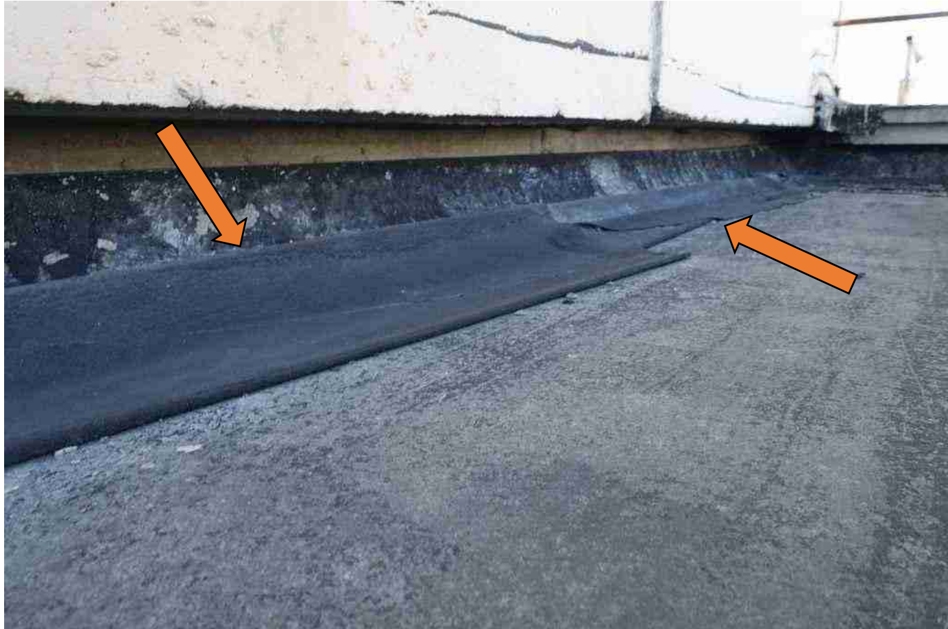
Б ото 66: 2х е качественно проклеенная гидроизоляция Отклеилась от основания2
