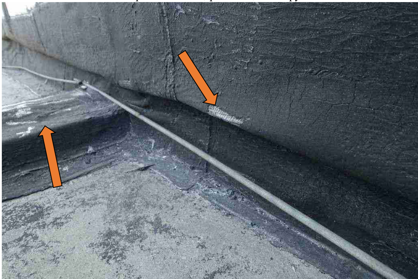
ь ото 6742х е качественно проклеенная гидроизоляция2 пазрушение2
