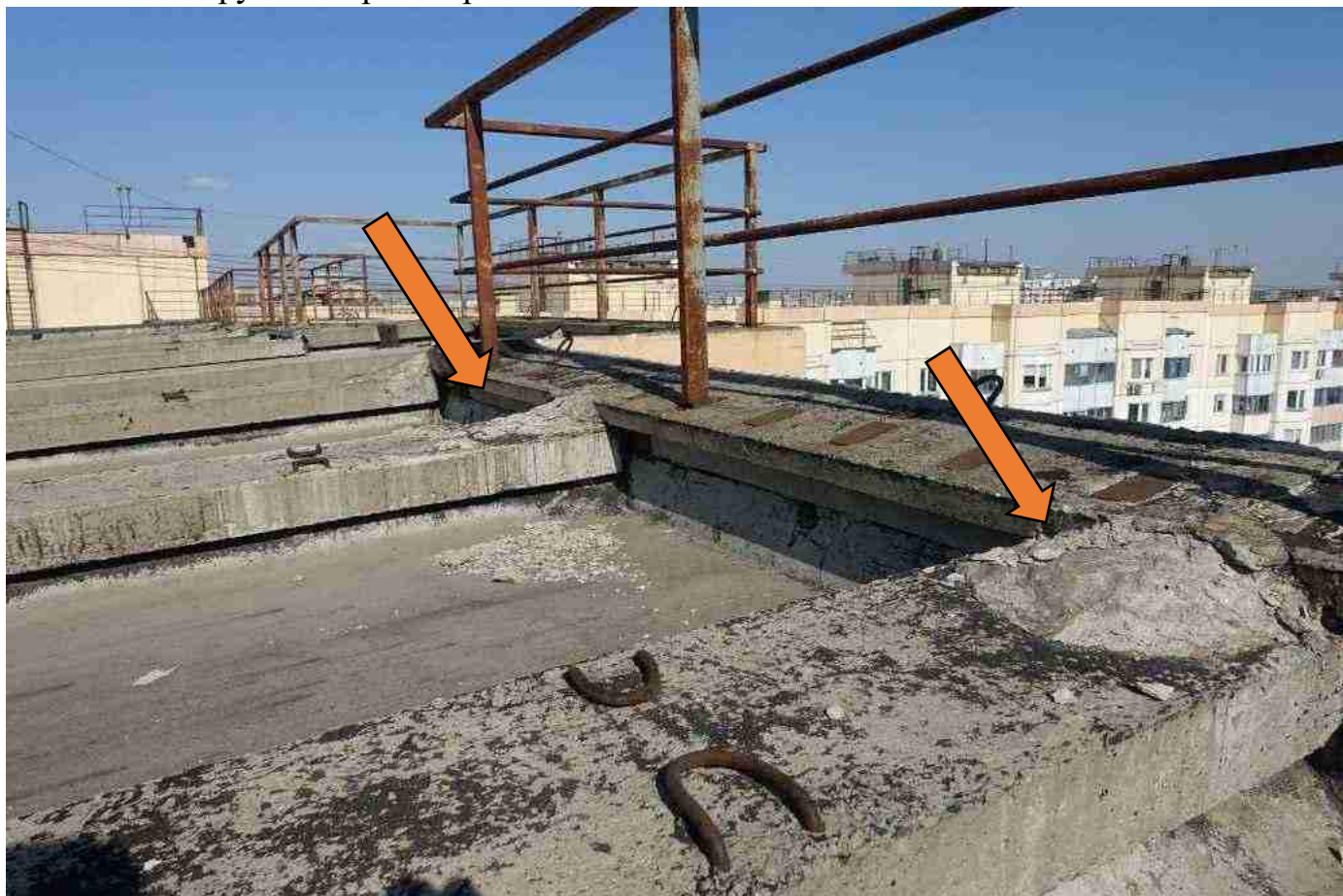
ь ото 5762щазрушение раствора0выравнивающего перепад на стыке плит2
