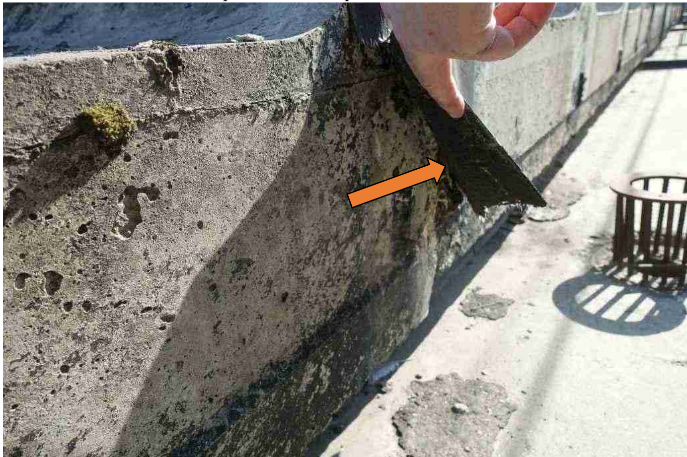
ь ото 6782х е качественно проклеенная гидроизоляция2
