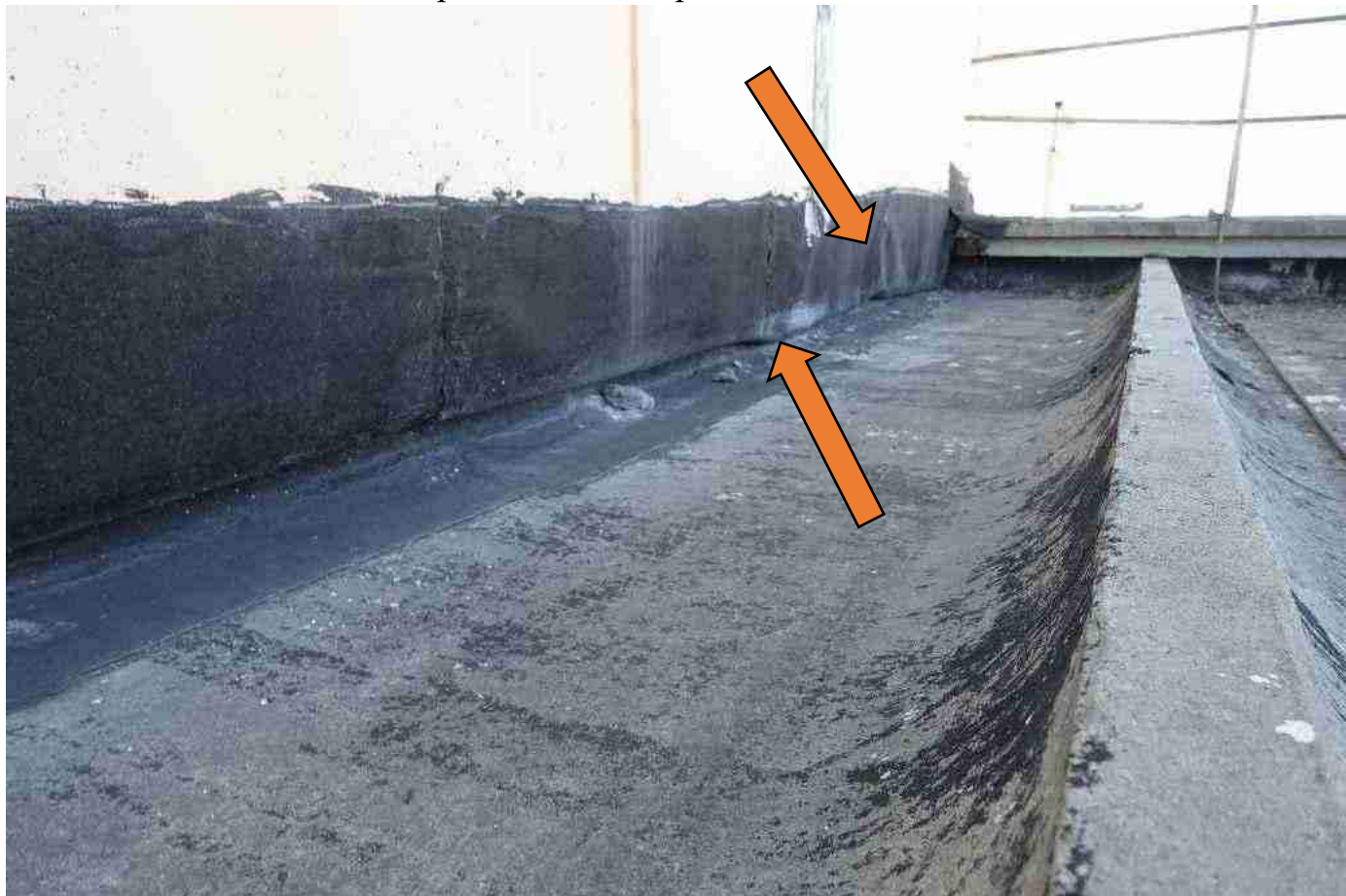
ь ото 6582х е качественно проклеенная гидроизоляция2
