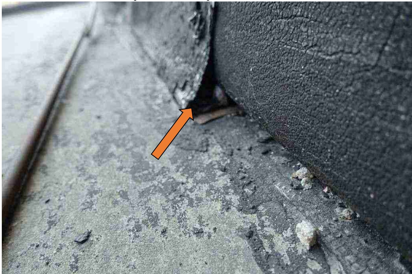
ь ото 6742х е качественно проклеенная гидроизоляция2 пазрушение2
