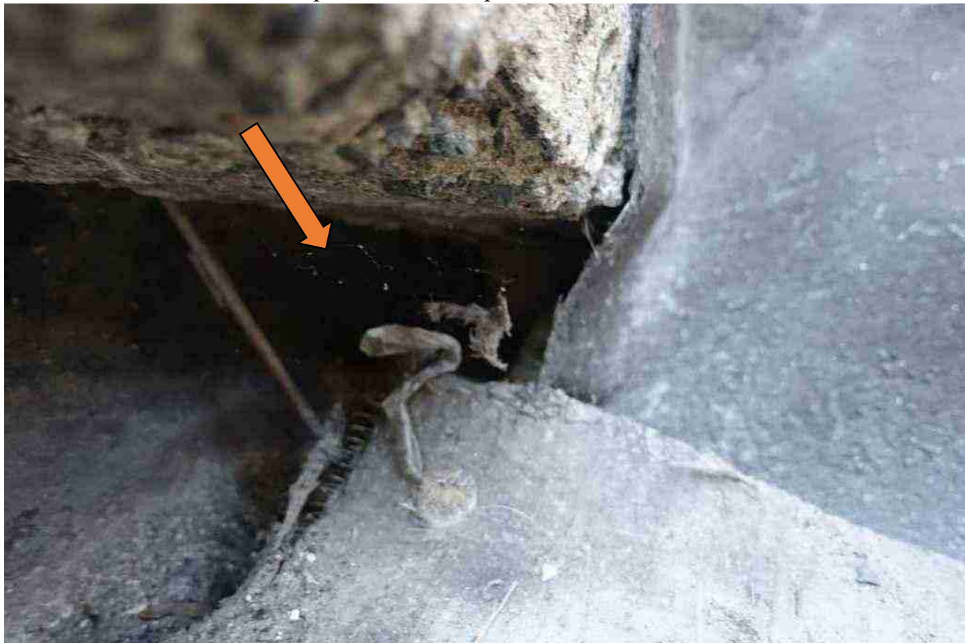
ь ото 6882х е качественно проклеенная гидроизоляция2
