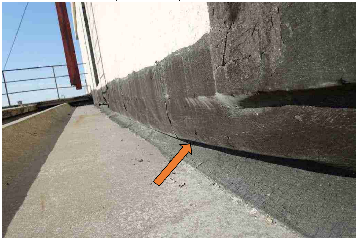
ь ото 67: 2х е качественно проклеенная гидроизоляция2
