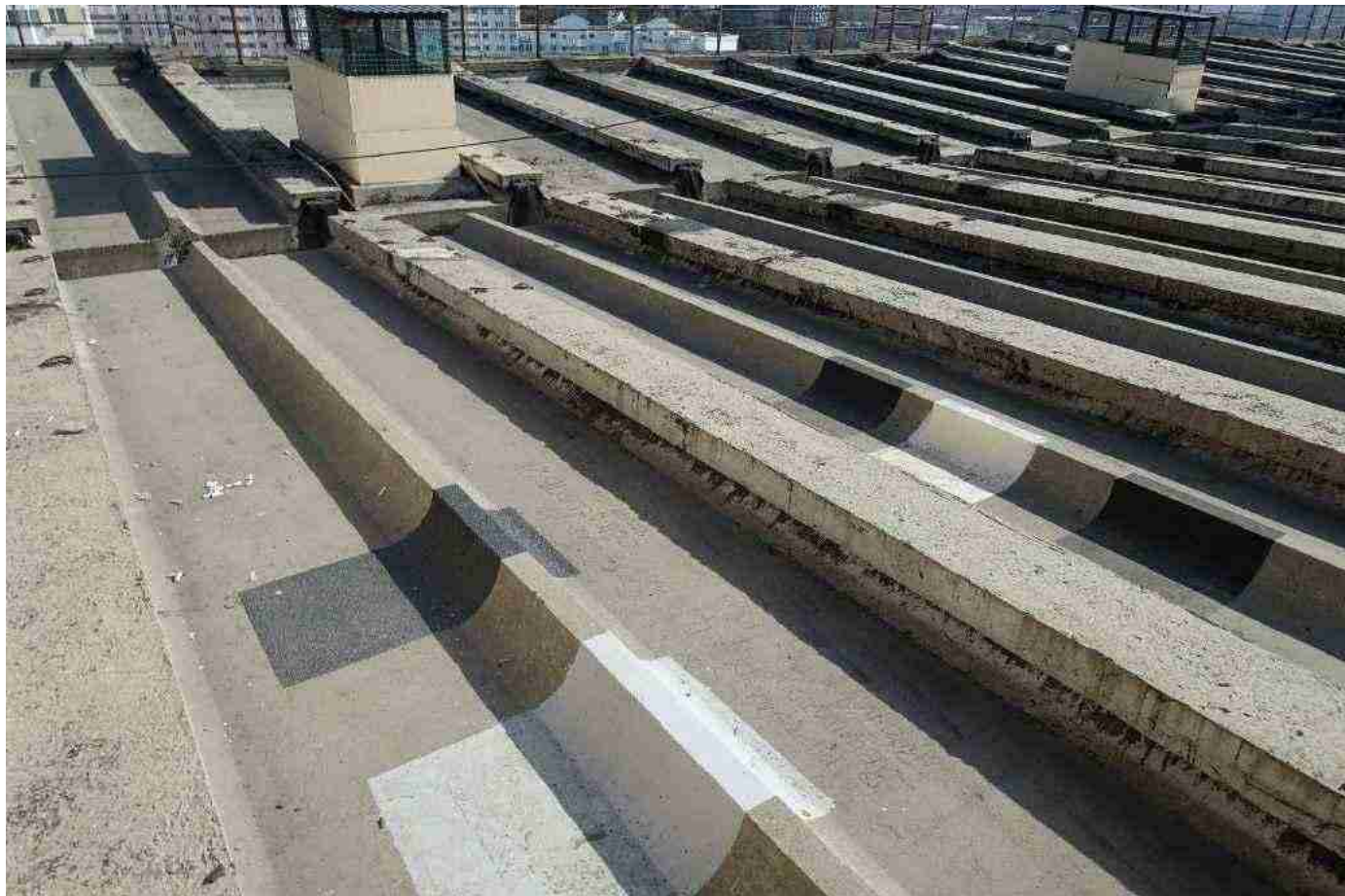
ь ото 6642т оррозия арматуры2пязрушение боковой части плиты покрытия2
