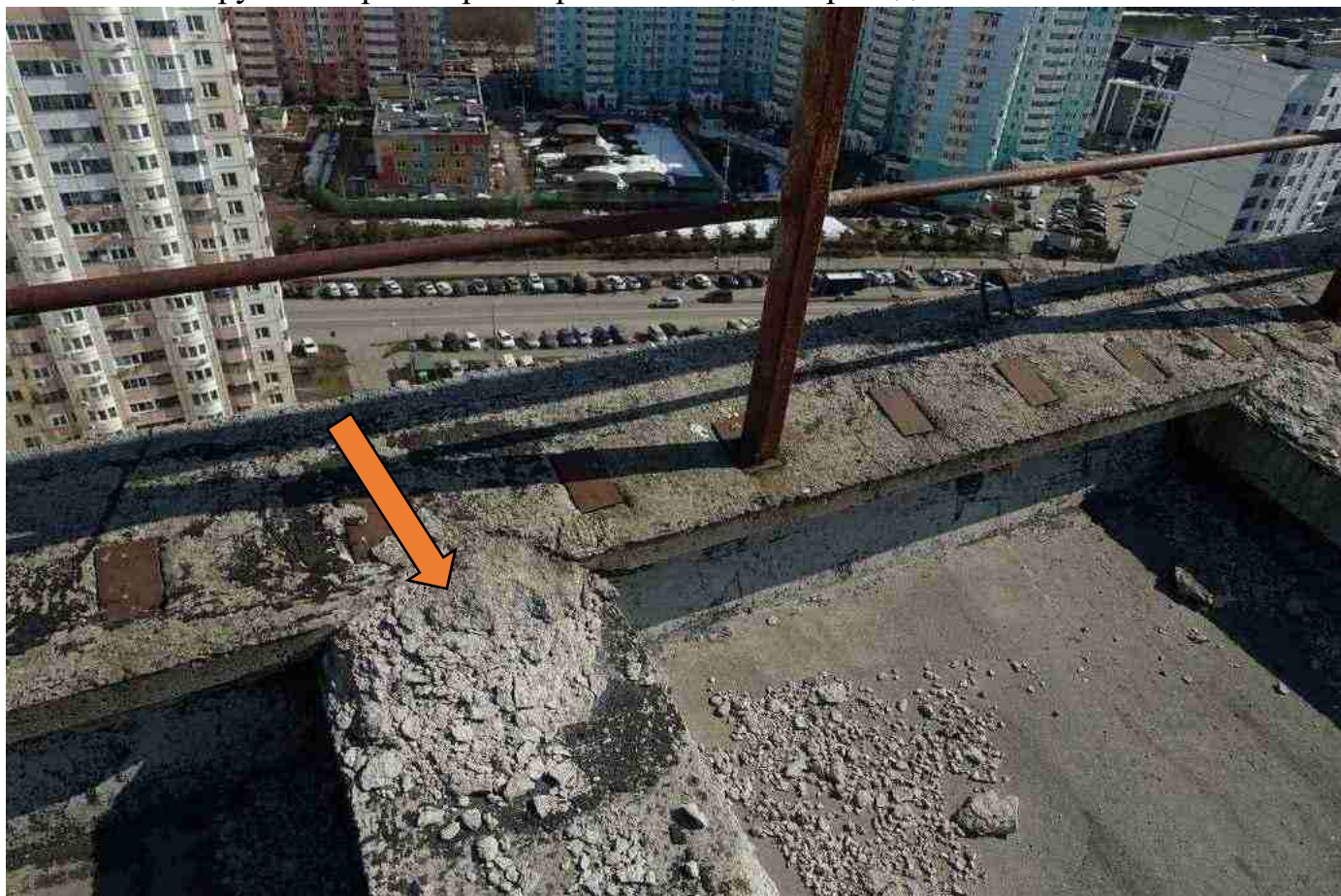
ь ото 5762щазрушение раствора0выравнивающего перепад на стыке плит2
