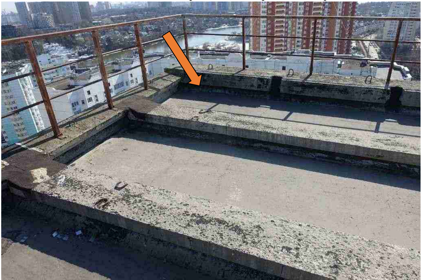
ь ото 5882ц бщий вид2ц бмазочная гидроизоляция не работает0стерлась2
