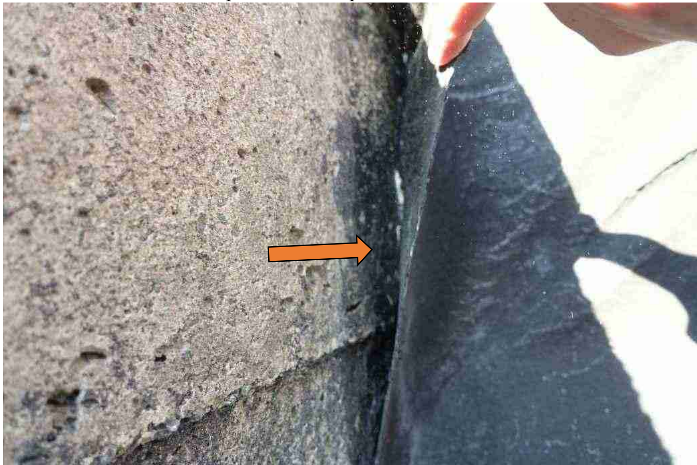
ь ото 6882х е качественно проклеенная гидроизоляция2
