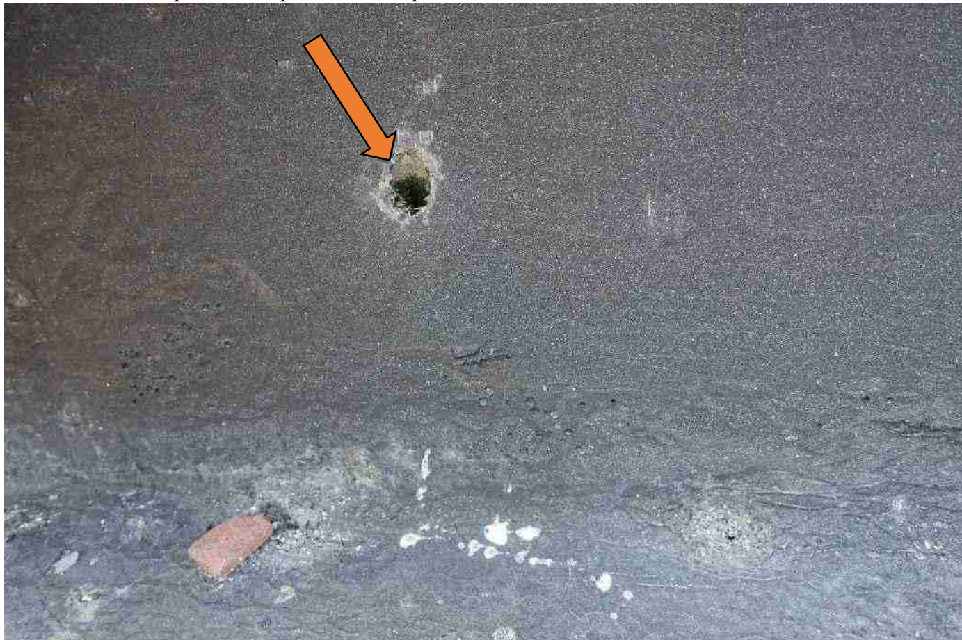
ь ото 67: 2х е качественно проклеенная гидроизоляция2
