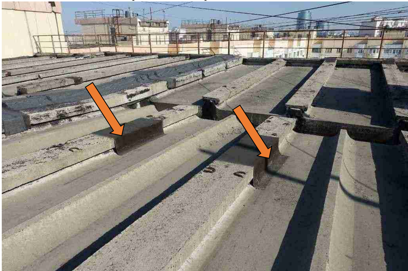
ь ото 6562х е качественно проклеенная гидроизоляция2
