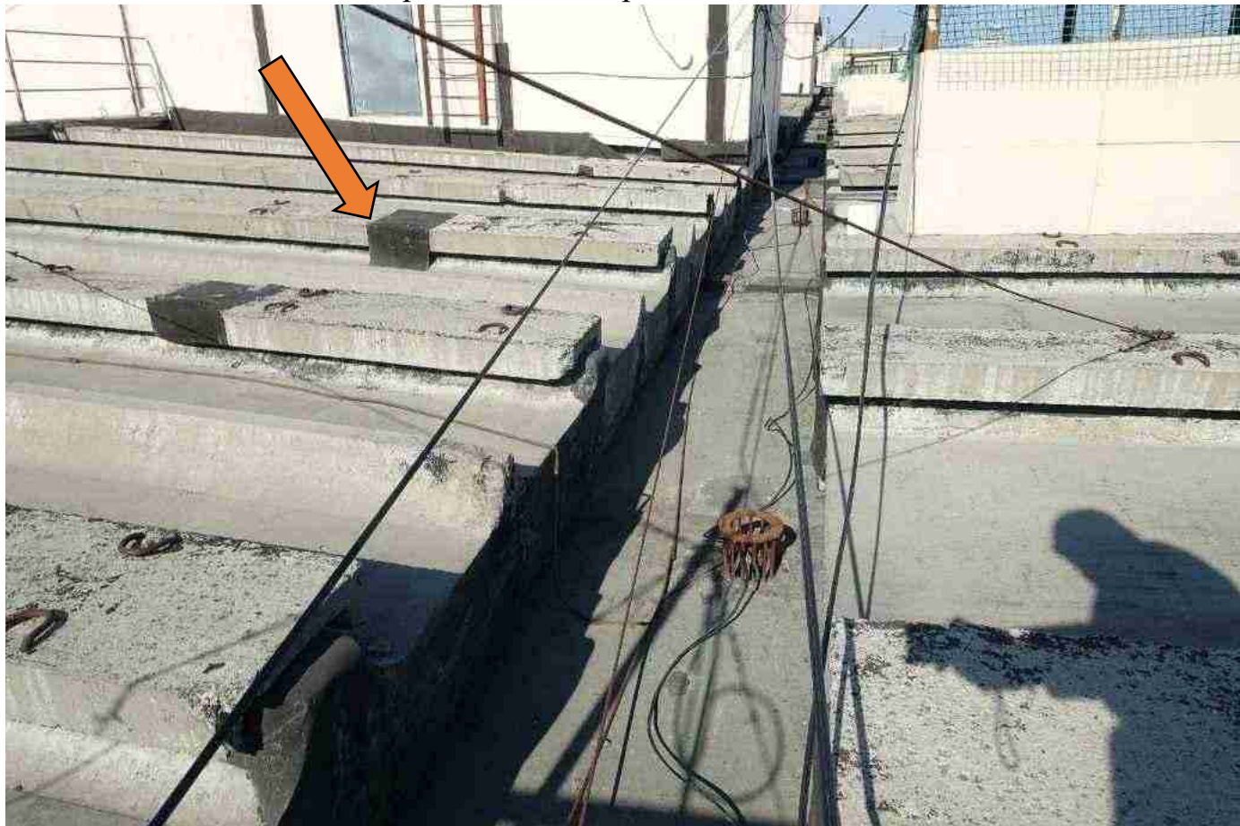
ь ото 5882у окально проклеенный участок гидроизоляцией2
